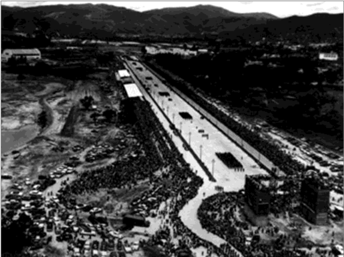
Vista del Monumento Triunfal en proceso de Construcción. www.arq.ucv.ve/~infodoc.452 - Parada Militar, Avenida los Próceres en construcción, Sin identificar, S/r, S/f
