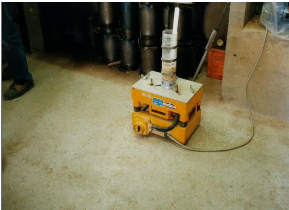
Foto 8.- Medición del espesor del filtro después decompactar
