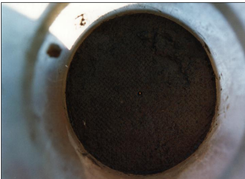
Foto 18.- Orificio de aguas arriba después del ensayo: obsérvese que está intacto
