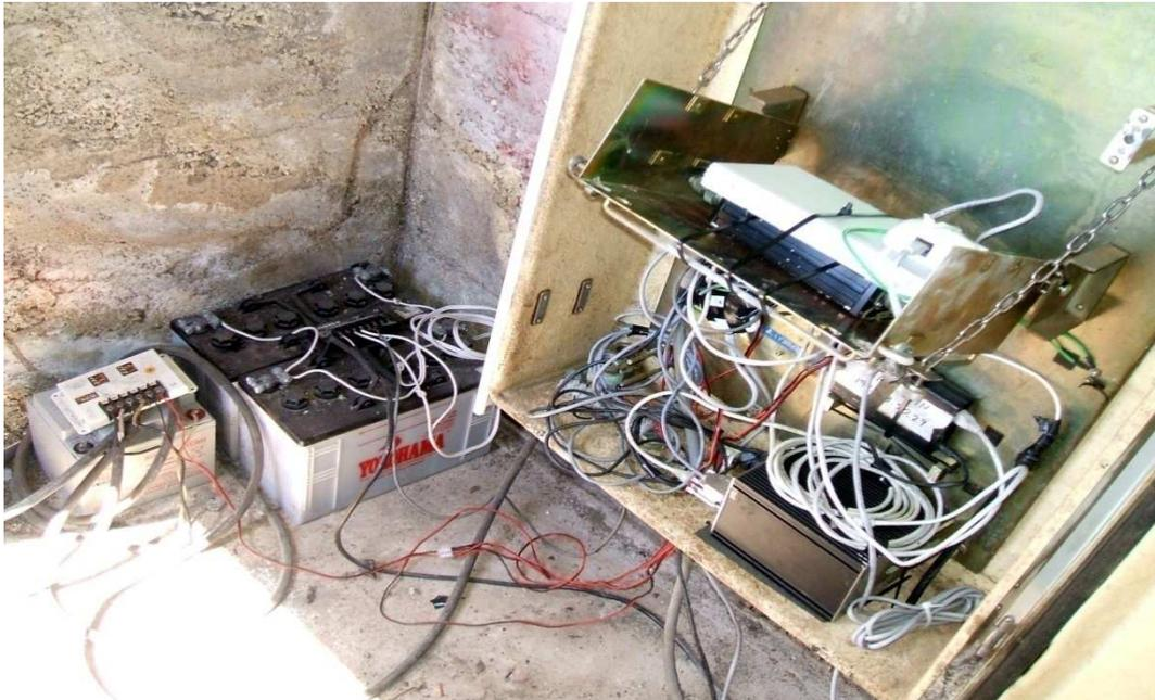
Fig. 3.25 Interior de una caseta sísmica, en donde se pueden observar las baterías que alimentan los equipos. Abajo a la derecha se observa la caja de color negro del sistema SEISCOM que procesa y recopila los datos, el radio transmisor y los convertidores digitales. Fuente Ligdamis Gtz.
