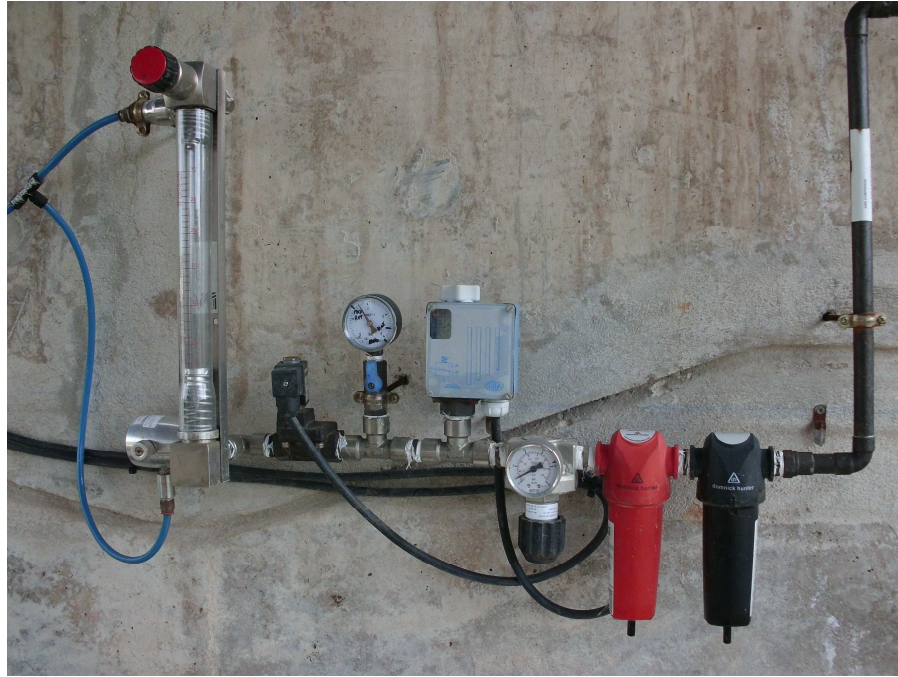
Figura 60. Fotografía del circuito de aire.
