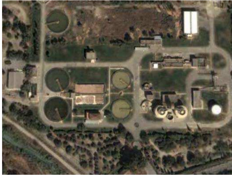
Figura 18. Vista aérea de la estación depuradora Oeste de Granada
