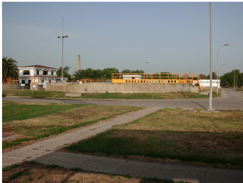
Figura 19. Esquema de la planta de tratamientos de aguas residuales donde se aprecia la conexión de la planta piloto de biorreactores de membrana a decantador primario.
