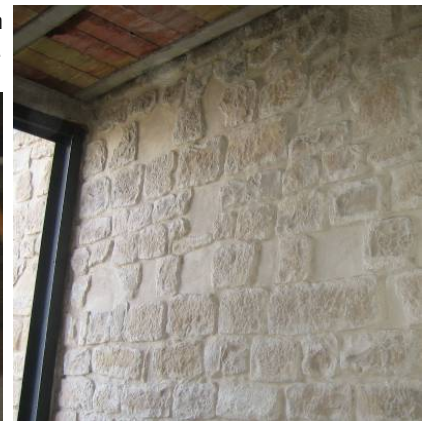
Fig. 416. Fábrica de mampostería consolidada, con lagunas restituidas en mortero de cal.
