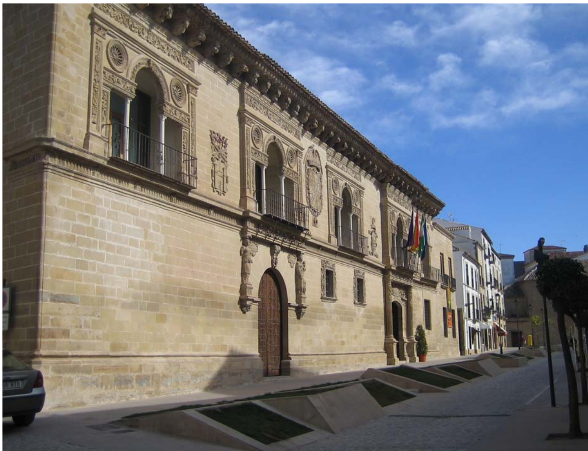
Fig. 507. Ayuntamiento. Fachada principal terminada la urbanización exterior.
