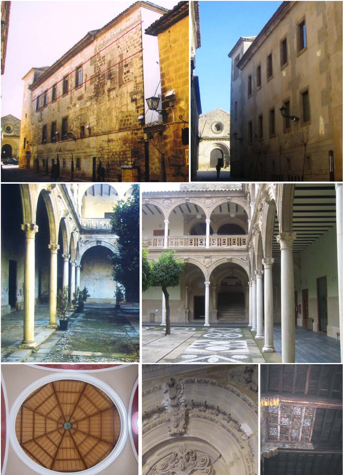
Figs.533 y 534. Palacio de Jabalquinto. Fachada norte. Estado previo y reformado. Figs.535 y 536. Patio. Estado previo y reformado con el nuevo pavimento y el revoco en color verde. Figs.537, 538 y 539. Bóveda de la escalera, detalle de reintegraciones en yeso en escalera, y artesanado "restaurado" en el que no se recupera la decoración ausente.
