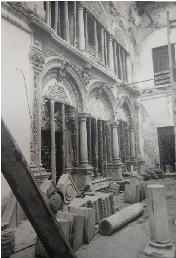
Figs.191-194. Palacio de Jabalquinto. Desmante de las arquerías del patio y colocación forjados metálicos. AELL.
