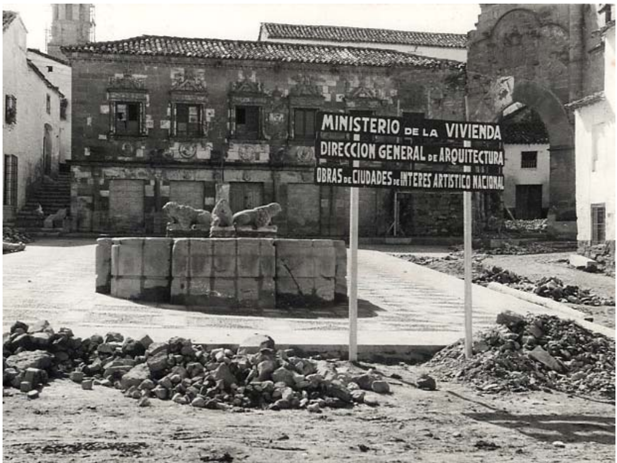
.....Obras en la plaza de los Leones. 1960. AGA, IDD (4) 117 caja 51/11657.
