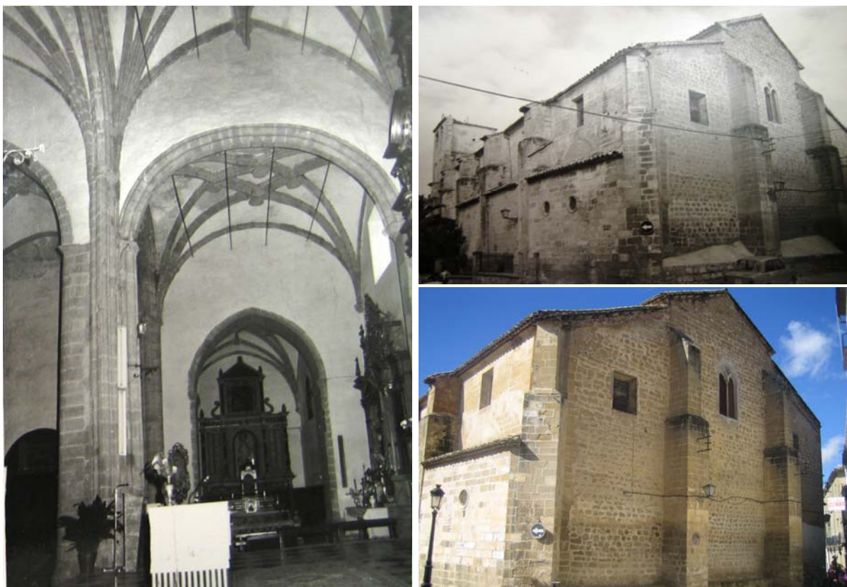
Fig.247. Iglesia de San Pablo. Bóvedas con tirantes metálicos, ahora eliminados. AELL.
