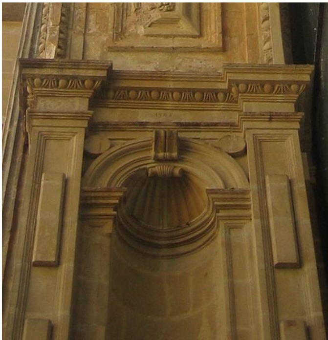
Fig.131. Restitución de motivos decorativos con "sólidos capaces" e incisión de fecha en moldura superior (1965).
