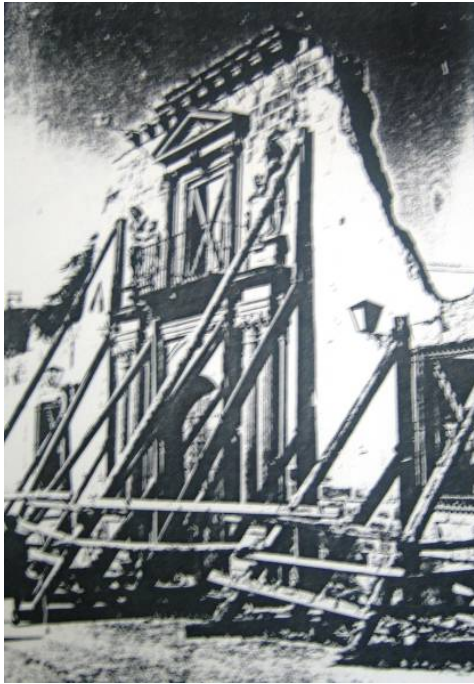
Figs.387 y 388. Palacio de los Elorza. Apeo de los restos y diseño de proyecto.
