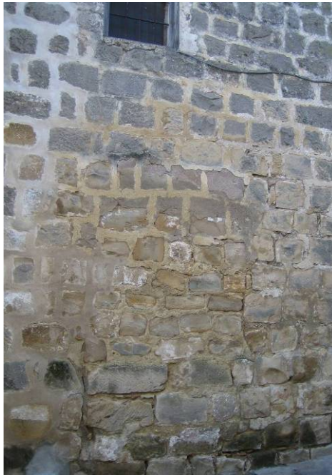
Fig.84. Catedral. Acceso a la torre desde el exterior. Archivo Narváez Olivera.
