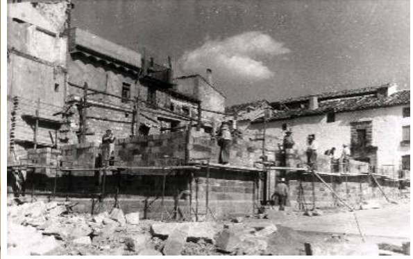
Fig.294. Construcción del nuevo edificio de las Carnicerías. AGA, IDD (4) 117 caja 51/11657.
