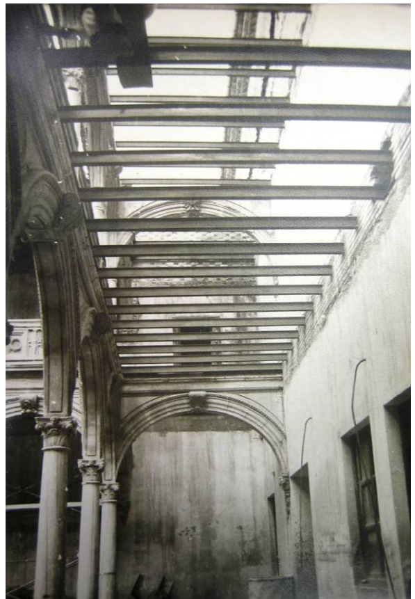
Figs.191-194. Palacio de Jabalquinto. Desmante de las arquerías del patio y colocación forjados metálicos. AELL.
