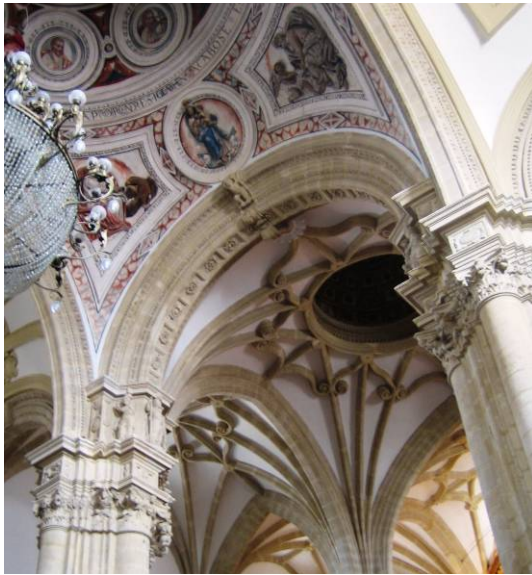
Fig. 7. Catedral. Detalle de la bóveda de la capilla mayor y del enlace entre las dos estructuras.
