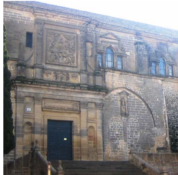
Fig. 8. Catedral. Detalle de la nueva portada y serlianas sobre el muro gótico preexistente.
