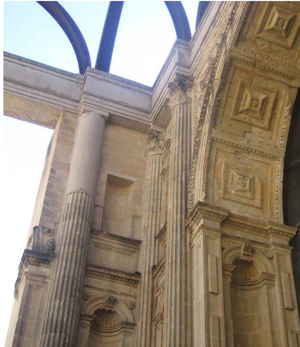
Figs.431 y 432. Pilastras restituidas en hormigón armado y hornacina simplificada para completar la altura. Fig. 433. San Francisco. Apoyo de la nueva estructura. Se observa la grieta abierta en el muro.
