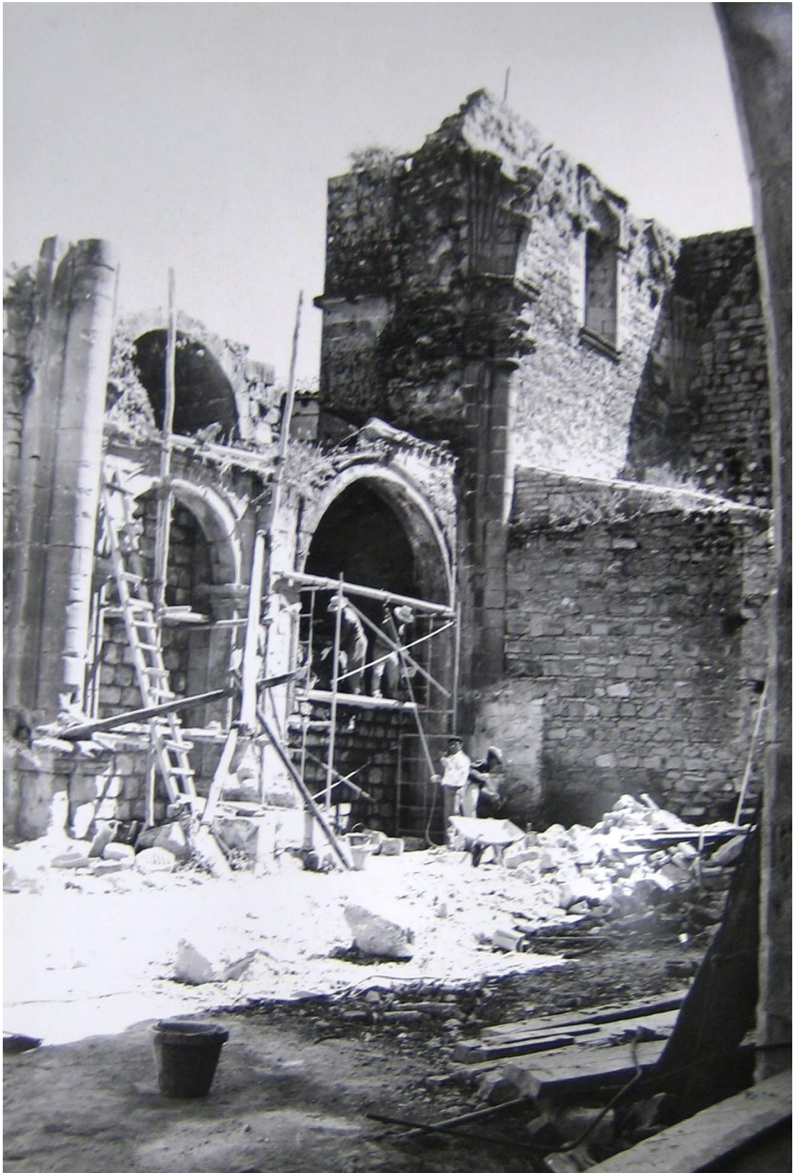
Obras en las ruinas de la iglesia del Salvador. AELL.
