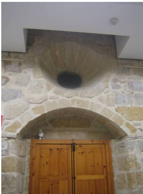
Fig.492. Sala de exposiciones. Separación de falsos techos de la fábrica antigua.
