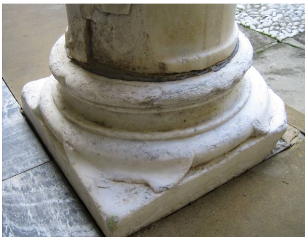
Fig.200. Base de columna con chapa de plomo.
