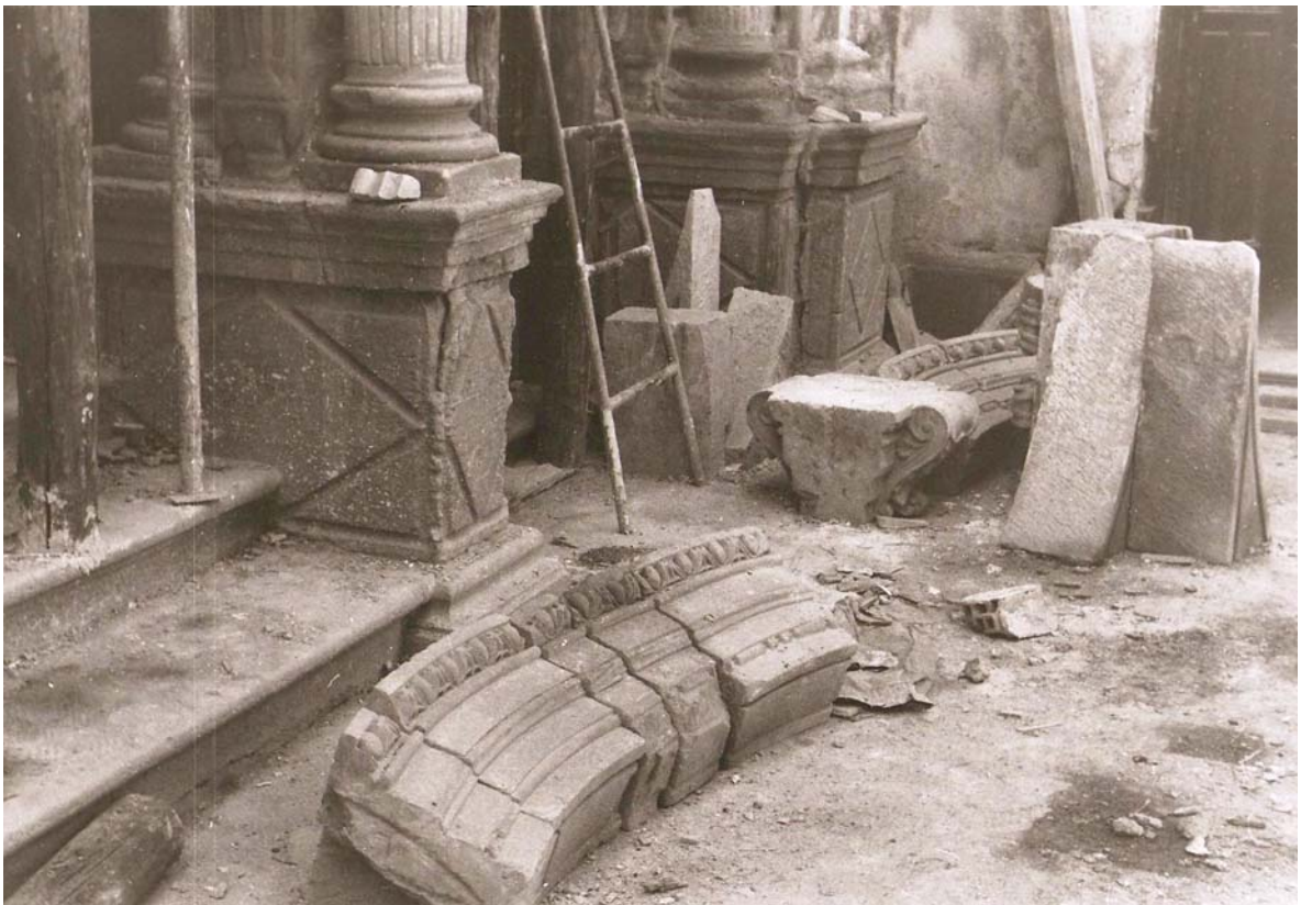
Palacio de Jabalquinto. Obras en el claustro. AELL.
