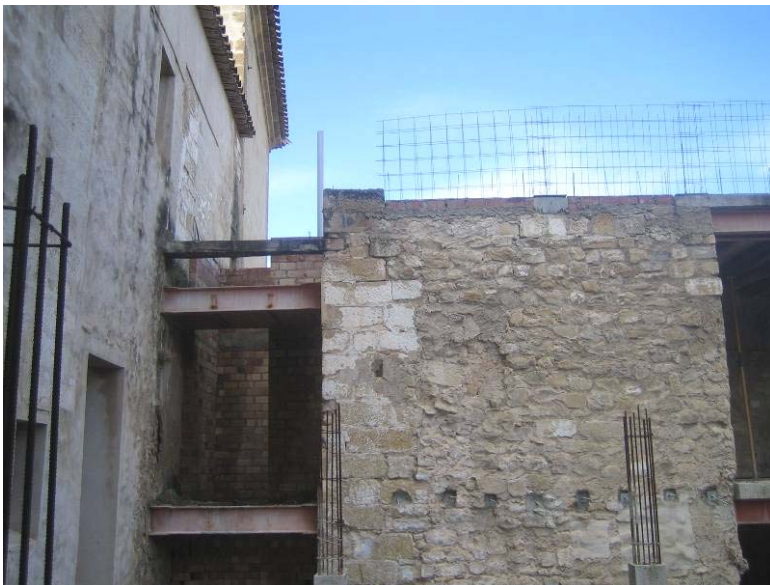
Fig. 418. Nueva estructura en edificio calle Sacramento, que apoya en muro posterior de la edificación principal.
