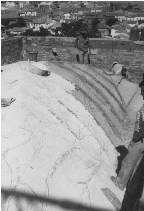
Fig.234. Casas Consistoriales Altas. Taqueado de la grieta longitudinal con sillares.
