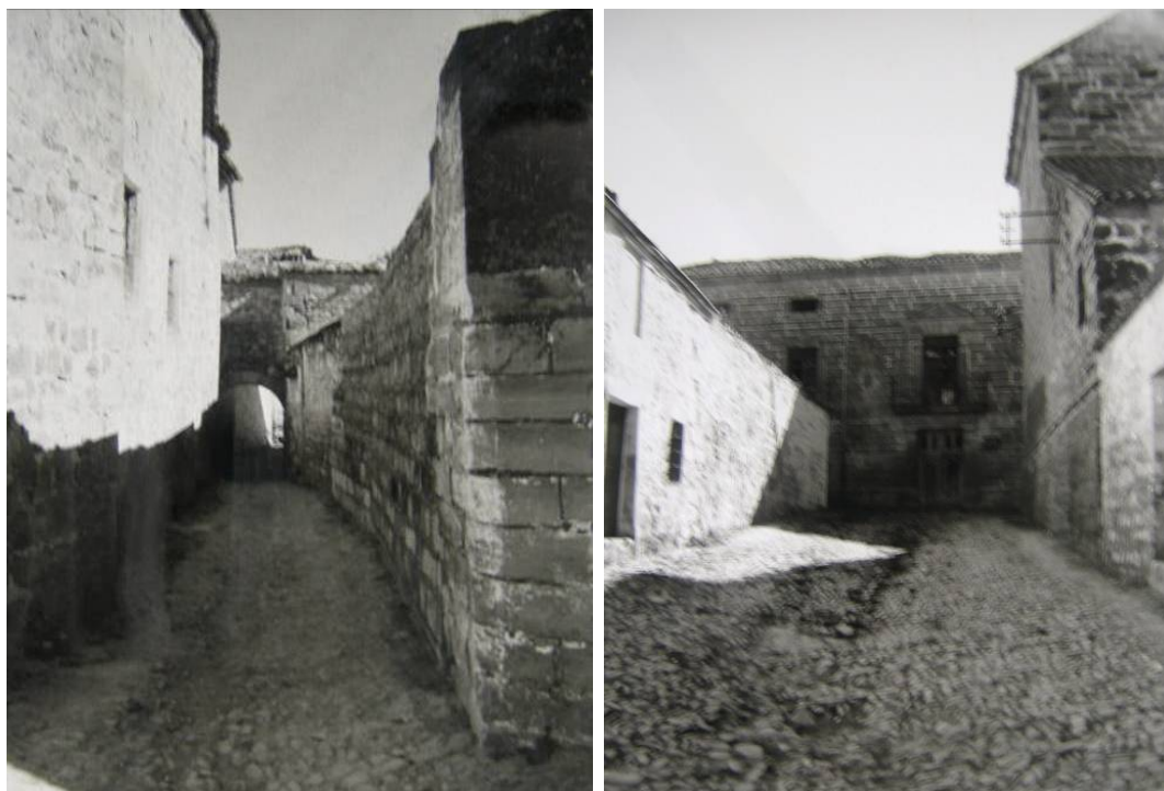
Figs.280 y 281. Recorrido alrededor de la Catedral. Antes de las obras. 1975. AELL, expediente nº441.
