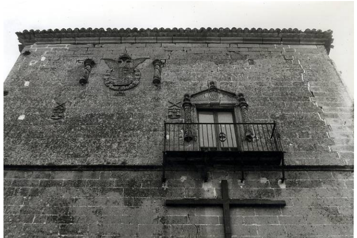
Figs. 230 y 231. Casas Consistoriales Altas. Cuerpo alto antes de la intervención. Se observa la grieta longitudinal que recorre la fachada. AGA, IDD (3)115 caja 26/0173.
