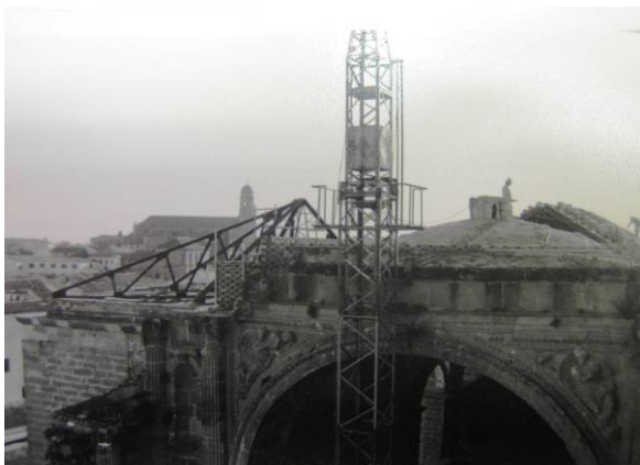
Figs.157 y 158. San Francisco. Obras de colocación de cercha en cubierta y de restauración de portada principal. AELL.
