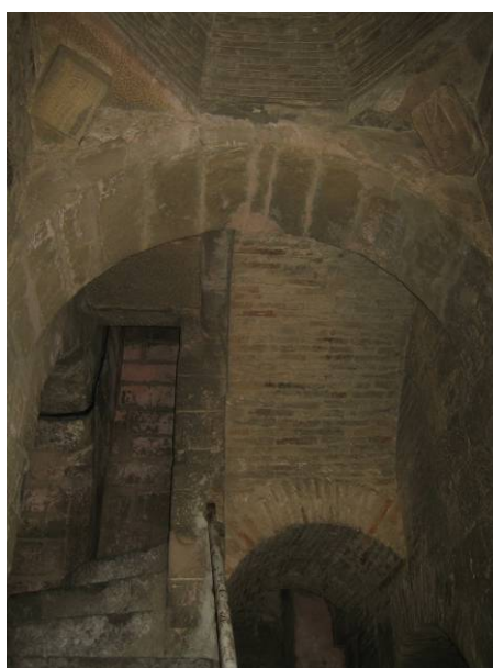
Fig.86. Torre de la Catedral. Fábrica de sillería completada por el interior con ladrillo.
