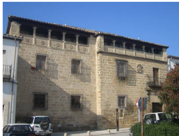
Fig.341. Antiguo Hospital de San Antonio Abad. Estado actual con la galería añadida.
