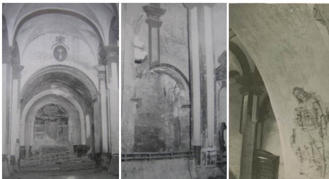
Figs.96 y 97. Interior de la iglesia de Santa Cruz antes de su restauración. AFVM. Fig.98. Aparición de columna primitiva bajo el revestimiento. AGMC, expediente 88.812 nº5.
