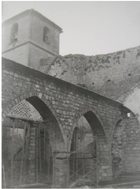
Figs.183 y 184. El Salvador. Obras de cubierta y apertura de arcos. Se puede ver la nueva estructura de madera AELL.
