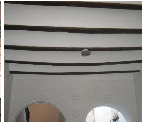
Fig.468. Detalle de forjados y arcos de escalera.
