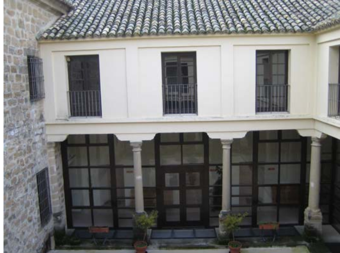
Fig.523. Seminario. Nueva disposición de forjados imitando los originales.
