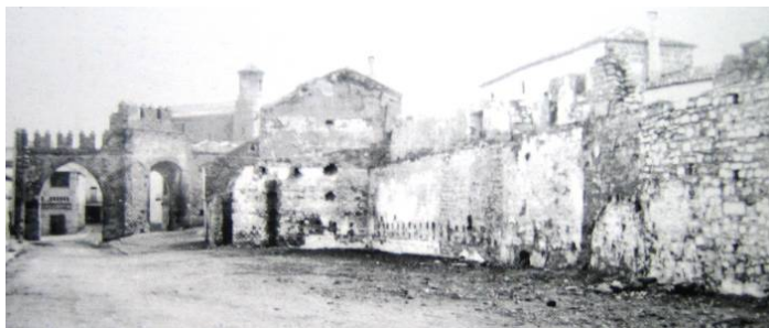
Fig. 299. Espacio dejado por las Carnicerías. AFVM. Fig. 300 Estado actual con jardines junto a la muralla.
