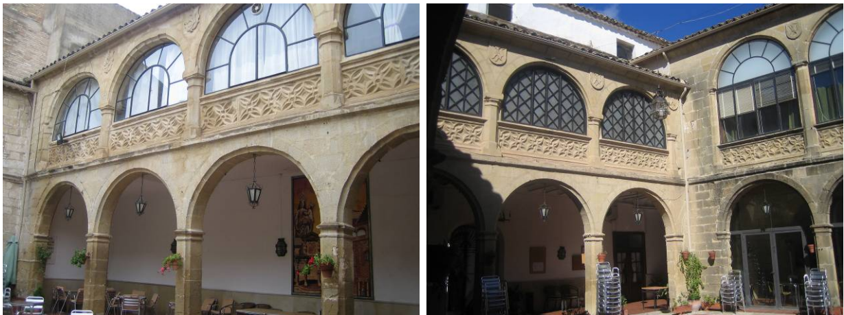
Figs. 209 y 210. Palacio de los Cerones. Estado actual. El patio una vez completado con la arcada que faltaba en el ala oeste y rebajada la altura en el ala este.
