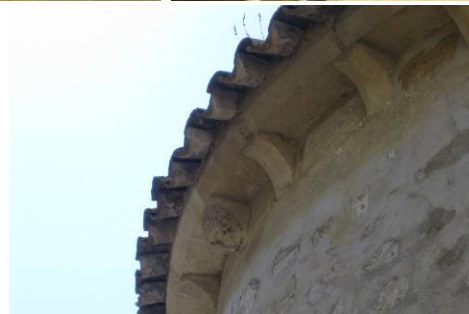
Fig.105. Detalle cornisa en esquina fachada Sur.
