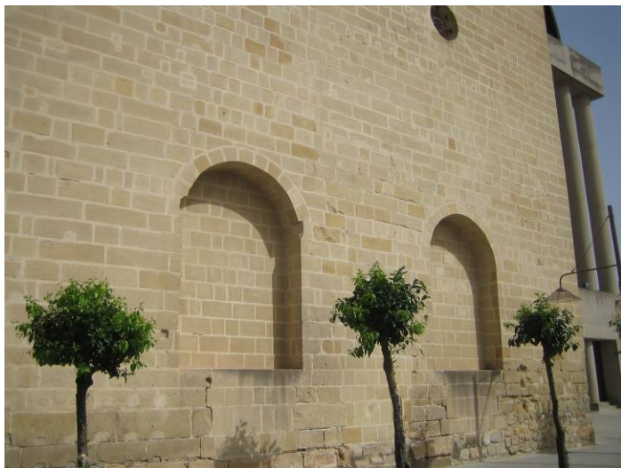
Fig.440. San Francisco. Detalle fachada lateral zona del crucero.
