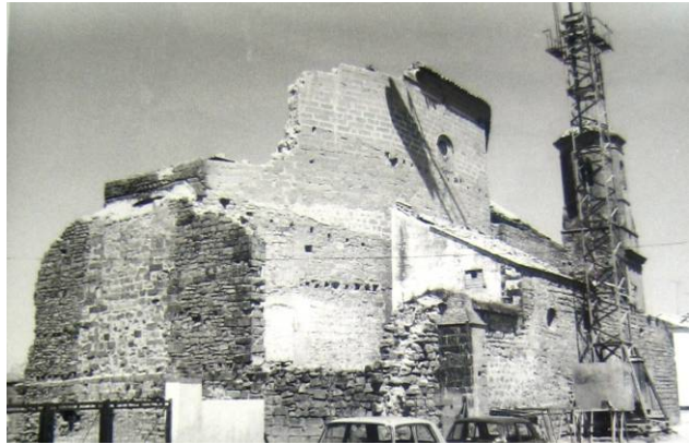
Fig.218. Iglesia de los Trinitarios Descalzos. Estado de los muros después de la caída de la cubierta. 1974. AHPJ, Comisiones de Patrimonio 1990, caja 55261 expediente 1.
