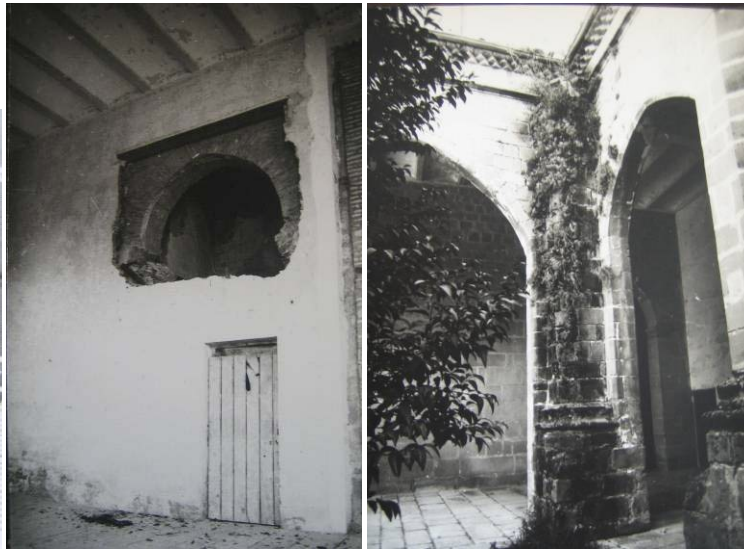
Fig.90. Obras de restauración del claustro de la Catedral. Se ve el muro construido delante de las capillas para apoyo del forjado. AFVM.
