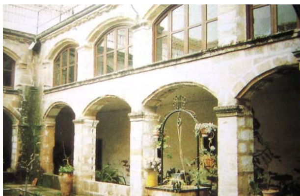
Fig.386. Estado actual del claustro
