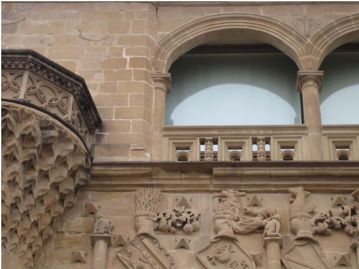
Fig. 540. Detalle de la fachada principal del palacio de Jabalquinto. Se ven las marcas de las desaparecidas cubiertas de los balconillos así elementos pétreos conservados con sus faltas, y la nueva balaustrada copiada de la del patio.
