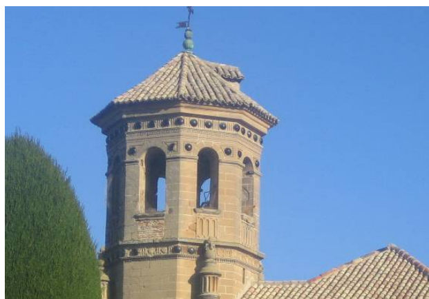
Fig.361. Iglesia de San Juan Evangelista. Se observa el pretil en ladrillo que se mantiene en la intervención.
