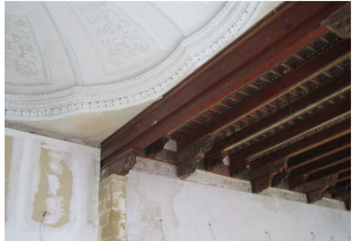
Fig.502. Pórtico interior durante las obras.
