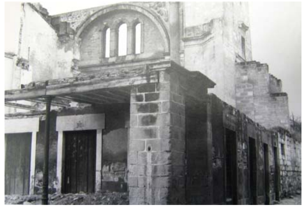
Fig.36 Parte delantera del presbiterio. Se observa un hueco en la parte superior de los arcos. Catálogo de Monumentos de la provincia de Jaén . 1913-15. BLIEG.
