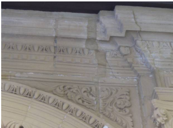
Fig.198. Reintegración con mortero en escalera.
