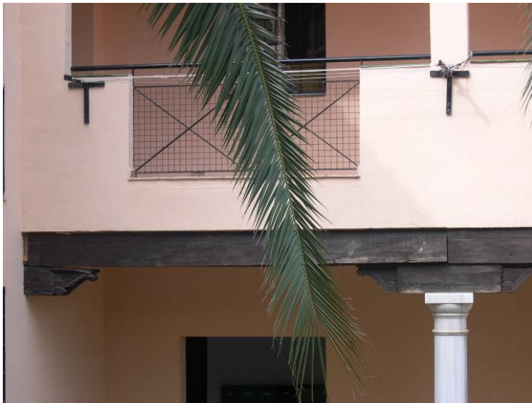
Fig.469. Detalle del patio con falsa viga de madera ocultando la metálica.
