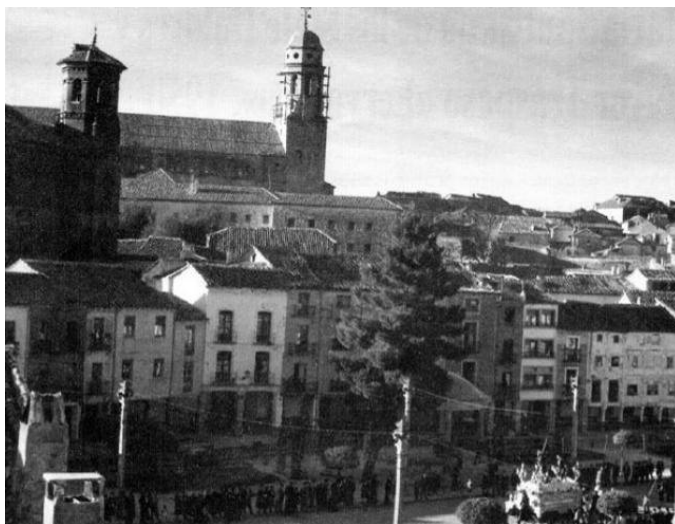
Fig.76. Torres de la Catedral y la Universidad. Se pueden ver los andamios colocados durante la construcción de la torre. Aproximadamente 1959. www.ideal.es
