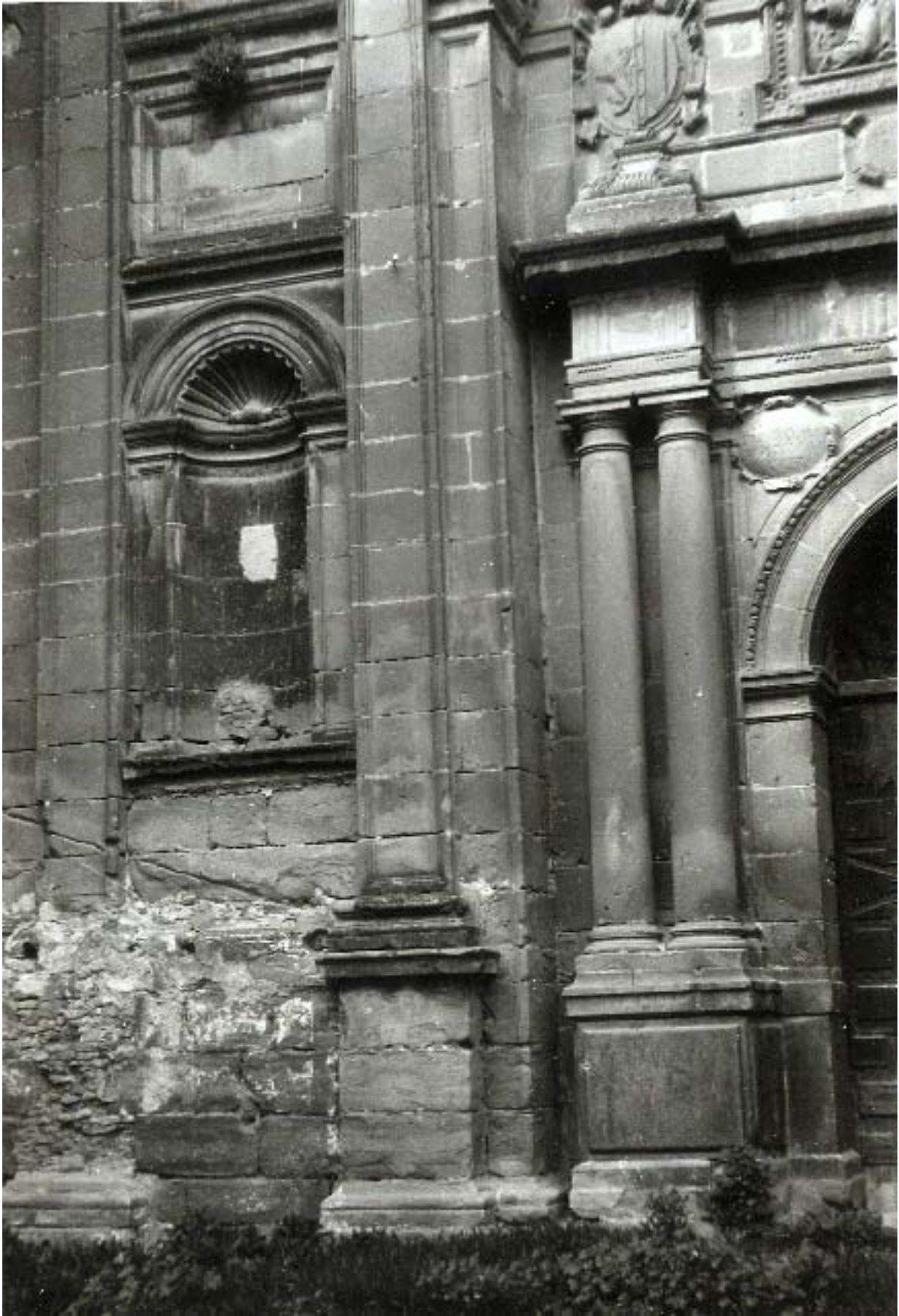
Detalle de la puerta de San Francisco. 1961. AGA, IDD (4)117 caja 51/11761.
