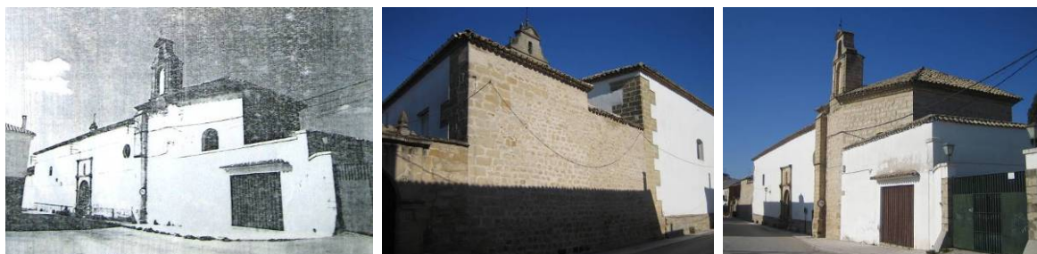
Fig.355. Convento de San Antonio. 1980. AHMB, obras 1955-82 edificios religiosos. Figs. 356 y 357. Estado actual. Se ha subido el muro sobre el portón y eliminado el encalado de parte de sus muros.
