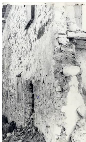
Fig.314. Muro desplomado.
