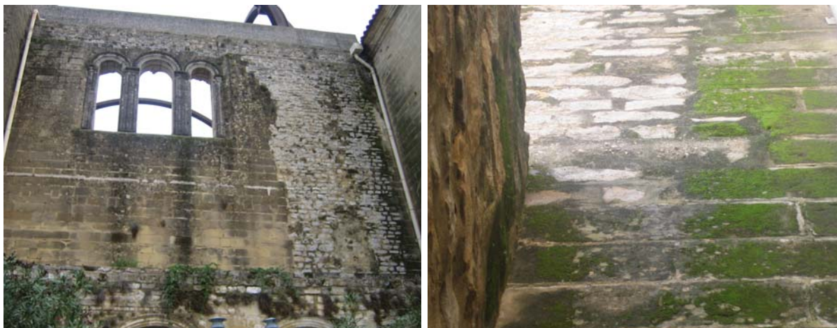
Figs.40 y 41. Ruinas de San Francisco. Intervención de Torres Balbás en la parte posterior del presbiterio. Vista general de la fábrica de mampostería y detalle de la viga de hormigón armado.
