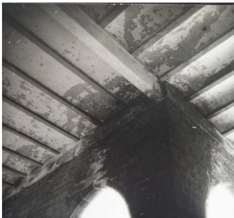
Fig.90. Obras de restauración del claustro de la Catedral. Se ve el muro construido delante de las capillas para apoyo del forjado. AFVM.
