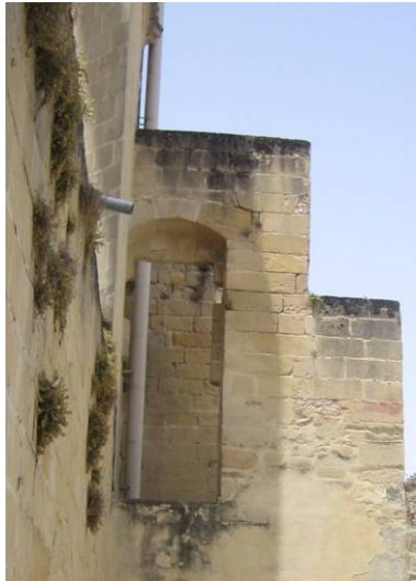
Fig. 437. San Francisco. Detalle de bajantes y gárgolas. Fig. 438. Crucero.
