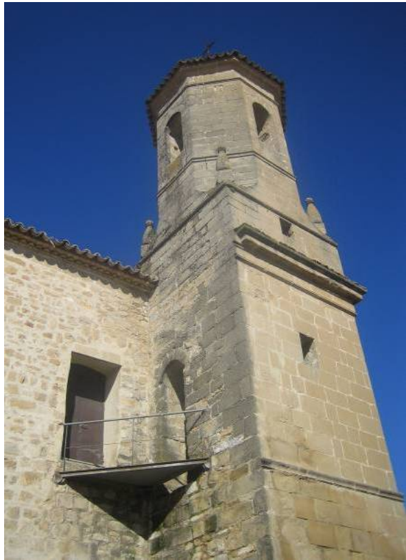
Fig. 404. Iglesia de los Trinitarios Descalzos. Estado reformado. Nuevo acceso a la torre mediante una pasarela de acero.
