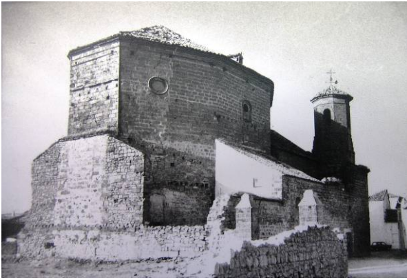
Fig.218. Iglesia de los Trinitarios Descalzos. Estado de los muros después de la caída de la cubierta. 1974. AHPJ, Comisiones de Patrimonio 1990, caja 55261 expediente 1.
