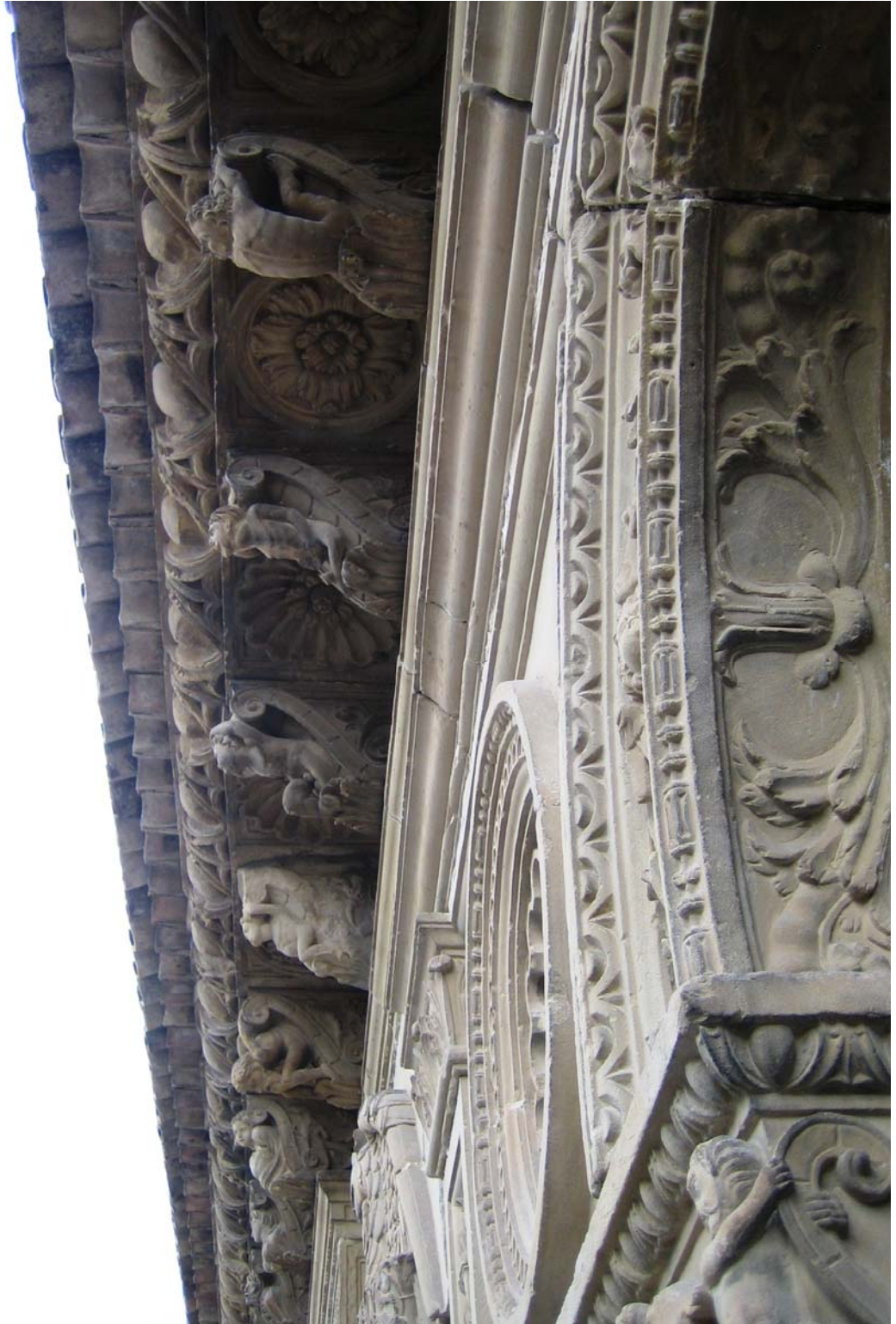
Cornisa del Ayuntamiento. Detalle.
