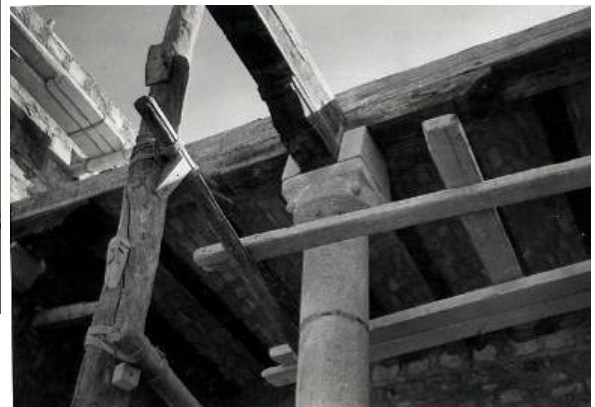
Fig.298. Detalle del entramado de piso. Proyecto de traslado de edificio del siglo XVI. AHMB expedientes 1961, carpeta 86.
