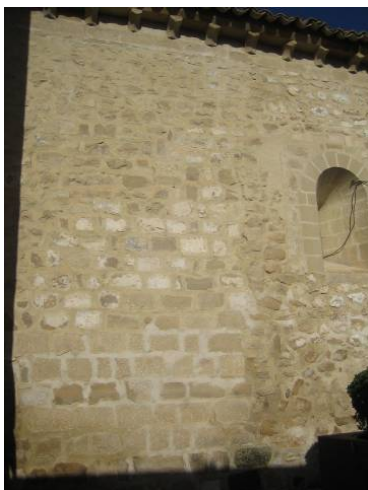
Fig.371 Iglesia de Santa Cruz. Paño restituído al demoler la sacristía.
