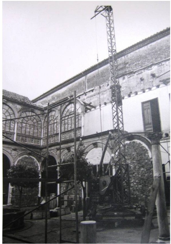
Figs.191-194. Palacio de Jabalquinto. Desmante de las arquerías del patio y colocación forjados metálicos. AELL.
