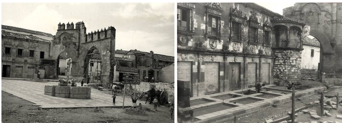
Figs.310 y 311. Obras en la Casa del Pópulo y la plaza en distintos momentos. A la izquierda se observa el balcón ya demolido y el nuevo cilindro construido en el arco. A la derecha, obras de pavimentación de la plaza, donde todavía no se ha demolido el tambor del balcón. 1960. AGA, IDD (4) 117 caja 51/11657.
