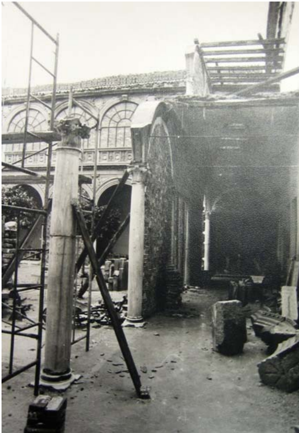
Figs.191-194. Palacio de Jabalquinto. Desmante de las arquerías del patio y colocación forjados metálicos. AELL.
