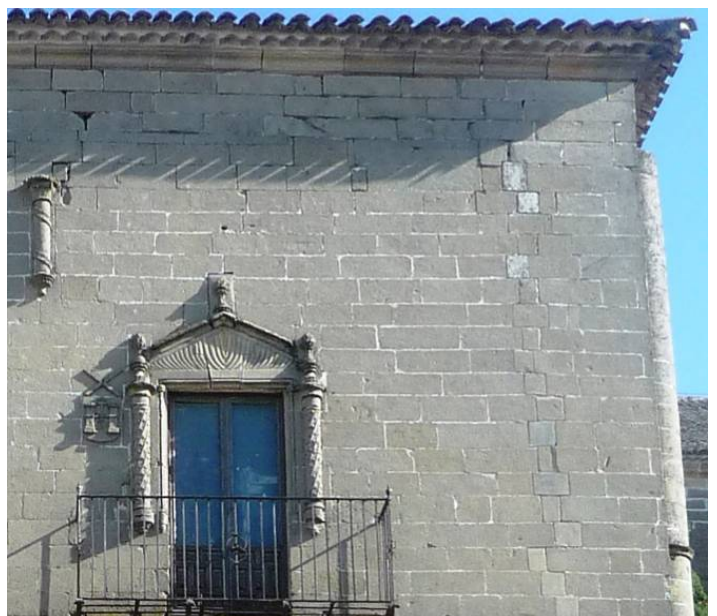
Fig.234. Casas Consistoriales Altas. Taqueado de la grieta longitudinal con sillares.
