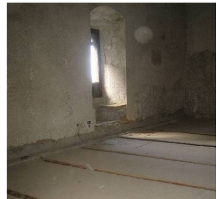
Fig. 417. Forjado consolidado con cajeadado en la fábrica antigua para empotrar la nueva capa de compresión del forjado.
