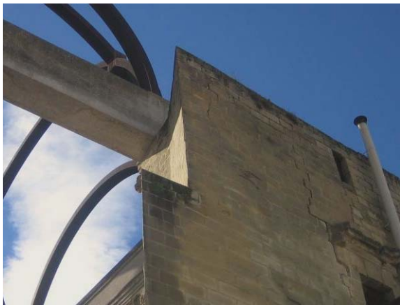
Figs.431 y 432. Pilastras restituidas en hormigón armado y hornacina simplificada para completar la altura. Fig. 433. San Francisco. Apoyo de la nueva estructura. Se observa la grieta abierta en el muro.
