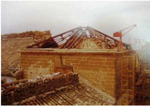
Figs.196 y 197. Palacio de Jabalquinto. Estructura metálica de cubierta de la escalera y fachada principal con la galería apuntalada. AELL.
