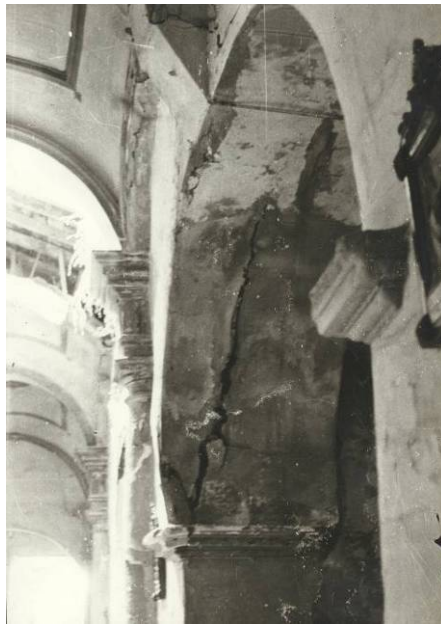
Fig.175. Parte de la bóveda caída del fondo deja ver la estructura. 1970. AGA, IDD (3)115 caja 26/174.
