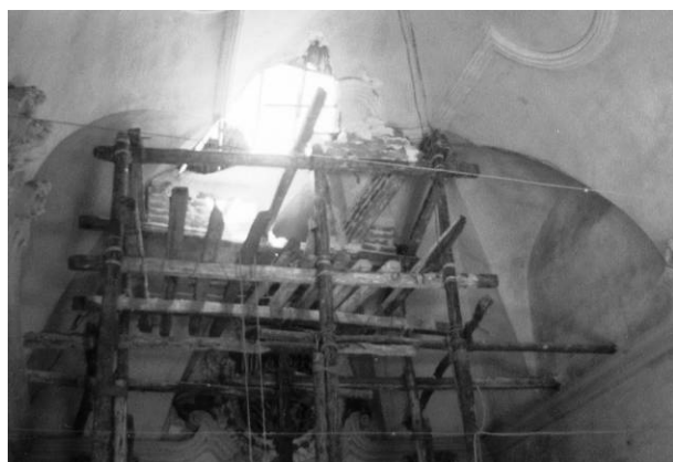
Fig.235. Apeo de la bóveda realizada con tabicónes. AELL.
