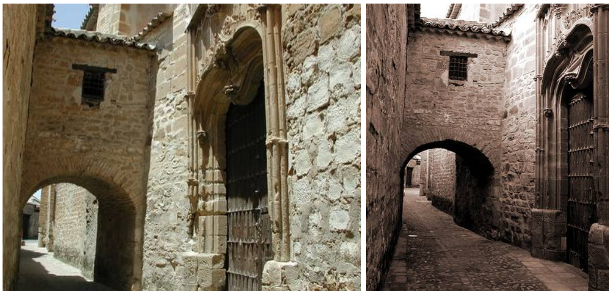
Figs.428 y 429. Puerta del Perdón, antes y después de la restauración.
