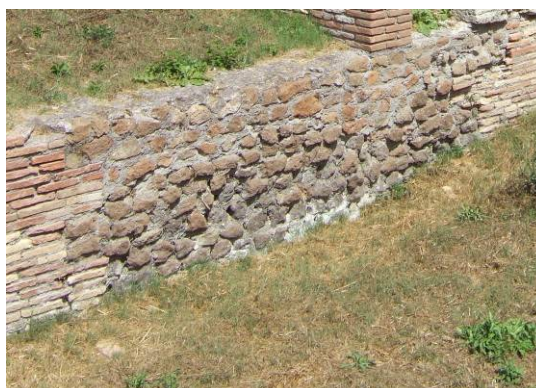
Fig. 399. Opus incertum , muro de mampostería del portico del tetto spiovente en Ostia Antica.
