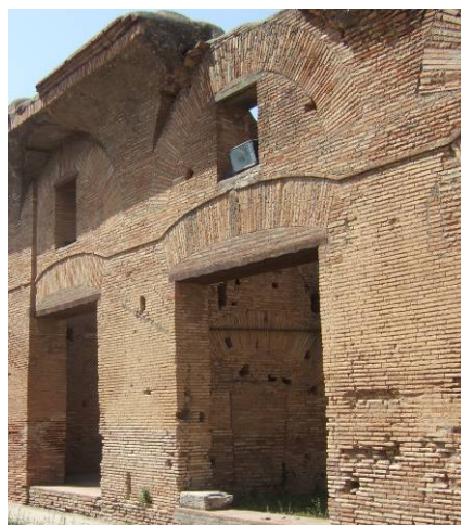
Fig. 403. Opus testaceum , muros del teatro Ostia Antica.
