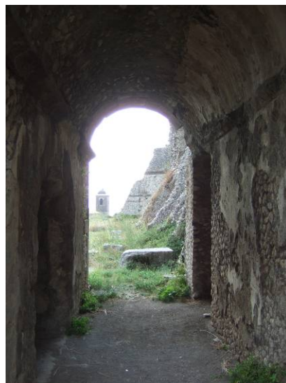
Fig. 232. Ninfeo bajo la estructura de la escalera en el santuario de la Fortuna Primigenia en Palestrina.
