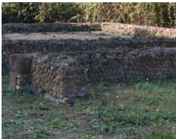
Fig. 400. Opus quasi reticulatum , muros del área de los quattro tempietti in Ostia Antica.
