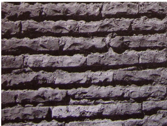
Fig. 410. Uso de ladrillos descantillados para el relleno de lagunas de algunos edificios de Ostia Antica. 812
