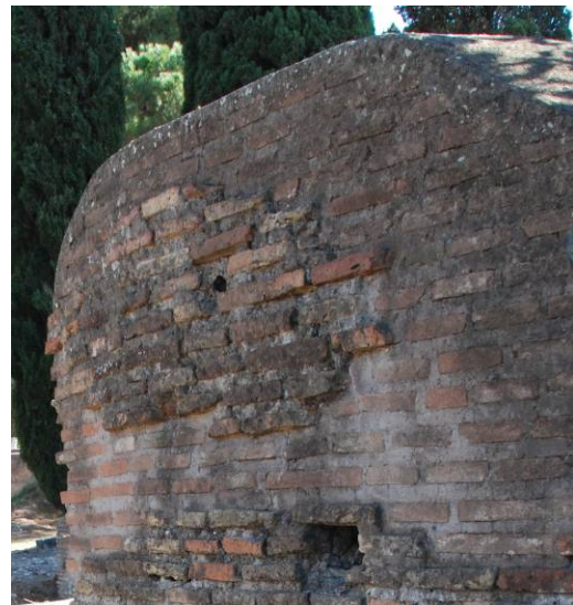
Fig. 409. Fábrica original rodeada por chapados de ladrillo nuevo en el ninfeo del decumanus de Ostia Antica.
