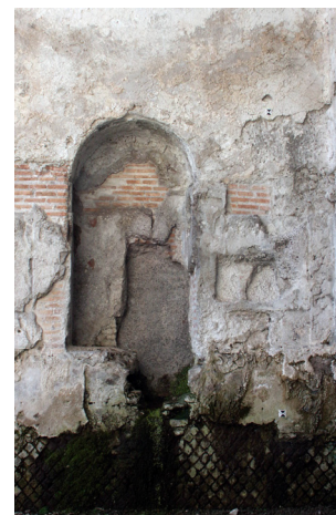
Fig. 688. Trazas del mármol sobre el mortero.
