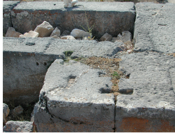
Fig. 223. Detalle de los huecos para grapas en doble cola de milano. 393
