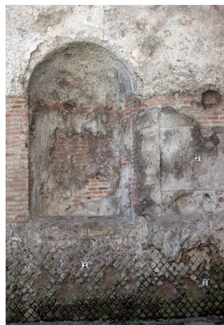
Fig. 688. Trazas del mármol sobre el mortero.
