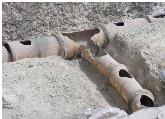
Fig. 459. Ramal de distribución de agua del acueducto de Pisístrato. 877
