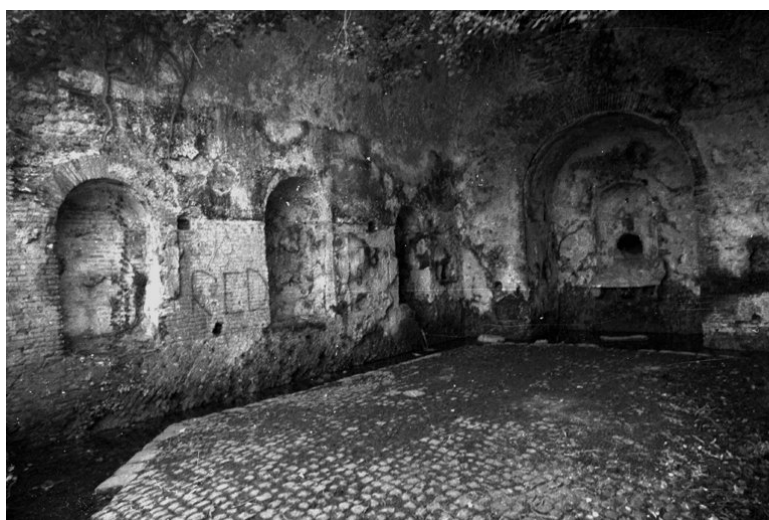
Fig. 633. Imágenes del estado del ninfeo antes de la intervención de 1999. 1221
