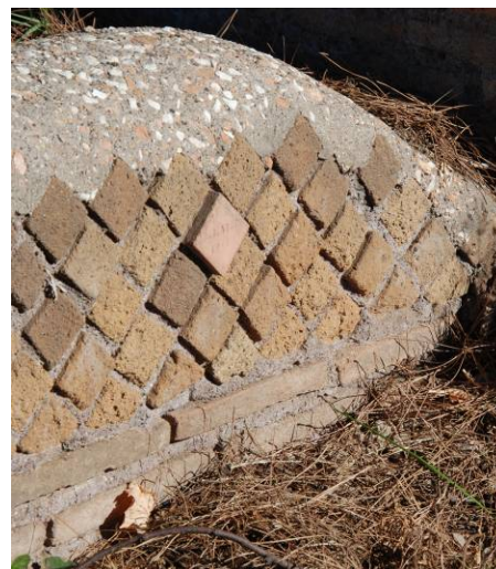
Fig. 413. Reconstrucción de un muro de opus reticulatum en Ostia Antica. 815
