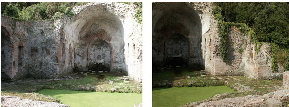
Fig. 655. Imágenes de los muros frontales donde hubieran entestado las bóvedas laterales.
