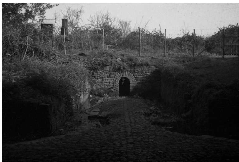
Fig. 631. Imágenes del estado del ninfeo antes de la intervención de 1999. 1219
