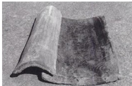
Fig. 277. Tegula e imbrex de cubierta laconia 563
