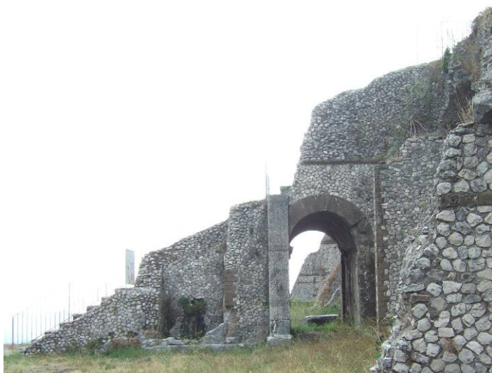
Fig. 231. Ninfeos en la estructura de la escalera de acceso a los niveles superior desde la terraza de los hemiciclos del santuario de la Fortuna Primigenia en Palestrina.
