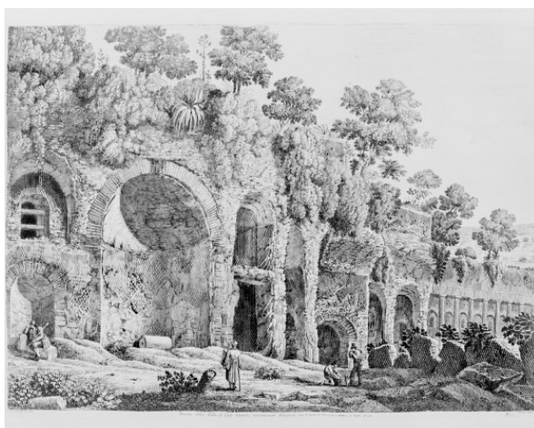
Fig. 164. Restos del cuerpo central, de la terraza media de la villa di Bruto en Tivoli hacia 1826. 298
