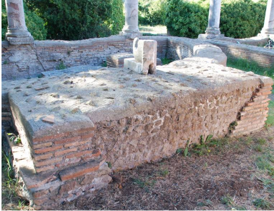
Fig. 406. Remate de mortero del muro y relleno nuevo del núcleo de uno de los ninfeos gemelos a los lados del teatro de Ostia Antica.
