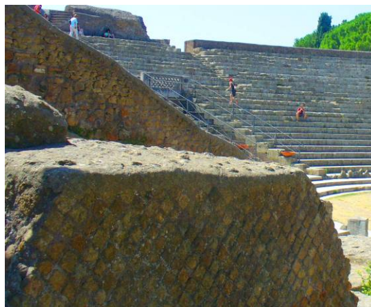
Fig. 401. Opus reticulatum , muros del teatro Ostia Antica.
