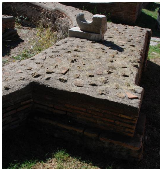
Fig. 385. Remate de mortero con fragmentos de ladrillo y tufo en uno de los ninfeos gemelos junto al teatro en Ostia Antica.
