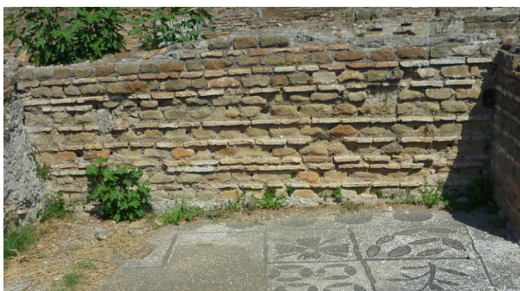
Fig. 404. Opus listatum , muros que alternan hiladas de mampuestos de tufo con otras de ladrillo, Ostia Antica.
