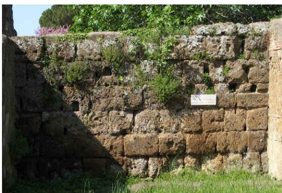
Fig. 398. Opus quadratum , muro de sillería del castrum primitivo de Ostia Antica.
