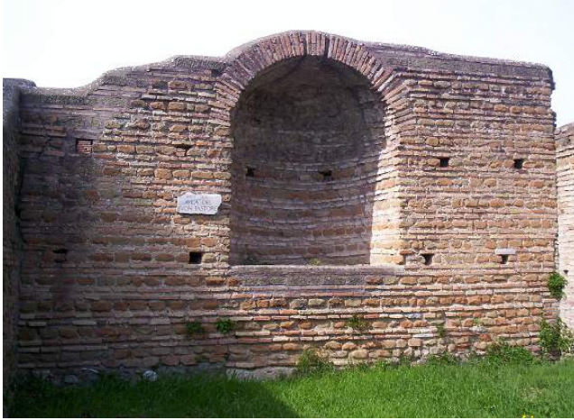
Fig. 466. Alzado del aula del buon Pastore de Ostia Antica con mechinales para andamios. 884
