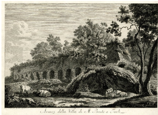
Fig. 161. Avanzi della Villa di M. Bruto a Tivoli. Malerisch radirte Prospekte aus Italien. Restos de uno de los extremos de la terraza central de la villa di Bruto en Tivoli hacia 1878. 294
