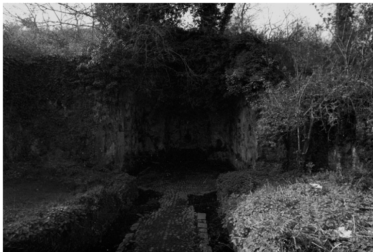
Fig. 632. Imágenes del estado del ninfeo antes de la intervención de 1999. 1220
