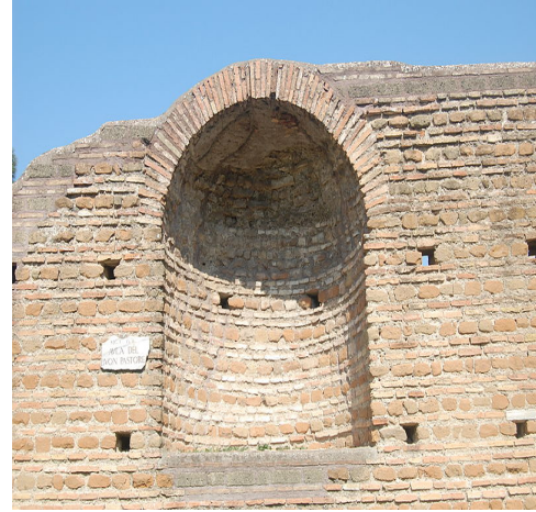
Fig. 467. Detalle de los mechinales del aula del buon Pastore . 885
