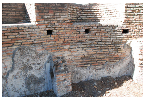
Fig. 470. Planta del ninfeo I, II, 1 con el trazado de los huecos de los mechinales. Fig. 471. Mechinales bajo dos de las hornacinas.
