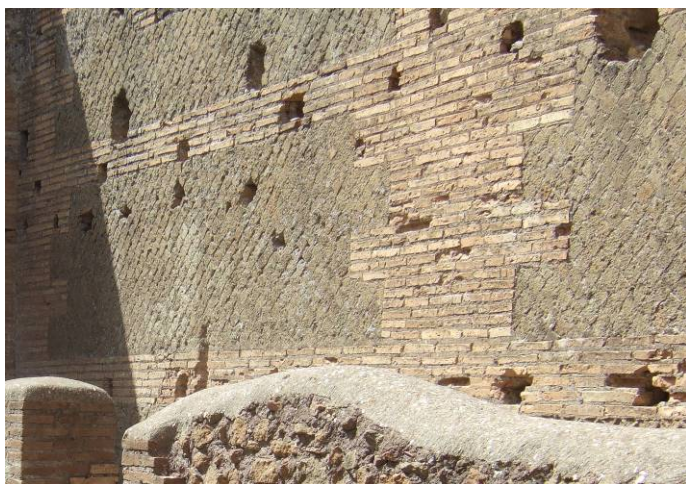
Fig. 402. Opus mixtum , muros con verdugas de ladrillo, Ostia Antica.
