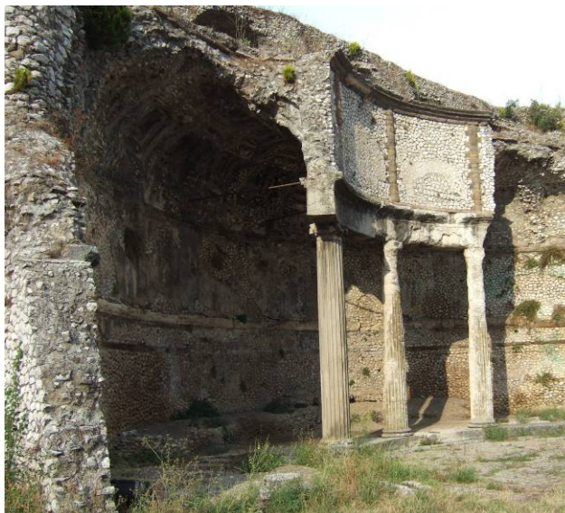
Fig. 414. Bóveda sin contrarrestos al exterior, sostenida por un arquivado sobre columnas. Santuario de la Fortuna Primigenia , Palestrina. Siglo II a.C.
