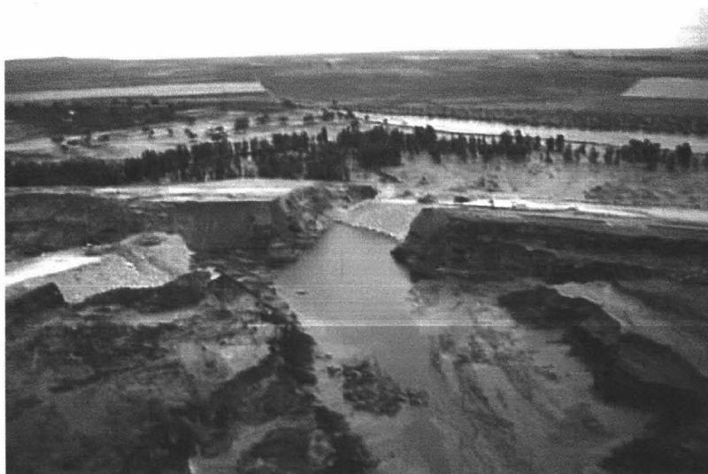
Figura 3.1 Detalle de la ruptura de la balsa de acumulación de estériles
