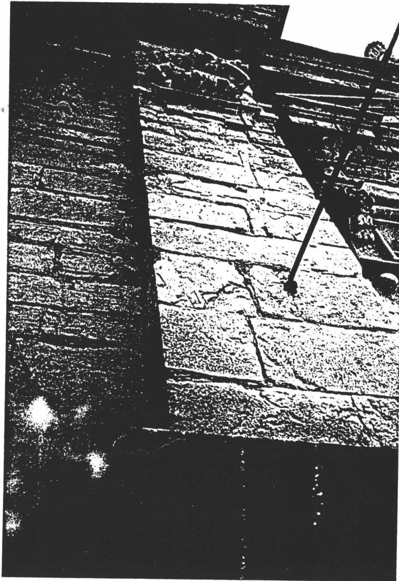
Fig. III-19. Exfoliación: aspecto que presentan los materiales calizo micríticos de la Catedral de Jaén, con laminación paralela a la base de las sillares (a) y perpendicularmente (b) y (c).
