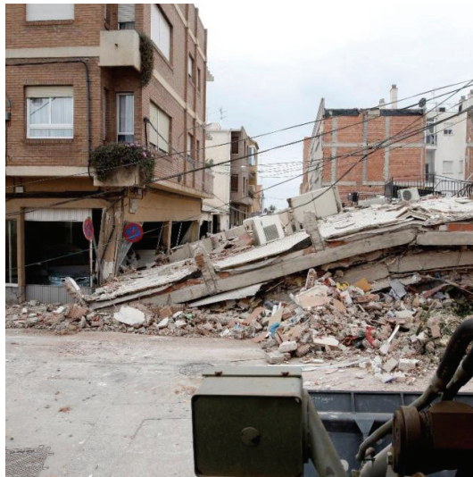
Figura 1.1: Edificio derruido en el barrio de Las Viñas tras el terremoto que afectó Lorca. EFE
