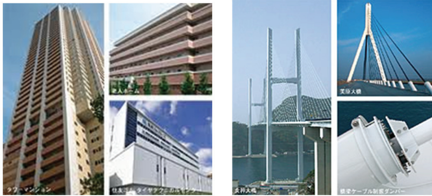
Figura 2.21: Ejemplos de edificios con amortiguadores Sumitomo Rubber Ltd
