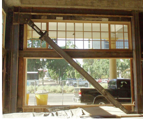
Figura 2.15: Instalación de un disipador viscoelástico
