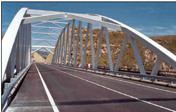
Nuevo puente de acceso a la Alpujarra - GRANADA. El diseño y la forma rompen radicalmente con sus antedecesoros, sobre los que está construido, pasando sobre ellos respetando su espacio y el trazado de sus vías, como queriendo reclamar su protagonismo y convertirse por sí mismo en el símbolo y referencia del entorno.
