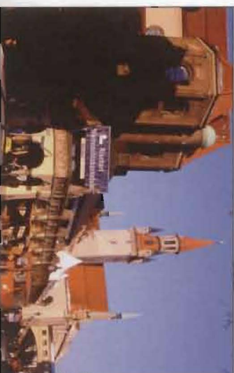
Fig. 2. La torre del Allerthaus (arriba) se perdió completamente en la guerra. La reconstrucción (abajo) nos recuerda aproximadamente la imagen original. Esta se hizo empleando materiales modernos como el hormigón armado, que le confieren una falsa apariencia de originalidad. En: Arriabar, Bauer, Richard y Graf, Eva. "Städtevergleich. Münchner ansichten", Hugendubel, München, 1985; abajo: Foto del autor.
