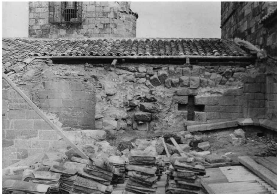
FIGURA 1. Iglesia de San Pedro de Ávila, durante los trabajos de restauración de Anselmo Arenillas en 1941
