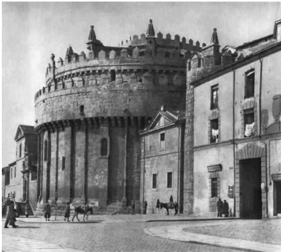
FIGURA 5. Cimorro o ábside fortificado de la catedral de Ávila (lámina xciii de la exposición de 1958), antes de la retirada de la cubierta postiza y su reforma
