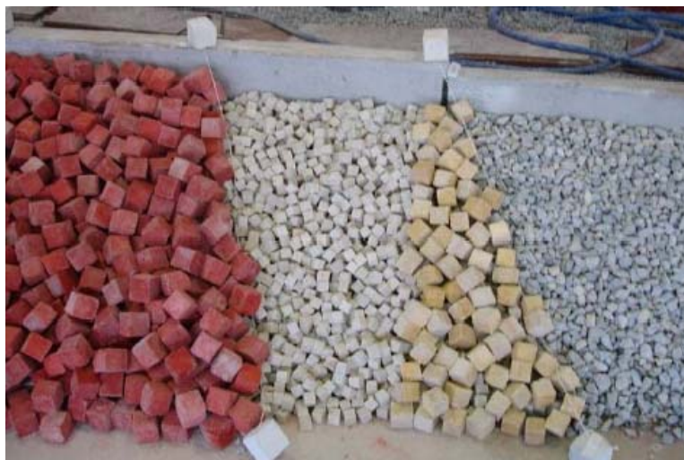
Figura III.5.10. Construcción de la transición entre las secciones E y F.
