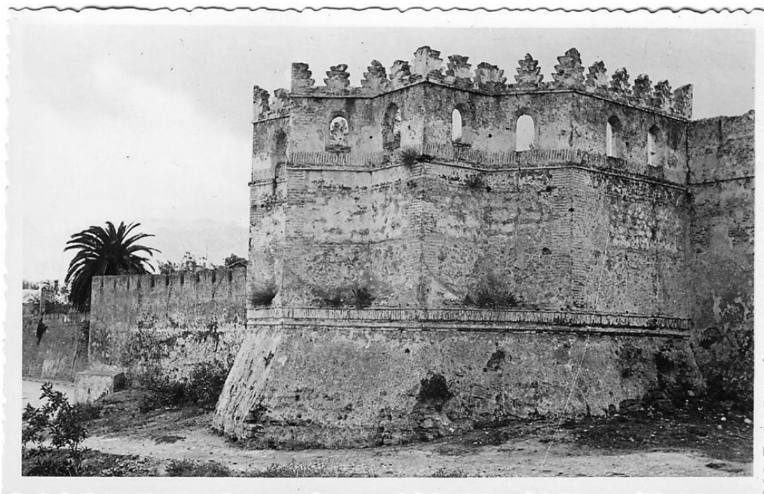
Lám 37. Torre poligonal de la muralla de Tetuán en 1942 173 (APSO).
