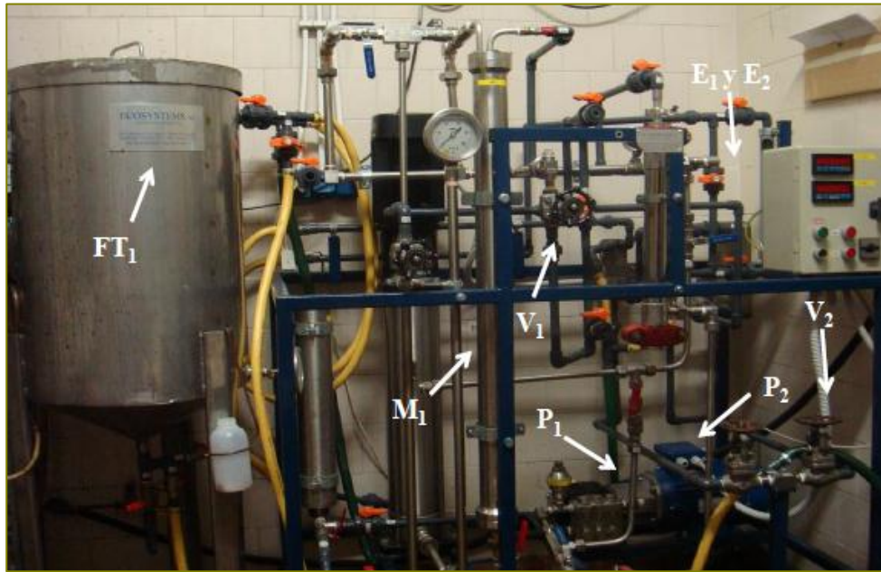
Fig. 5.I.7. Fotografía de la planta de filtración tangencial por membranas, FT 1 : tanque de alimentación, P 1 : bomba centrífuga, P 2 : bomba volumétrica, V 1 : válvula de regulación del bypass, V 2 : válvula de regulación del concentrado, E 1 y E 2 : intercambiador de calor carcasa y platos, M 1 : módulo provisto con membranas en espiral (SW).
