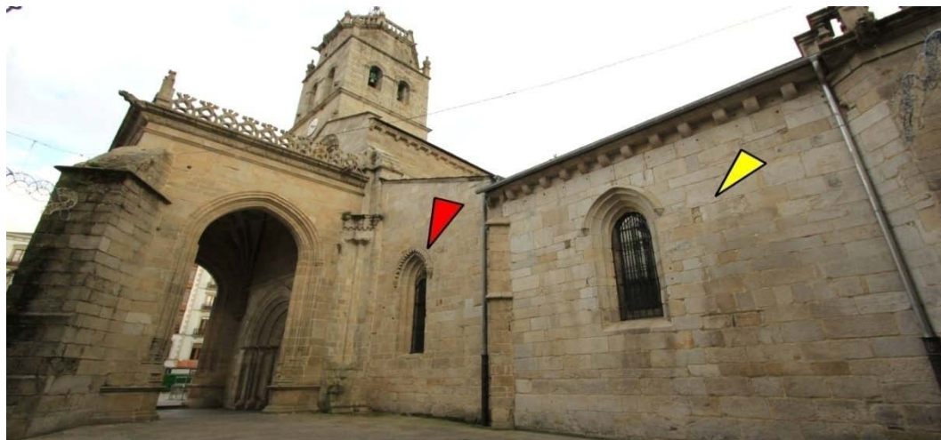
Ilustración 12. Entrada norte de la Catedral de Lugo, en primer plano muro de la Capela do Pilar. La flecha roja marca el muro de la antigua Capela dos Reis, la amarilla el de a Capela de San Froilán. A pesar de estar ambas capillas unidas en la actualidad, formando a Capela do Pilar, desde el exterior son claramente distinguibles.
