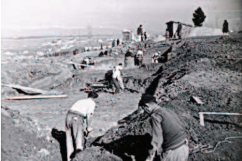
Excavación del Sótano de la casa Oswald. 14-02-1952
