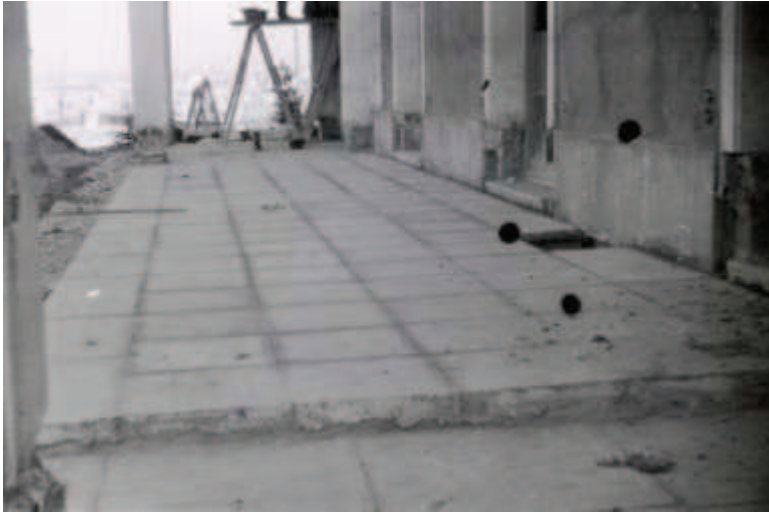
Solado del porche de la casa Oswald. 7-03-1953.
