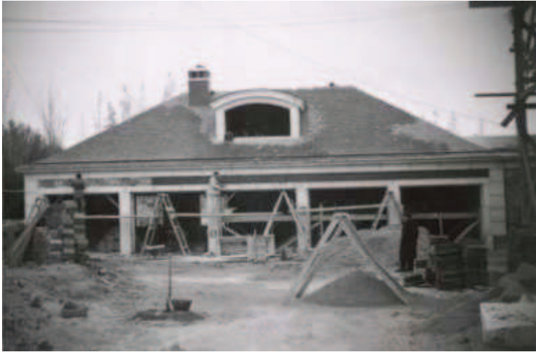
Garaje de la casa Oswald. 21-11-1952.
