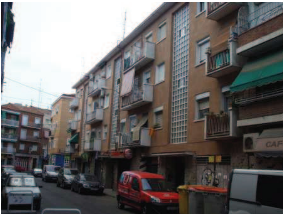
Fachada actual Edificio Azabache n°12 (2012)
