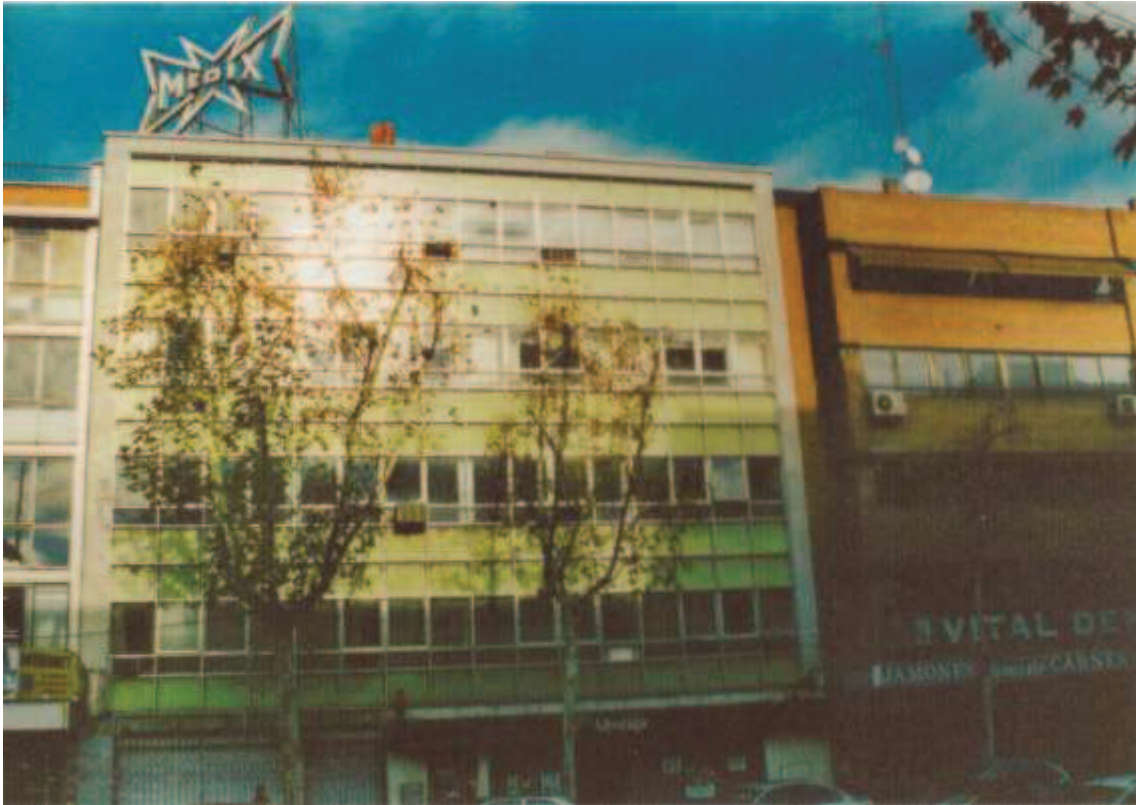
Fachada del edificio Medix (1970).
