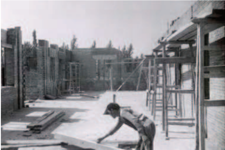
Construcción del cuerpo central de la primera planta de la casa Oswald.20-05-1952
