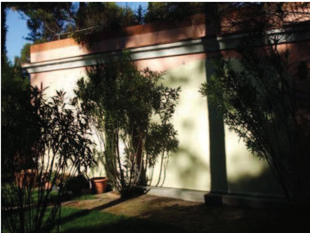
Detalle de arcada tapada en la fachada oeste de la casa Helen Kirby (2011).
