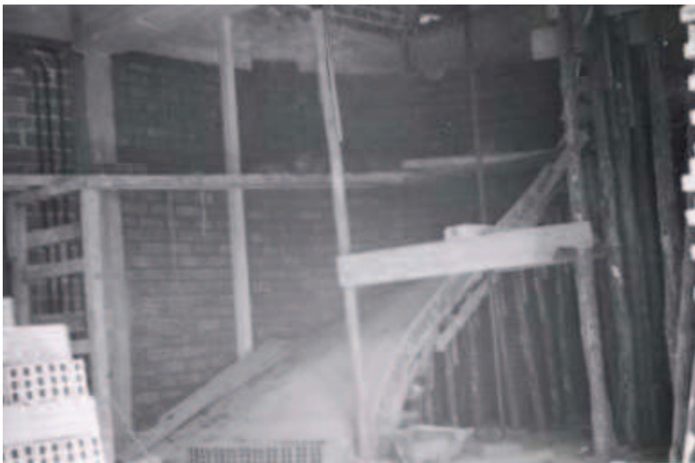
Construcción de la escalera principal a primer piso de la casa Oswald. 25-09-1952.
