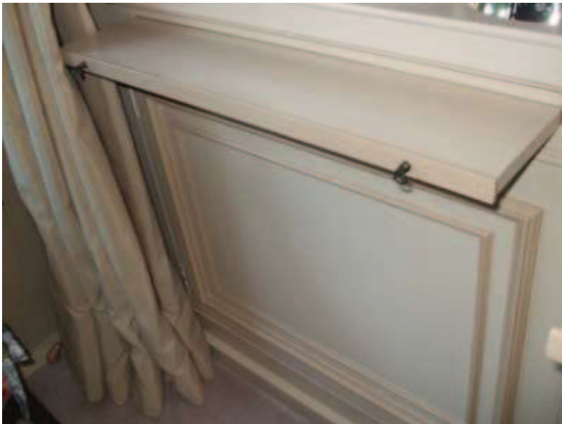
Detalle de los tableros extensibles que Ucelay diseña para los laterales de la chimenea del cuarto de estar en planta baja de la vivienda de Marta Oswald (2012). Fotografía: JVL.
