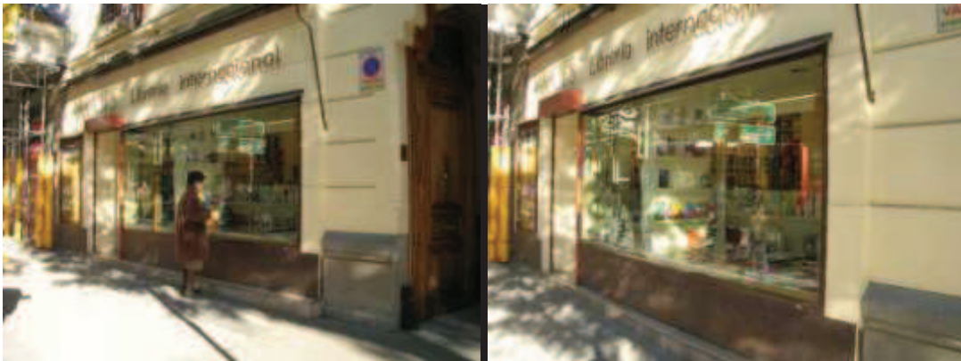
Fachada principal de la actual Librería Pasajes antigua Librería Turner (2011).
