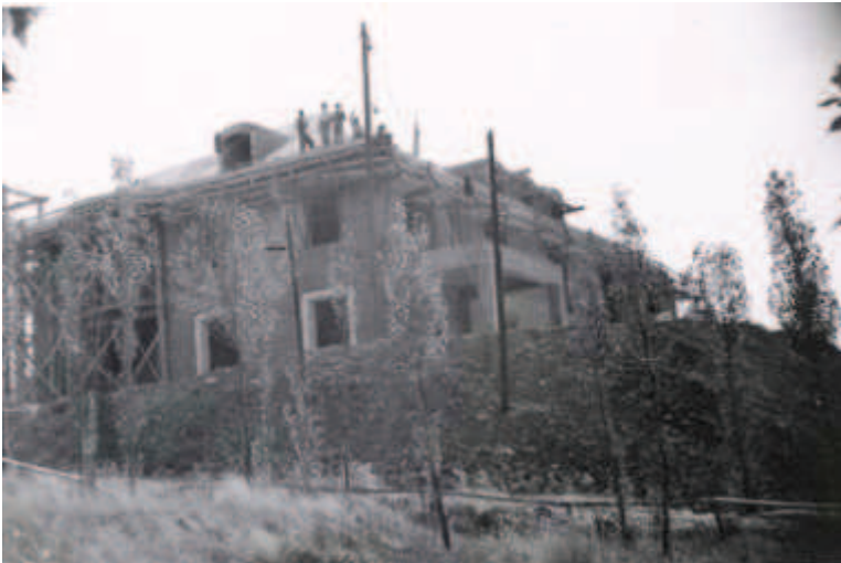
Vistas fachadas norte-oeste de la casa Oswald. 17-10-1952
