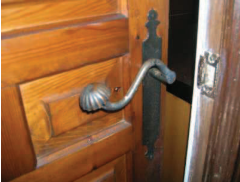
Detalle de una manivela de puerta en la casa Villa Laura en Fuente el Saz para Antonio Calvo.
