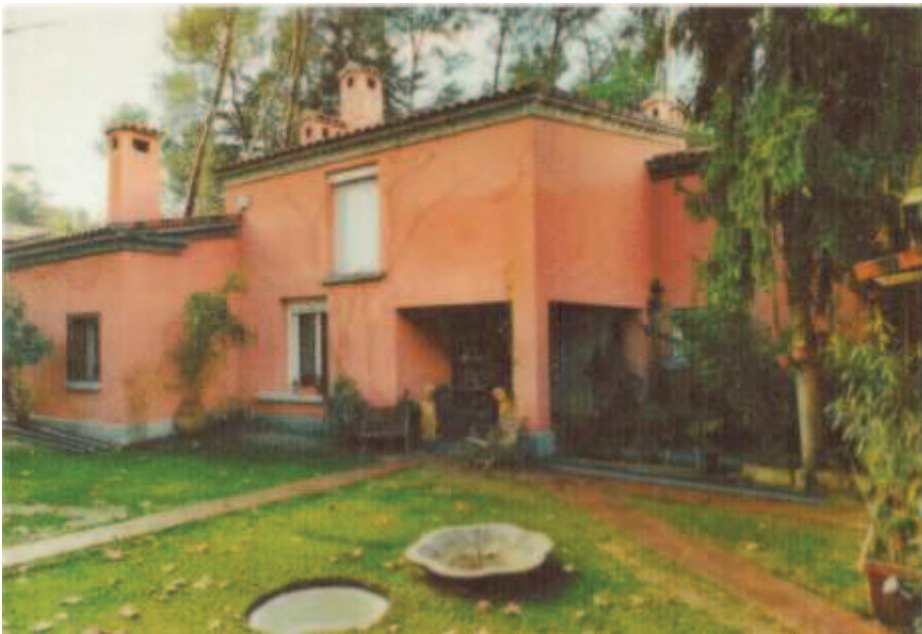
Entrada principal de la casa Helen Kirby (1970).
