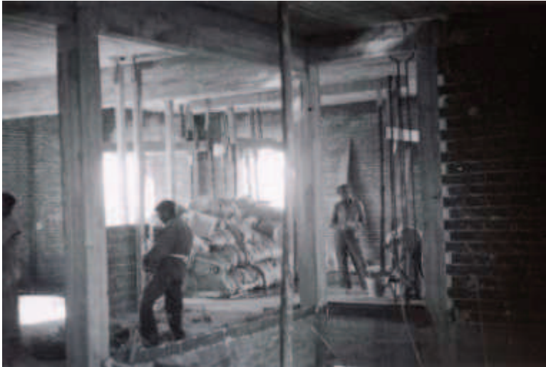
Tabicado del primer piso de la casa Oswald. 25-08-1952.
