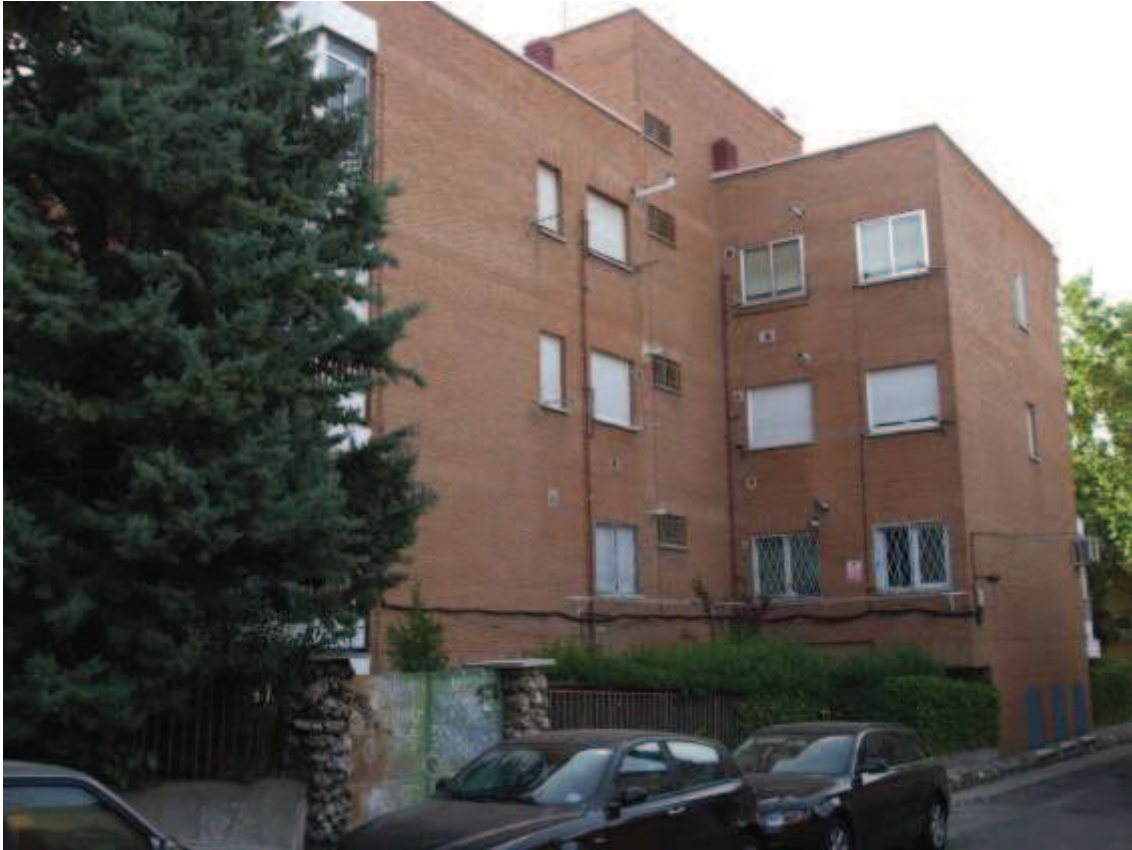
Fachada actual posterior del edificio Pérez Lobo (2012)
