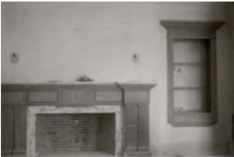
Chimenea salón. Casa Oswald. 5-05-1953.
