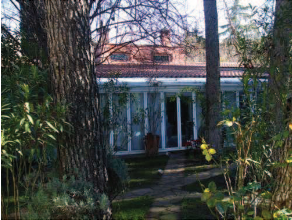
Fachada oeste de la casa Helen Kirby (2011).
