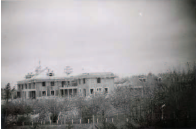
Vista general de la construcción de la casa Oswald. 21-11-1952.
