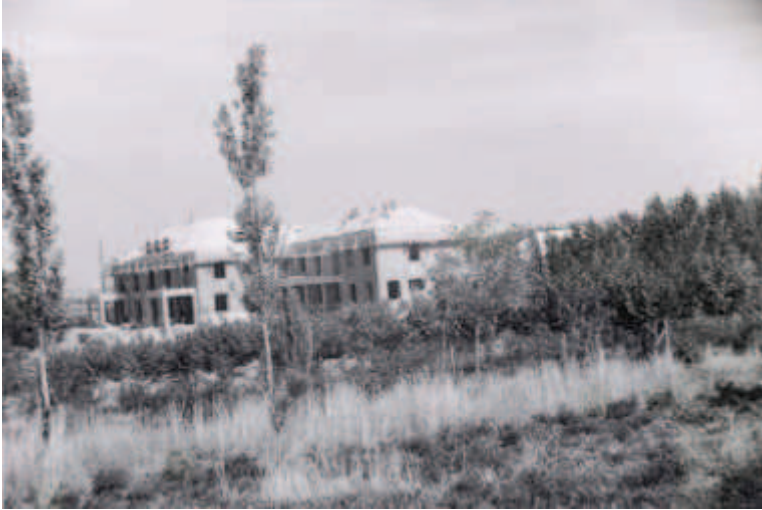
Vista general de la construcción de la casa Oswald. 17-10-1952
