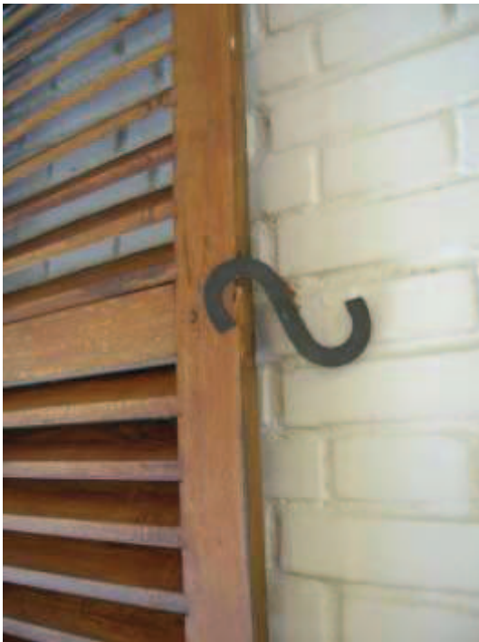
Detalle de una sujeción de persiana de madera en la casa Villa Laura en Fuente el Saz para Antonio Calvo.
