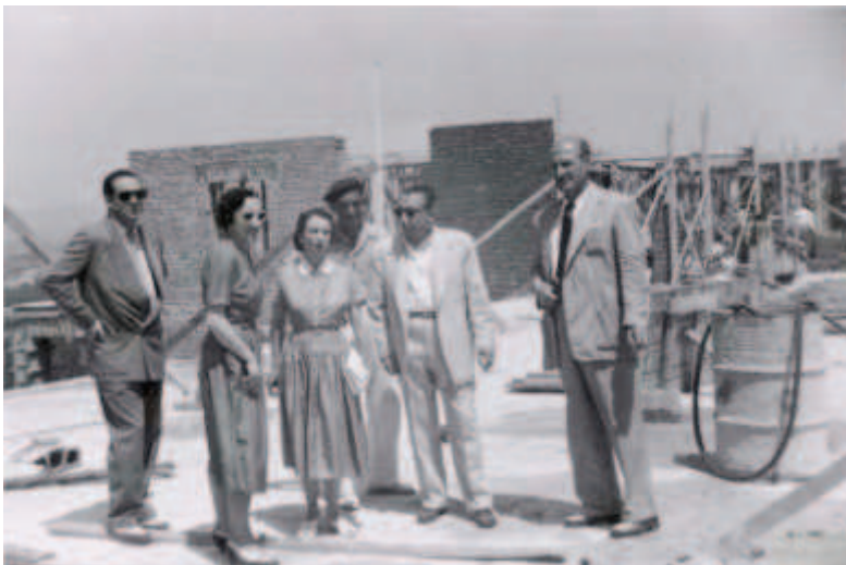
Matilde Ucelay (arquitecta), Sra. Oswald, Sr. Oswald y Carlos Boyer (aparejador) en las obras de la construcción de la casa Oswald. 25-06-1952.
