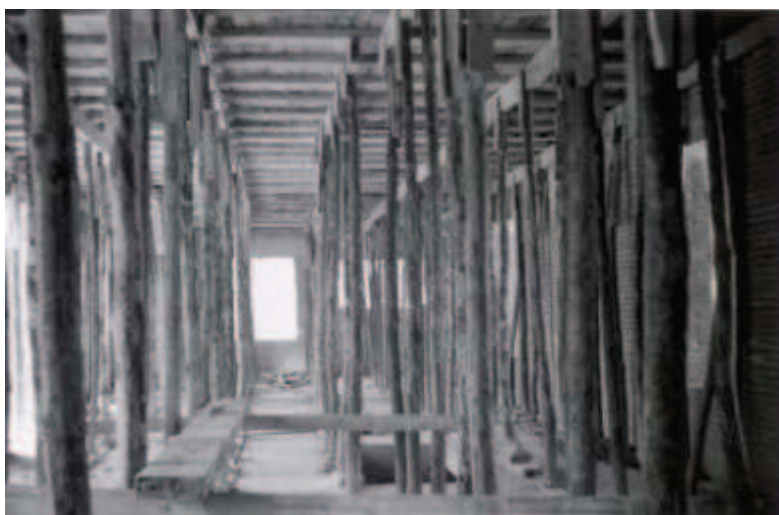
Encofrado forjado planta segunda de la casa Oswald. 26-06-1952.
