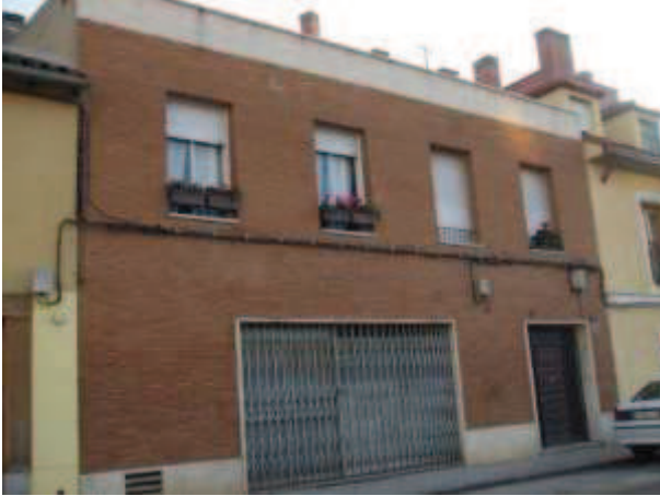
Fachada principal de la vivienda Dolores Romero (1963).
