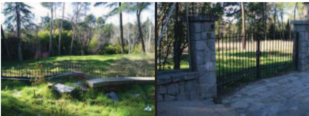
Estado actual de la edificación después de su derribo (2011).
