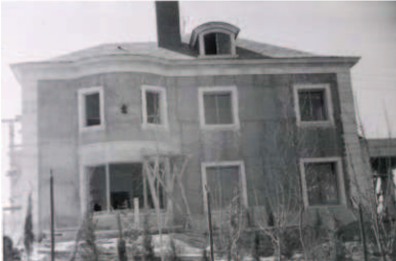
Fachada Norte de la casa Oswald. 7-03-1953.
