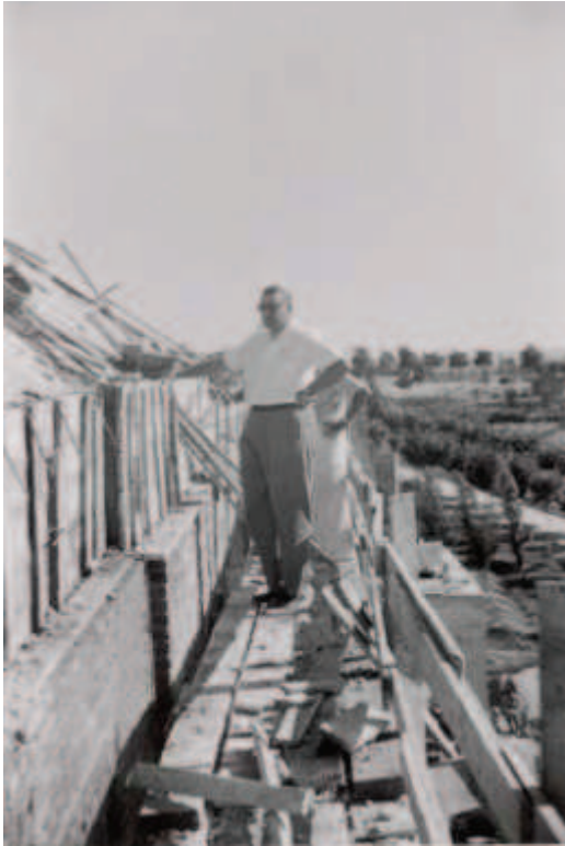
Andamiaje, tejado y cornisa de la casa Oswald. 25-08-1952.
