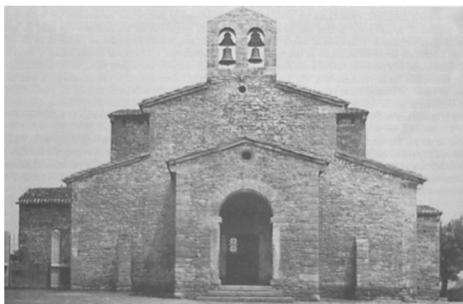
San Julián de Prados, estado anterior y posterior a la restauración de Fortunato Selgas y Vicente Lampérez, 1912-15
