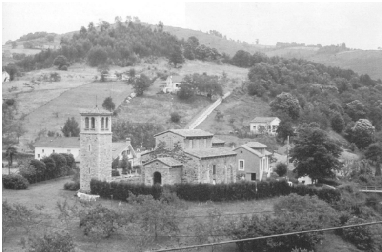
Vista general de la Iglesia de San Pedro de Nora tras la restauración y la construcción del campanario
