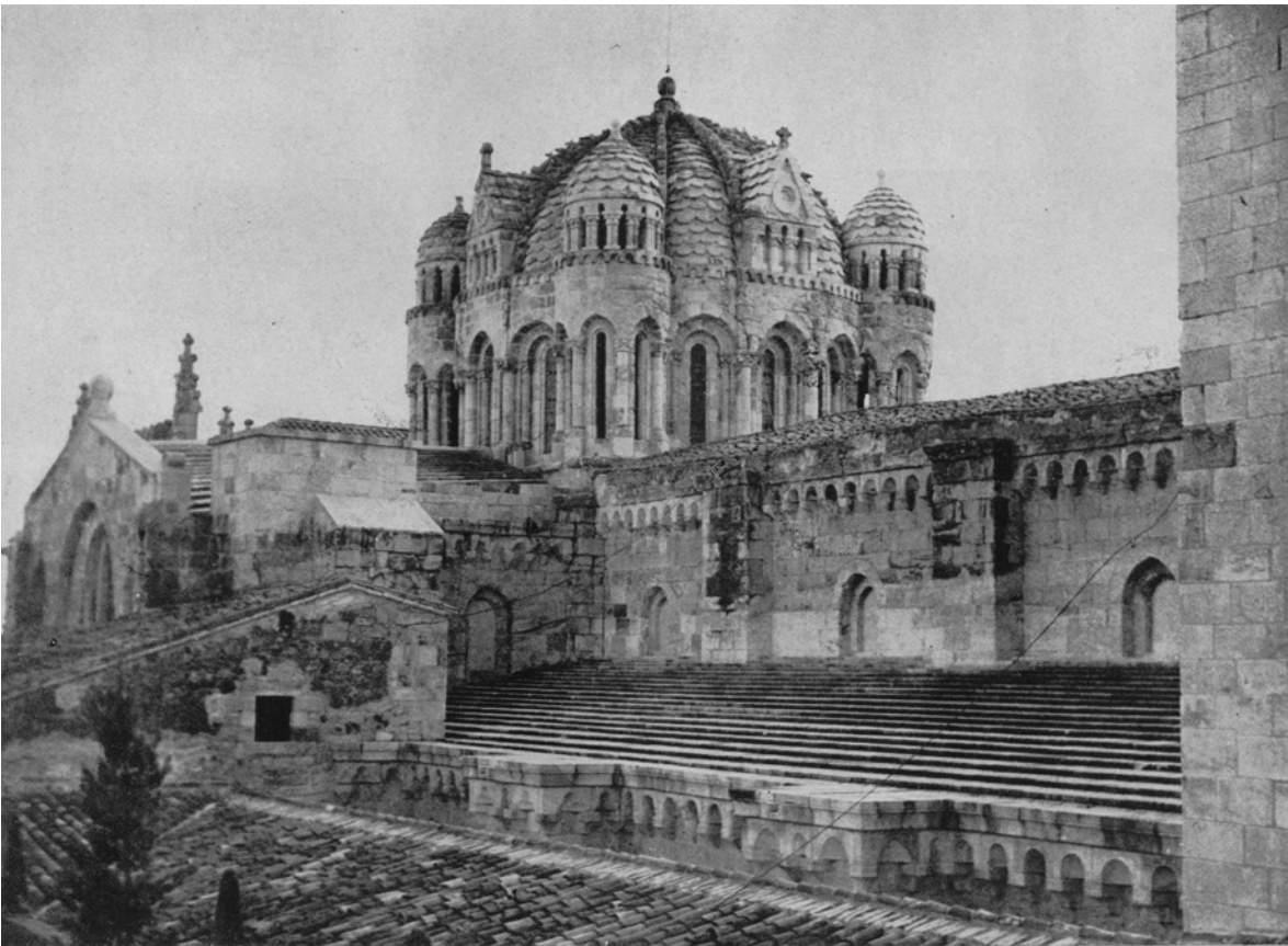
Catedral de Zamora, cubiertas pétreas y cimborrio ya restaurados Foto Luis Menéndez-Pidal, s.f.
