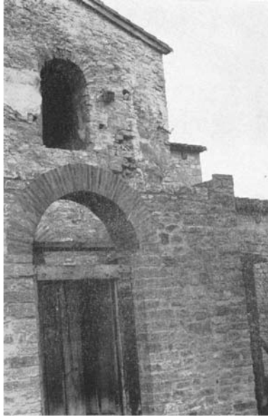
Capilla lateral durante la reconstrucción. Foto Menéndez-Pidal
