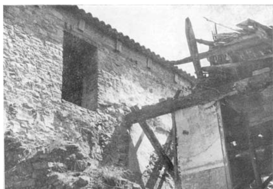
Detalle de la fachada meridional con los hipotéticos restos del narthex. Foto Luis Menéndez-Pidal
