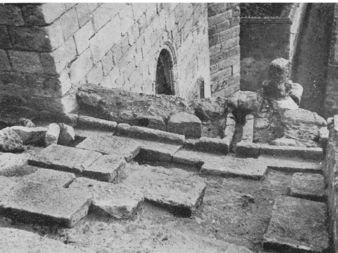
Catedral de Zamora, descubrimiento y restauración de las cubiertas pétreas. Fotos Luis Menéndez-Pidal, 1950
