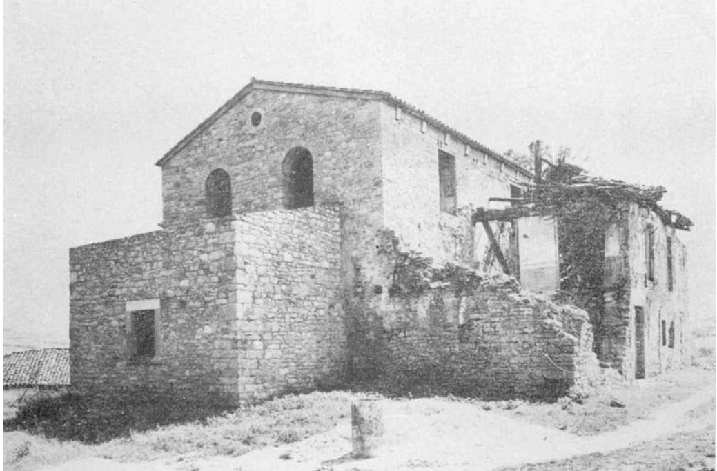
Iglesia de Santa María de Bendones, proceso de reconstrucción de la nave y la capilla lateral norte. Foto Luis Menéndez-Pidal
