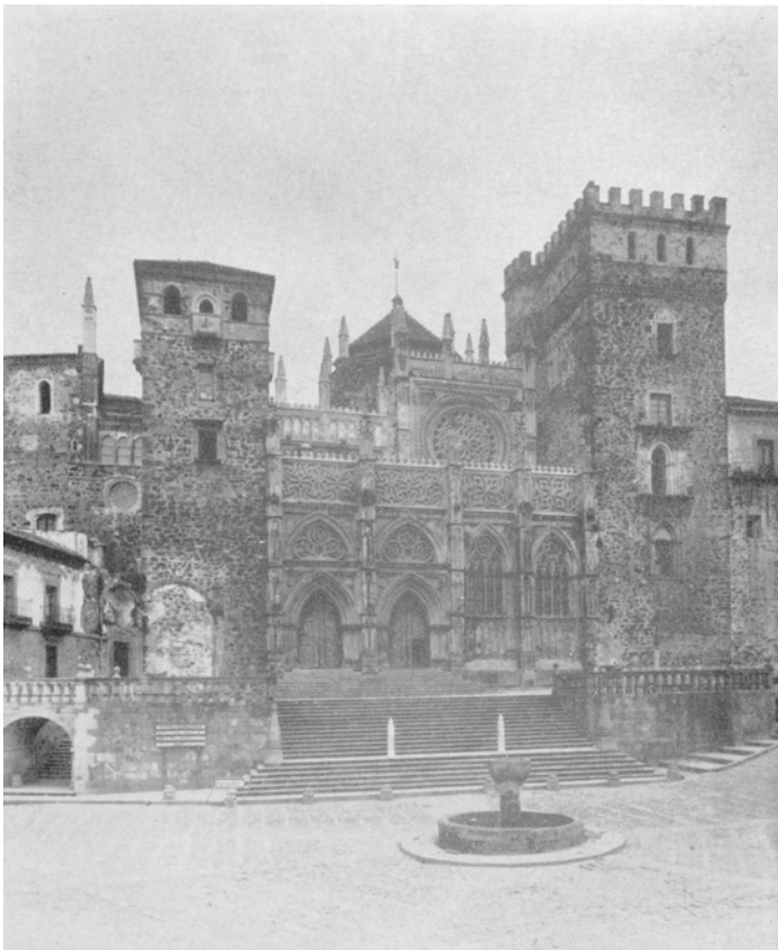
Monasterio de Guadalupe, fachada meridional, estado anterior (arriba) y posterior a la restauración (abajo)
