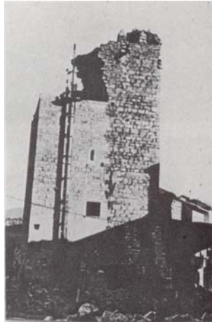
La torre de Salas durante las obras de reconstrucción
