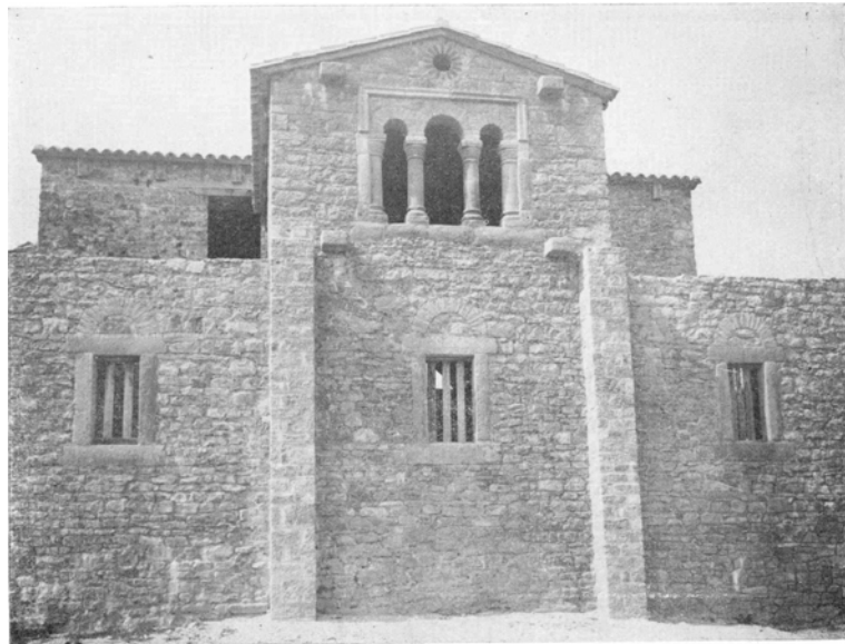
Ábside de Bendones, estado tras la primera hipótesis de reconstrucción en 1961
