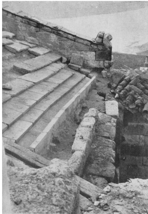
Catedral de Zamora, descubrimiento y restauración de las cubiertas pétreas. Fotos Luis Menéndez-Pidal, 1950
