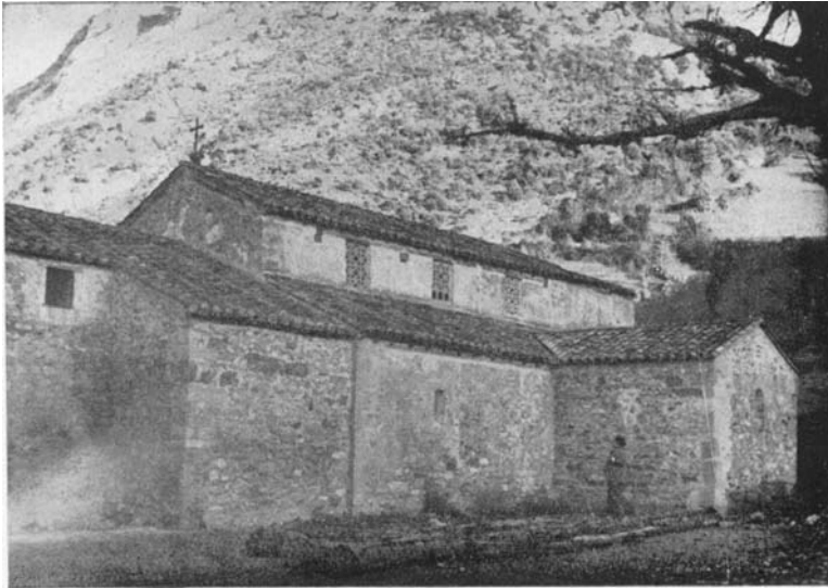
Iglesia de Santo Adriano de Tuñón, vista desde el exterior
