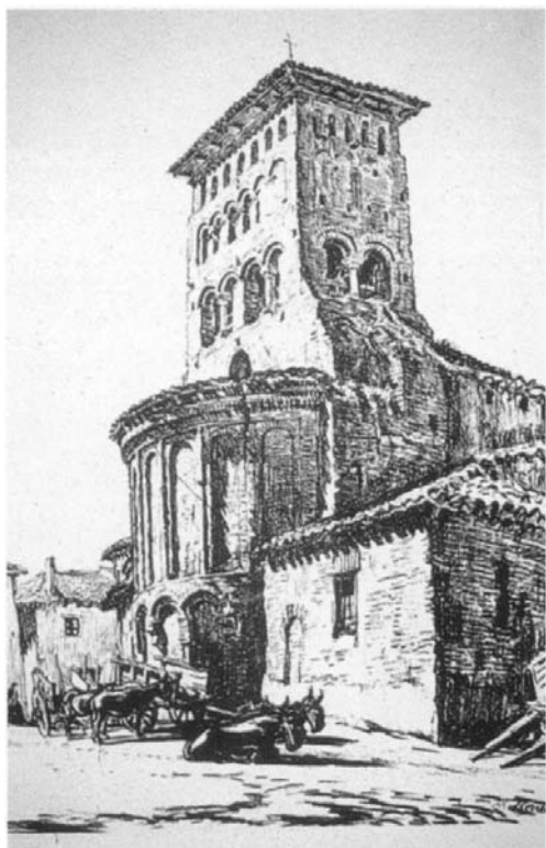
La torre campanario de San Tirso antes del derrumbe. Anónimo
