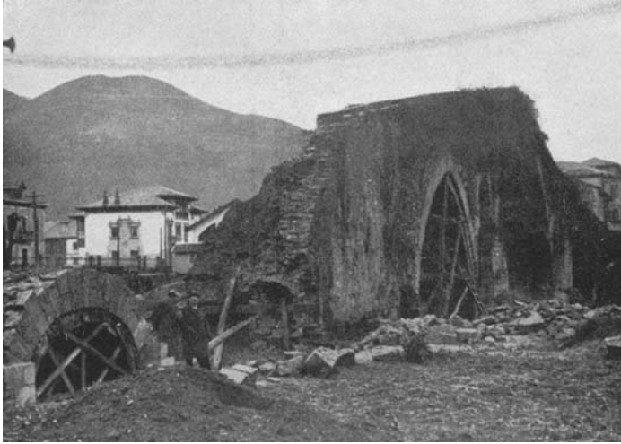
El puente de cangas de Onis durante las obras de restauración Foto Luis Menéndez-Pidal, 1941
