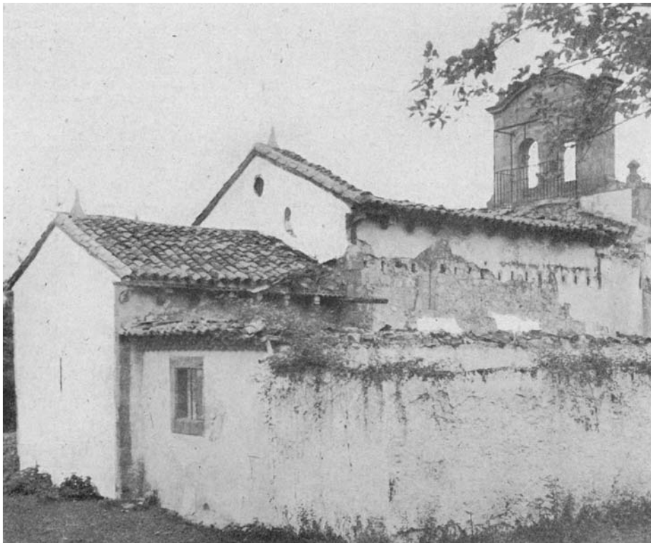
Iglesia de San Salvador de Fuentes, exterior antes de la restauración Fotos Luis Menéndez-Pidal, 1938
