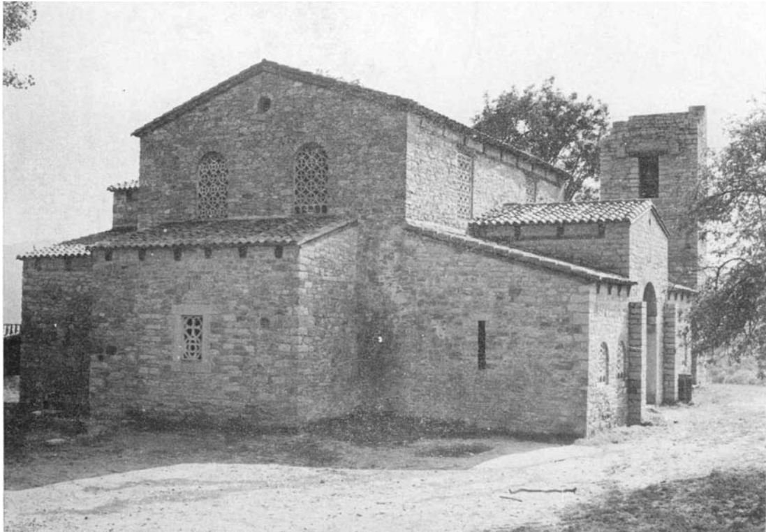
Vista exterior de la iglesia ya reconstruida Foto Luis Menéndez-Pidal
