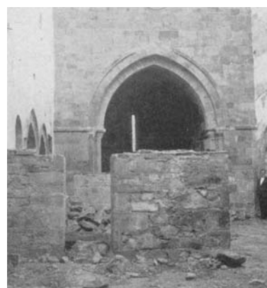
Interior, detalle del refugio antiaéreo levantado en la nave. Fotos Luis Menéndez-Pidal, 1939
