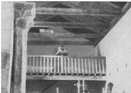
Detalles del nuevo coro. Foto Luis Menéndez-Pidal, 1940
