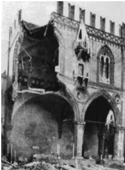
Palacio de la Mercancía, Bolonia. Estado después de los bombardeos, 1945.
