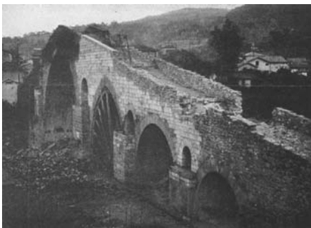
El puente de Cangas de Onis durante los trabajos de restauración, véase la discriminación entre fábricas añadidas y originales. Foto Luis Menéndez-Pidal, 1942
