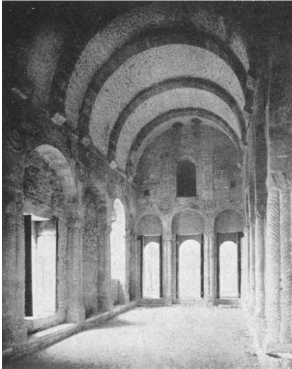
Iglesia de Santa María del Naranco, vista del interior ya restaurado
