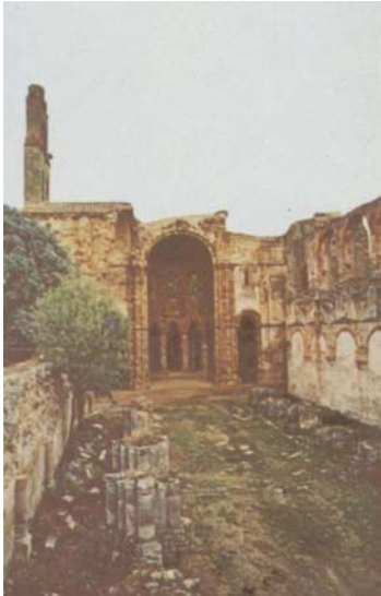
Ruinas del monasterio de Moreruela, estado previo
