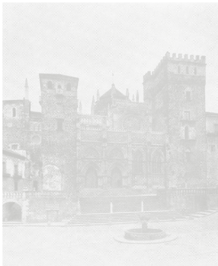
Monasterio de Guadalupe, fachada meridional, estado anterior (arriba) y posterior a la restauración (abajo)
