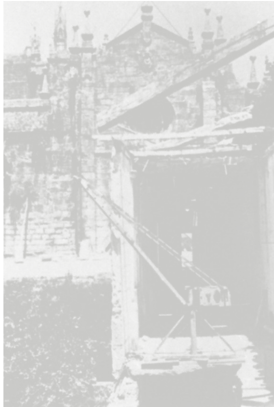
La catedral de Tuy, durante las obras de restauración del claustro
