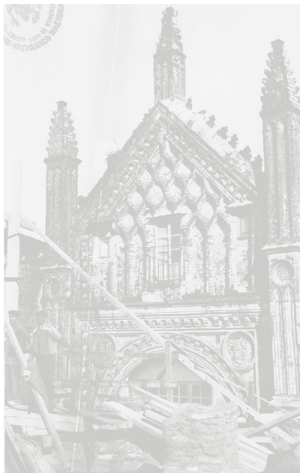
El monasterio de Guadalupe, torre de Carlos V y hastial occidental, estado previo (superior) y durante la restauración (inferior.)
