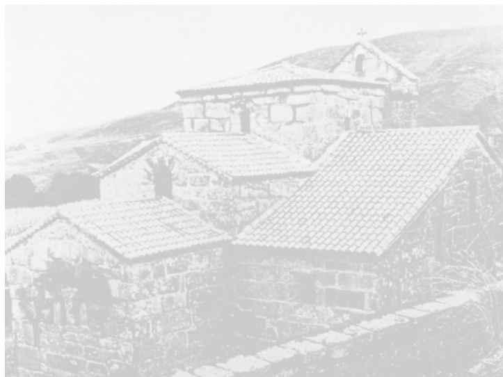
Santa Comba de Bande, vista exterior antes de la restauración
