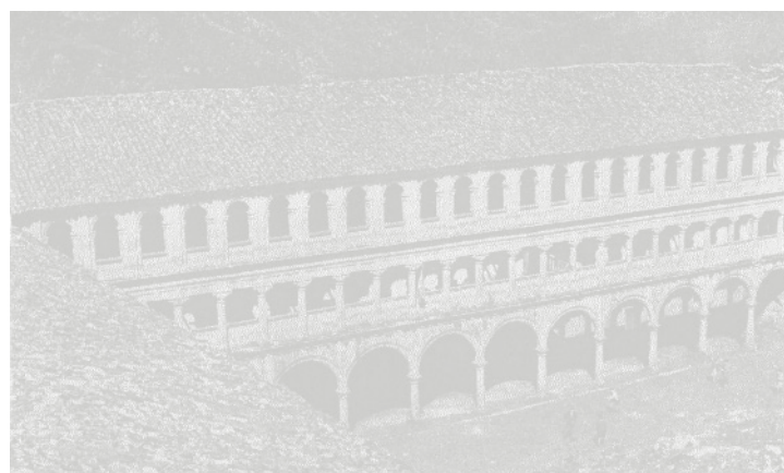
Monasterio de San Esteban de Ribas del Sil, claustro Grande después de la restauración
