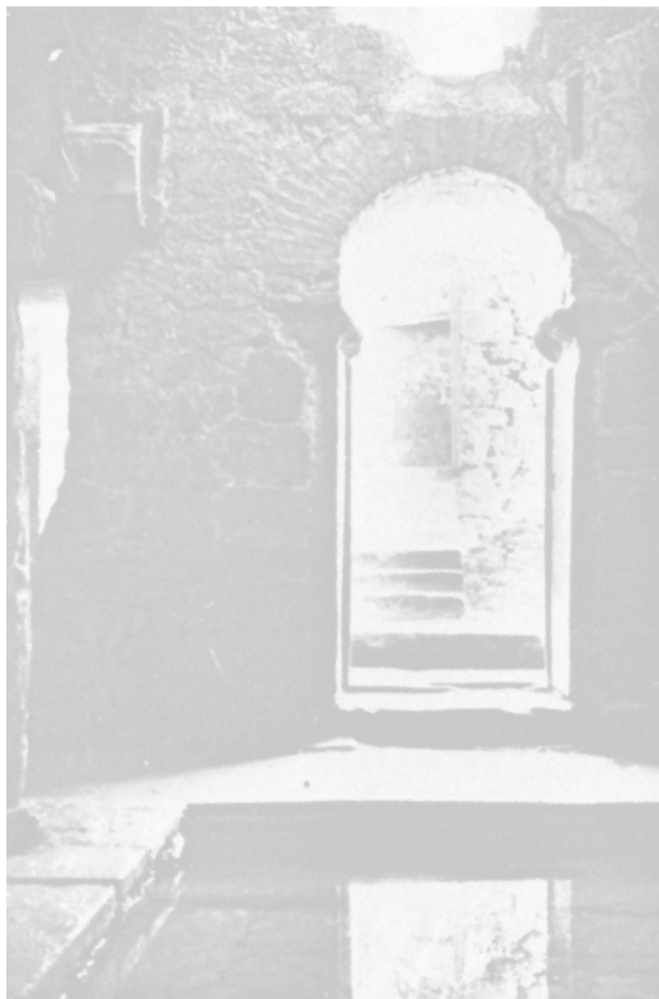
Iglesia de Santa Eulalia de Bóveda, interior antes de la restauración
