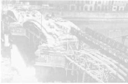
Puente de Santa Trinità, Florenca. Estado después de los bombardeos, 1944
