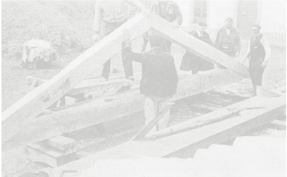
Luis Menéndez-Pidal (el tercero por la derecha) durante los trabajos de restauración de San Salvador de Priesca, 1939
