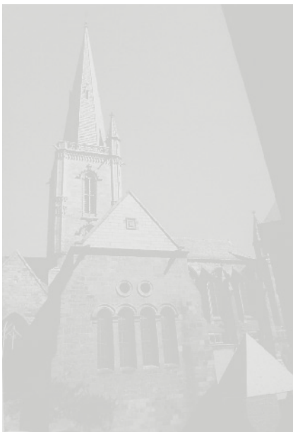
Saint-Malo. Catedral de San Vincent, reconstrucción de Pierre Prunet (1968-70)
