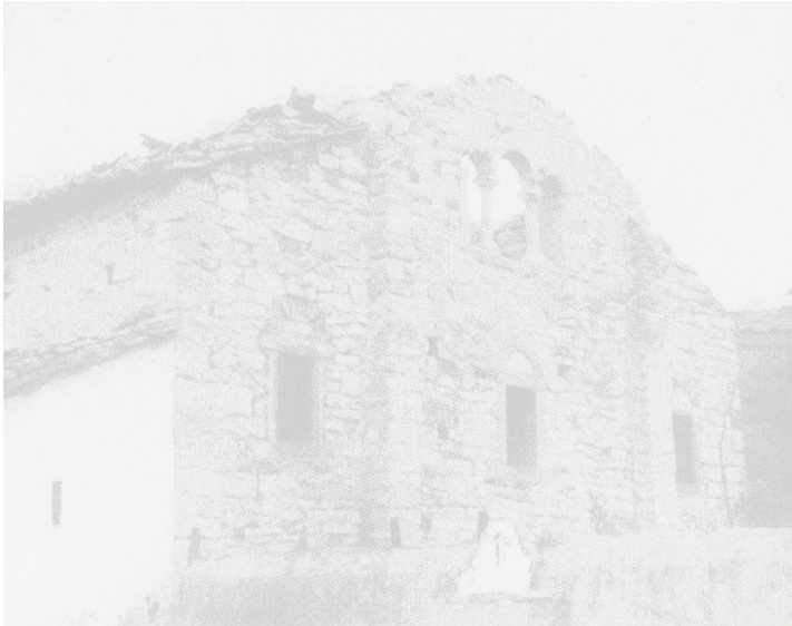
Iglesia de San Pedro de Nora tras el incendio de sus cubiertas, 1936
