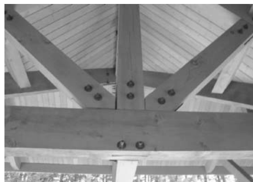
c) Madera – madera conexión con tornillos y arandelas circulares oprimidos en madera
