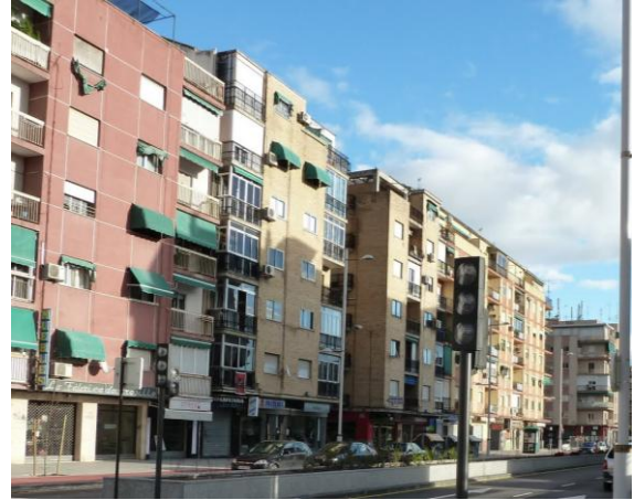
Fig. 3.1.3: Edificios de 6 plantas, Camino de Ronda (Granada)
