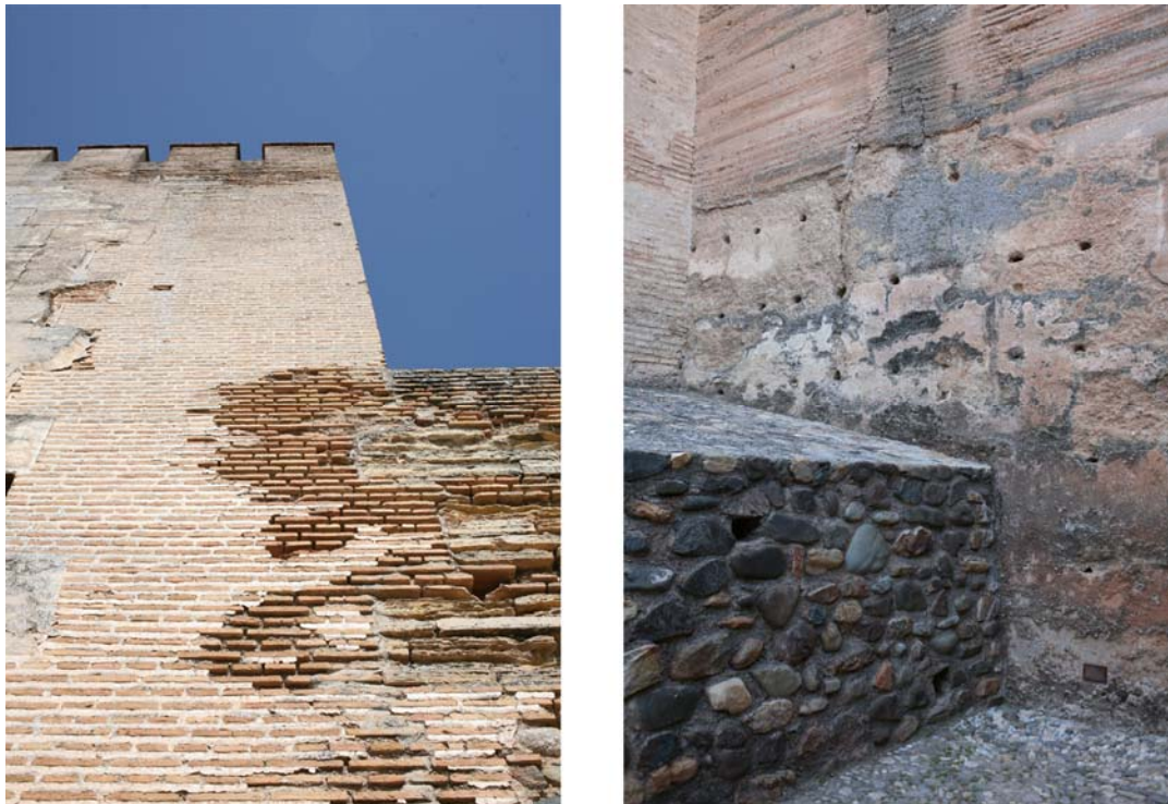
Fig.47 - A la izquierda, esquina S-O reconstruida. A la derecha contacto de la muralla E con la torre
