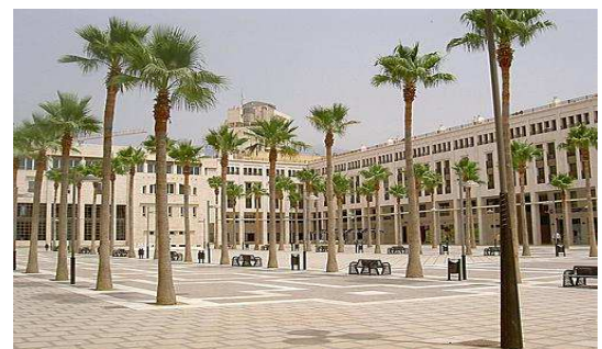
Figura n ° 109. Instalaciones Ayuntamiento El Ejido
