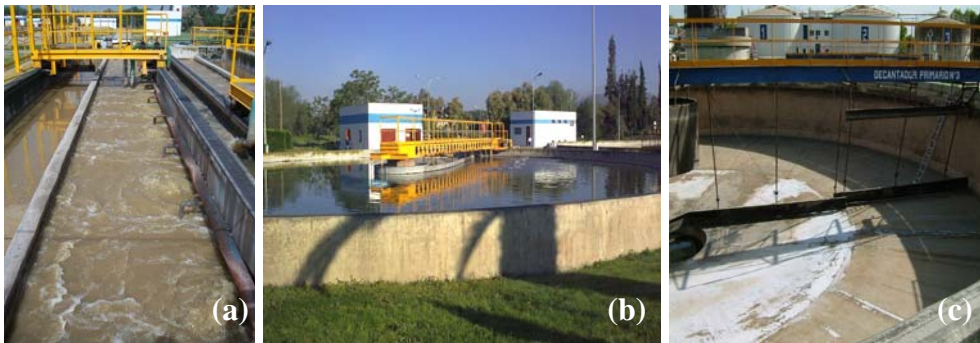
Figura 2.2. Tratamiento primario. (a) Sistema de desarenado y desengrasado. Poza de decantación primaria, (b) llena y (c) vacía.
