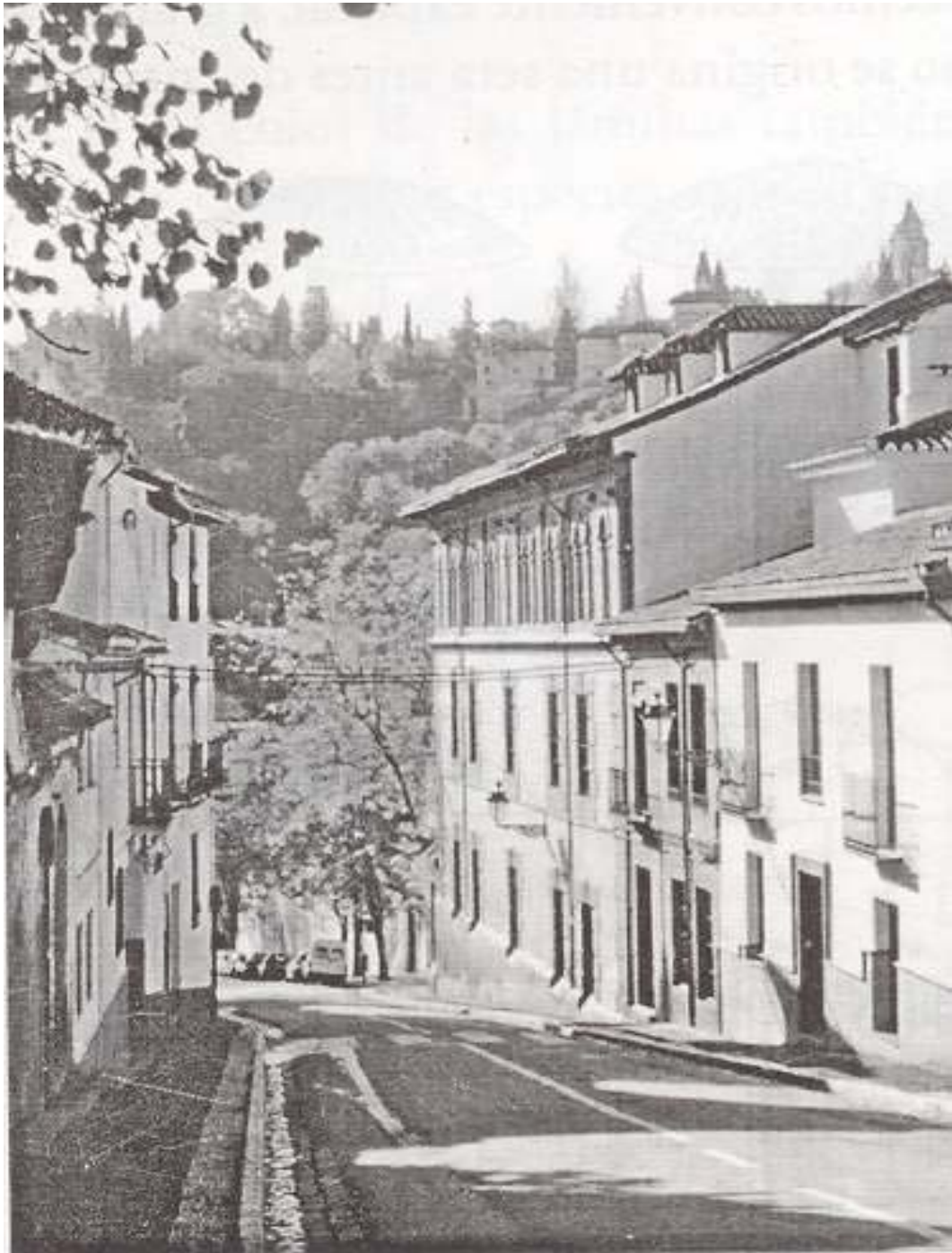
Figura 25: Aspecto actual de la antigua sede del Seminario de Maestros (Fuente: fotografía propia)
