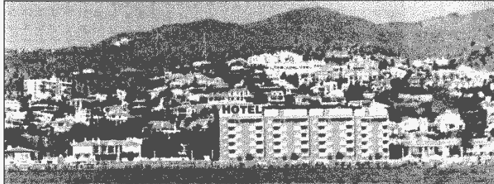
La Cala del Moral: un macro hotel como éste destruiría la fachada marítima
