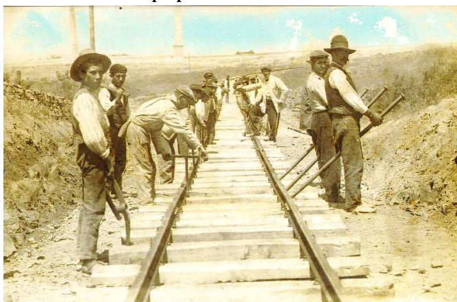
Foto: Obreros construyendo la vía ferroviaria. Autor: Antonio Arco. Fuente: http://www.linares.net/album/antiguas/31.html .
