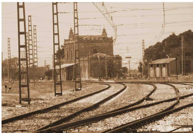
Foto: Estación de San Juan del Puerto. Autor: Desconocido. Fuente: http://www.mancomunidad.net/viaverde/061.htm .
