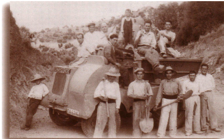
Foto: Obreros construyendo la Línea Jerez de la Frontera-Almargen. Autor: Desconocido.
