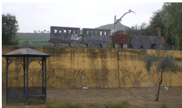
Foto 3: Monumento ferroviario en homenaje a los trenes ferroviarios Minas de Cala y de Aznalcóllar, en el “Paso superior sobre Ctra. N-630 y Avda. Ferrocarril”. Vía Verde de Itálica (Sevilla).
