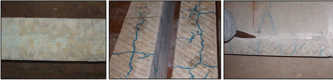
Figura 4.14. Demarcación y demolición de la zona fisurada de la viga
