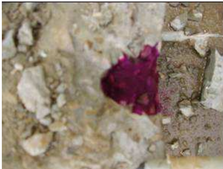
Figura 5.137. Prueba de carbonatación
