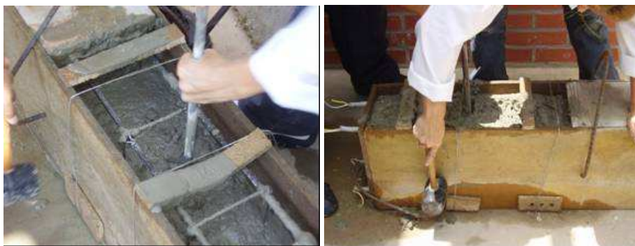
Figura 4.30. Compactación del hormigón con barra y martillo de goma
