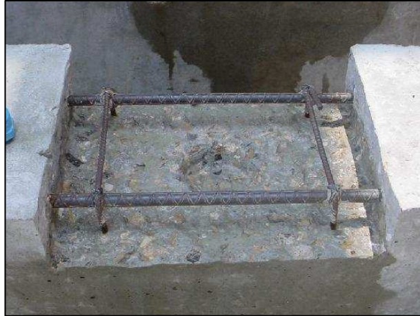
Figura 4.23. Vista del espacio esmerilado para la colocación del ánodo
