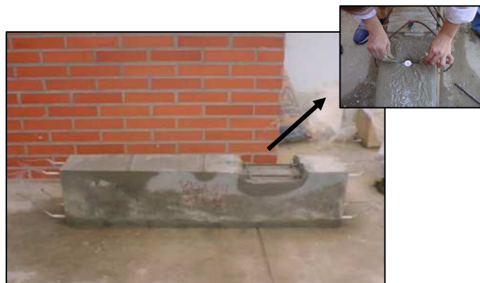
Figura 4.19. Viga con espacio para la reparación con ánodos
