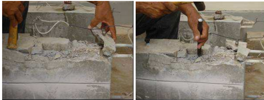
Figura 4.28. Remoción de hormigón para la reparación de la viga de hormigón
