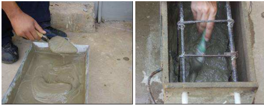
Figura 4.29. Pasta de cemento utilizada para mejorar la adherencia
