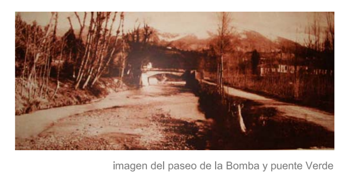
imagen del paseo de la Bomba y puente Verde
