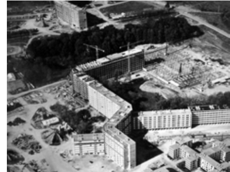
F43 _ Bellefontaine, proceso construcción: 1.967. Grandes bloques zona central-centro comercial. CAPA
