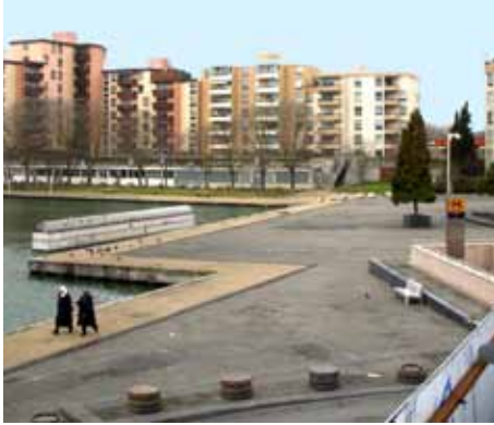
F17_ Reynerie, estado actual Plaza Abbal junto al lago- entrada metro, resultado demoliciones DSQ. 2.010.
