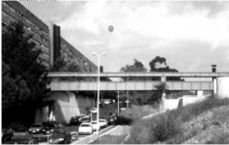
F41 _ Corviale, pasarela principal conexión Este-Oeste, zona centro de equipamientos hasta bloque paralelo, sobre 1.990
