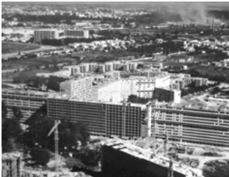
F47 _ Bellefontaine, proceso construcción: 1.968. Grandes bloques zona este-zona central, pequeños bloques. CAPA
