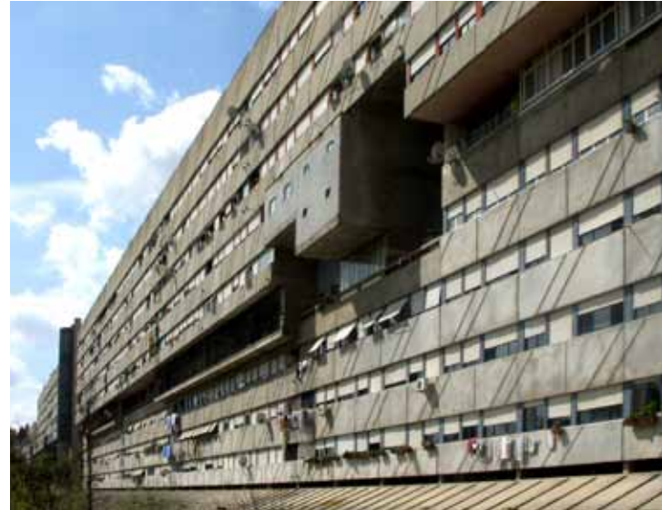
F8 _ Corviale, bloque principal, fachada Este, ocupación viviendas "cuarto piano", 2.011.
