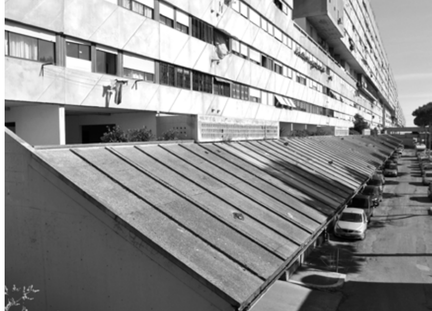
F45 _ Corviale, vista general bloque principal, relación basamento aparcamientos- pórtico planta baja-pasarelas transversales, fachada Oeste, 2.010
