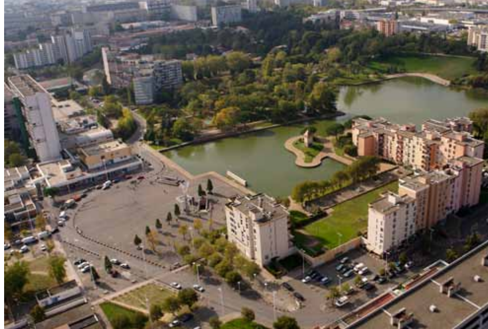
F21_ Reynerie, resultado proceso DSQ, demolición dalle- biblioteca-equipamientos. Plaza Abbal y construcción subterránea línea de metro. 2.009.
