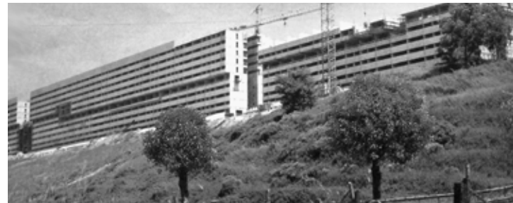
F36 _ Corviale, proceso construcción gran bloque principal, niveles superiores, fachada Oeste, 1.975-82
