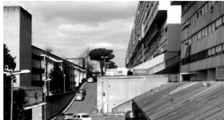
F72 _ Corviale, bloque paralelo fachada Este, viario y posición relativa con el bloque principal, 2.010.
