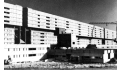
F92 _ Corviale, proceso construcción edificios docentes- bloque paralelo, fachada Oeste, 1.975-82
