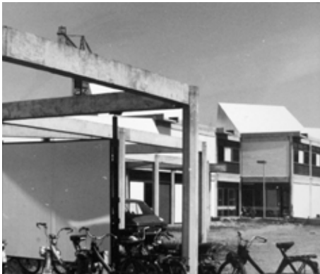
F125-F126_ Mirail, Escuela Arquitectura, detalle sistema cubiertas y pórticos exteriores, 1.970. CAPA
