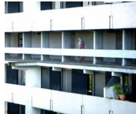
F69_ Reynerie, estado actual Coursives , gran bloque Poulenc: detalle desde el exterior. 2.011
