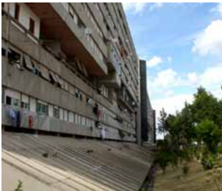
F5-F7 _ Corviale, bloque principal, fachada Este- "plazas" de ingreso, 2.011.
