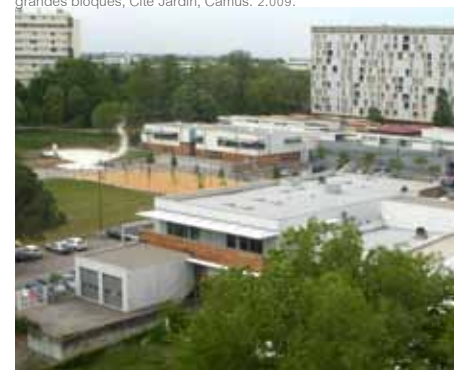
F39_ Bellefontaine, Grand Projet de Ville , resultado proceso demolición zona central dalle- grandes bloques Maurois I, Maurois II. Rehabilitación piscina cubierta y nueva escuela infantil Bastide. 2.011.
