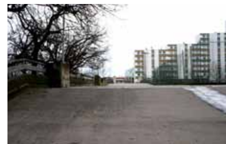
F35_ Reynerie- Bellefontaine, sector dalle de conexión. 2.010.
