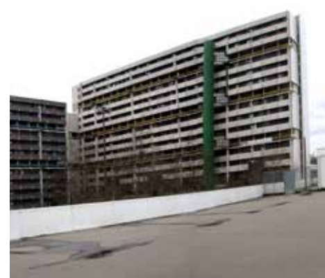
F54_ Reynerie, estado actual dalle - ascensores externos gran bloque Cambert- Glück. 2.010.
