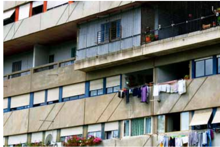
F14 _ Corviale, bloque principal- fachada Este, ocupación viviendas "cuarto piano", 2.011.
