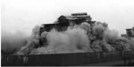
F51-F52_ Francesco Di Salvo, Vele di Scampia, Nápoles, 1.962-75. Demolición edificio "vela" G, 2.000.
