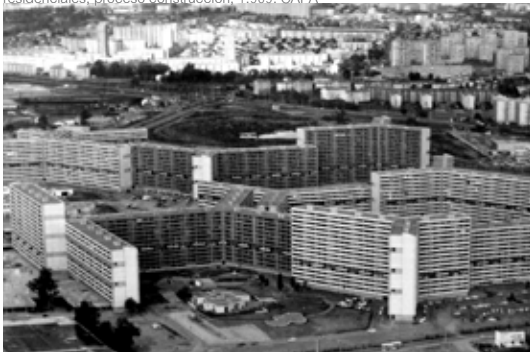
F11_ Toulouse le Mirail, Reynerie, vista área estructura urbana grandes bloques residenciales, proceso construcción, 1.973. CAPA
