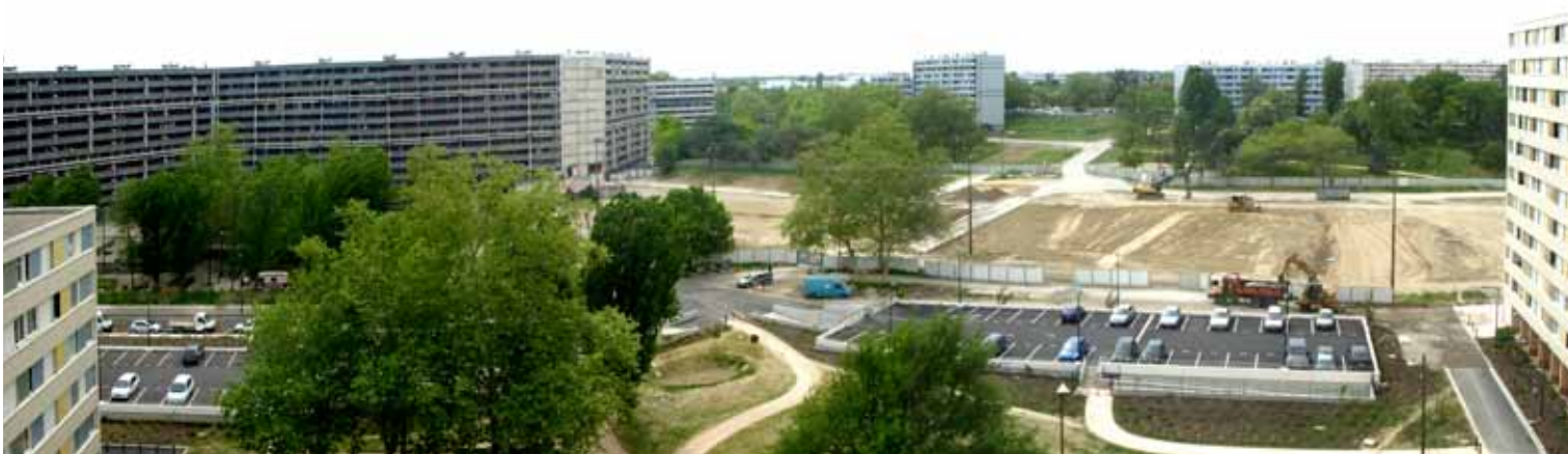
F26_ Bellefontaine, Grand Projet de Ville : resultado demolición zona central dalle- grandes bloques Concorde, Maurois II, Cité Jardin, Camus. Proceso "residencialización" Gauguin: aparcamientos y área construcción nuevas viviendas. 2.011
