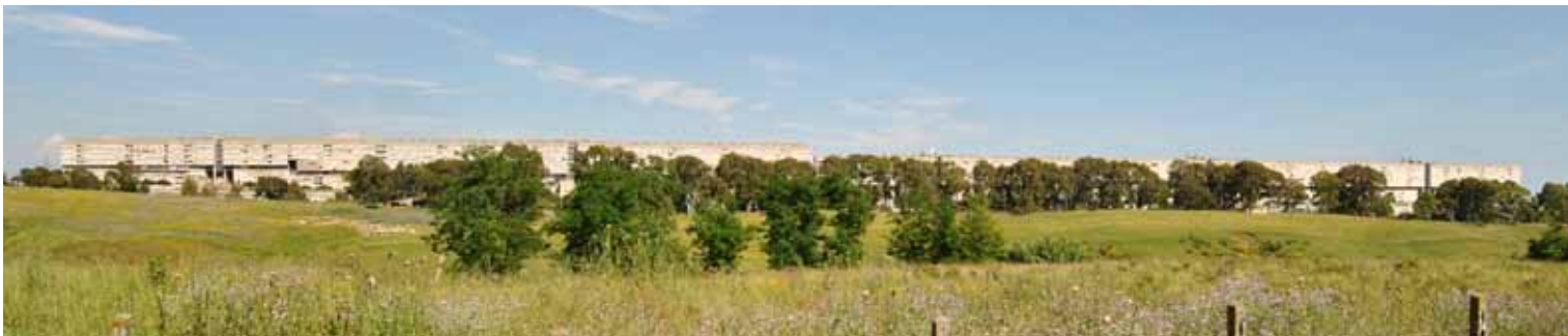
F28_ Corviale, vista general gran bloque principal en relación con el paisaje, alzado hacia la "campagna romana"- fachada Oeste, 2.011
