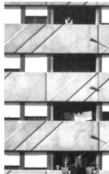
F66 _ Corviale, detalle material alzado bloque principal, fachada Este, 1.982
