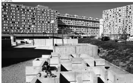
F31_ Bellefontaine, espacio público grandes bloques- mobiliario urbano diseñado proyecto, 1.972.CAPA
