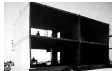
F38-F39 _ Corviale, proceso construcción gran bloque principal, módulos prefabricados estructura base
