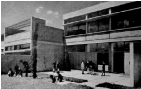
F94-F95_ Bellefontaine, escuelas primarias Georges Bastide, tipo T2, 1.965-67. proceso construcción y alzados. CAPA
