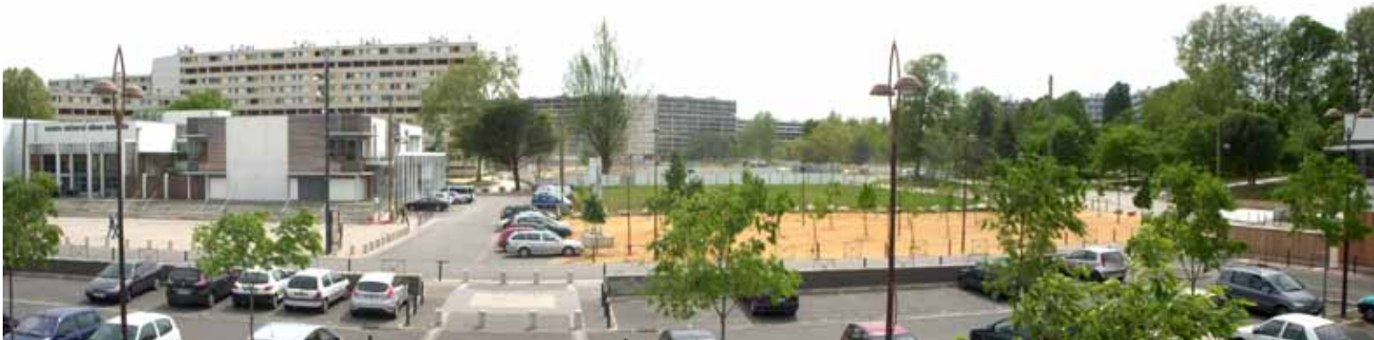
F37_ Bellefontaine- Grand Projet de Ville : resultado demolición zona central dalle- grandes bloques Maurois I, Maurois II, Concorde, Cité Jardin, Camus. Cosntrucción nuevo centro socio-cultural Alban Minville- plaza Martin Luther King y proceso acondicionamiento área construcción nuevas viviendas. 2.011
