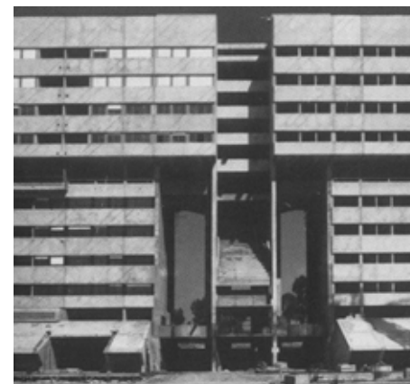
F20 _ Corviale, “plaza” de ingreso bloque principal, alzado Oeste, 1.982
