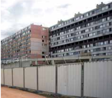
F29_ Bellefontaine, grandes bloques Maurois 2- Concorde antes de la demolición según el Grand Projet de Ville . 2.010.
