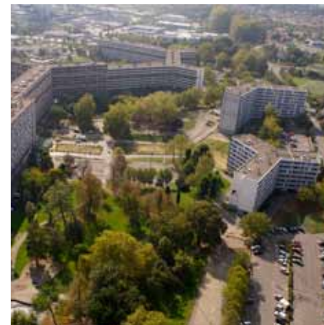
F38_ Bellefontaine, Grand Projet de Ville , resultado proceso demolición grandes bloques, Cité Jardin, Camus. 2.009.
