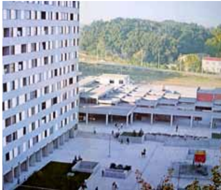
F12_ Bellefontaine, centro comercial -dalle- bloque Maurois I estado original realización antes demolición GPV. 1.971.
