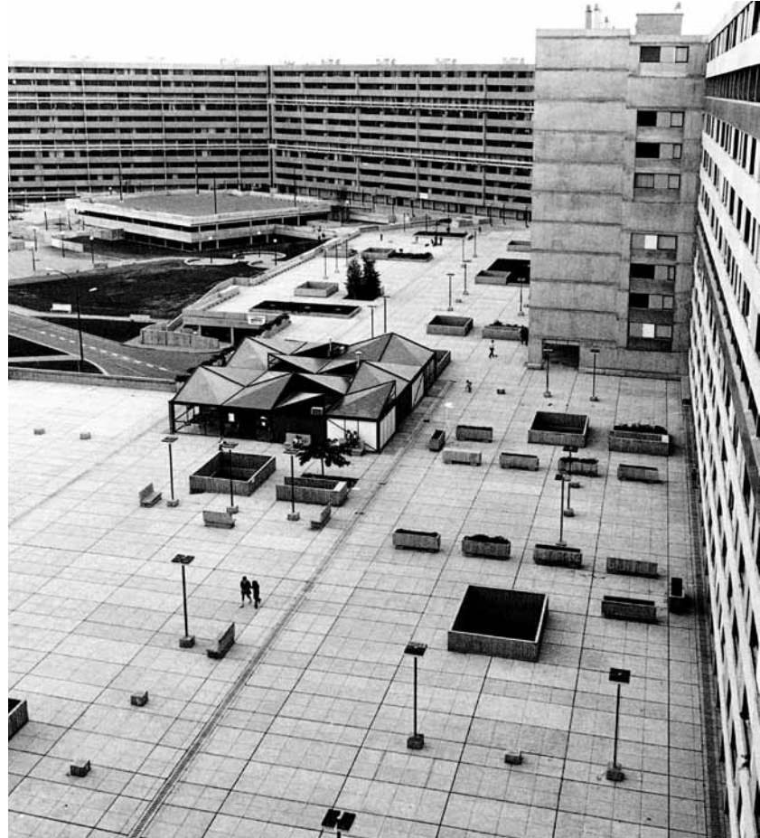
F57_ Bellefontaine, espacio público "dalle"-grandes bloques- centro social- jardin de infancia, 1.972. Vista hacia el Sur, grandes bloques tipo II. CAPA
