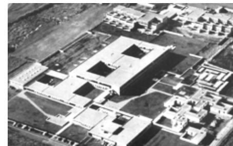
F99_ Bellefontaine, instituto secundaria, proceso construcción complejo docente, 1.971
