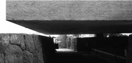
F11- F12 _ Mario Fiorentino y otros, Fosse Ardeatine, Roma, 1.947-49. Vista general y detalle ingresos-separación losa
