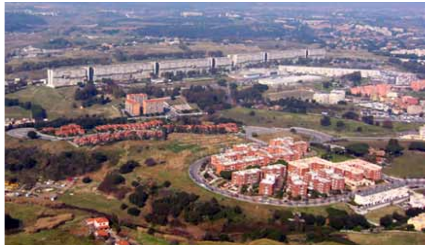
F42_ Corviale, vista area situación actual, crecimiento urbano tejido residencial zona Sur-Oeste Roma, 2.010
