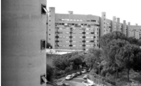
F12 _ Studio Passarelli, quartiere Vigne Nuove, PdiZ'7, Roma, 1.972-79. Edificio continuo-núcleos de escaleras
