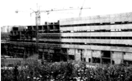
F76 _ Corviale, bloque puente 45°, proceso construcción, 1.975-82
