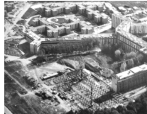
F46 _ Bellefontaine, proceso construcción: 1.967. Centro comercial. CAPA
