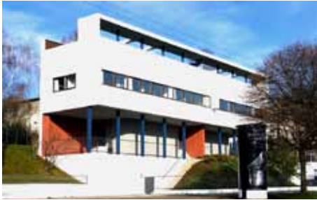
F09_ Le Corbusier, viviendas adosadas Weissenhof Siedlung, Stuttgart, 1.927. Situación en el presente, 2.011.
