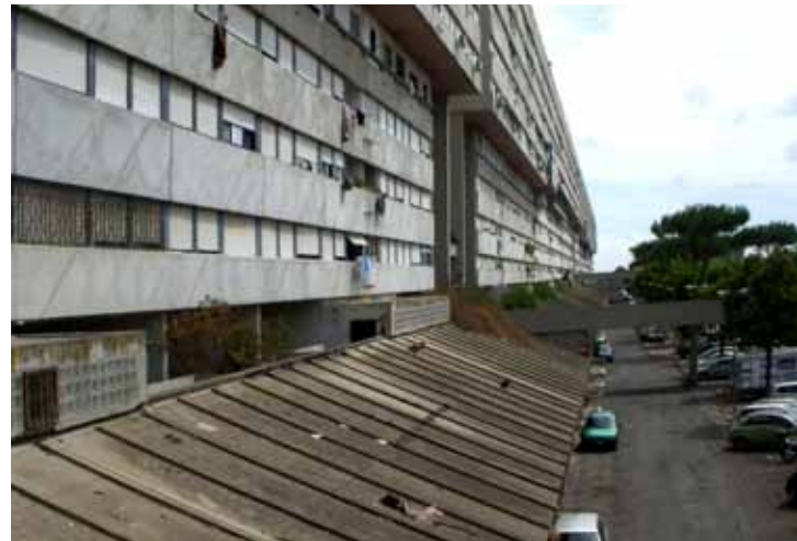
F9 _ Corviale, bloque principal, fachada Oeste, ocupación viviendas "cuarto piano"-pórtico planta baja, 2.011.
