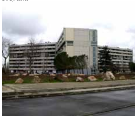
F56_ Reynerie, gran bloque Petit Varese, resultado demolición GPV bloque Grand Varese, acondicionamiento espacios públicos. 2.010.
