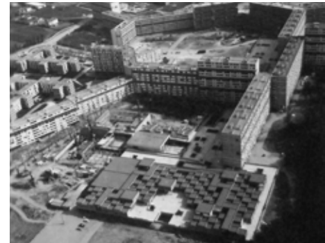
F49 _ Bellefontaine, proceso construcción: 1.970. Centro comercial. CAPA
