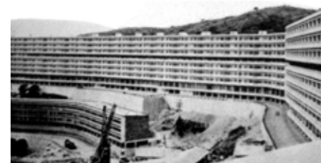
F8 _ Luigi C. Daneri, quartiere INA-Casa Forte Quezzi, Génova, 1.956-68.
