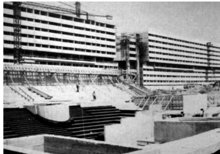
F37 _ Corviale, proceso construcción edificio I Corviale-centro y bloque principal, fachada Este, 1.975-82
