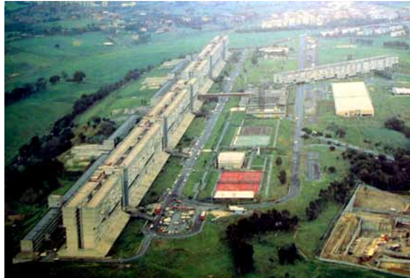
F41_ Corviale, proceso construcción equipamientos zona Este Piano di Zona, sobre 1.992
