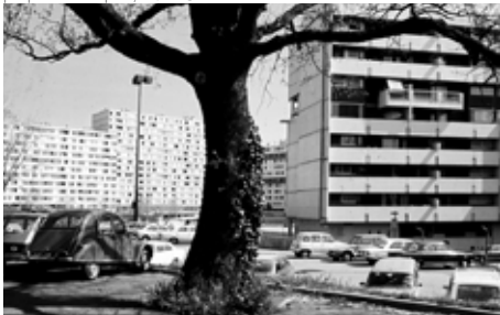
F56_ Bellefontaine, espacio público grandes bloques, tipo I y tipo II 1.972.CAPA
