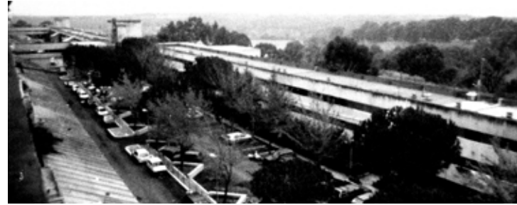
F70 _ Corviale, bloque paralelo fachada Este, vista desde el "cuarto piano" bloque principal, 1.982.
