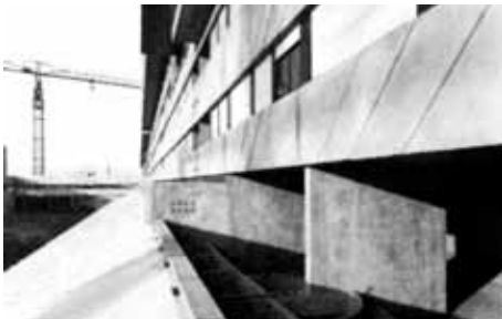
F50 _ Corviale, pórtico planta baja bloque principal y basamento aparcamientos, 1.982
