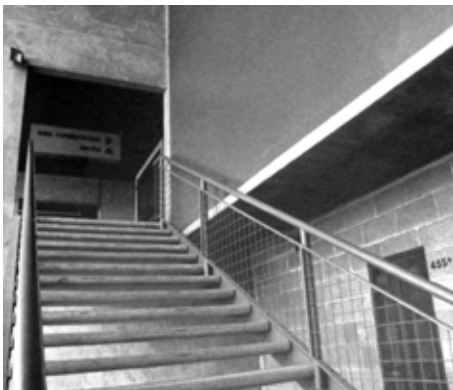
F56 _ Corviale, planta libre "cuarto piano" bloque principal, acceso salas de reuniones, 1.982
