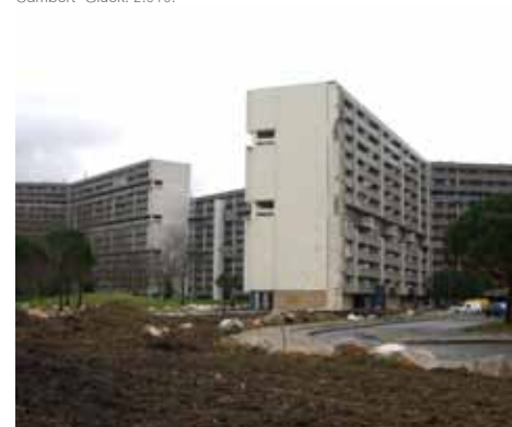
F57_ Reynerie, gran bloque Poulenc, resultado demolición GPV bloque Grand Varese, acondicionamiento espacios públicos. 2.010.
