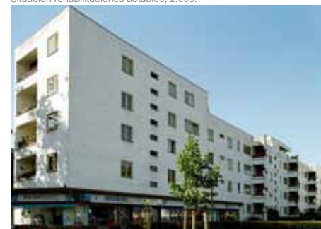
F12_ Hans Scharoun- director, Siemensstadt Siedlung, Berlín, 1929-1930. Situación rehabilitaciones actuales, 2.005.
