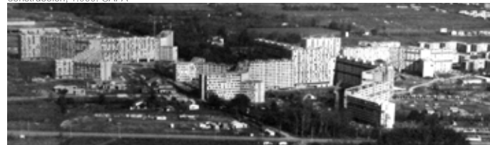
F18_ Toulouse le Mirail, Bellefontaine, estructura urbana grandes bloques, proceso construcción, 1.969. CAPA
