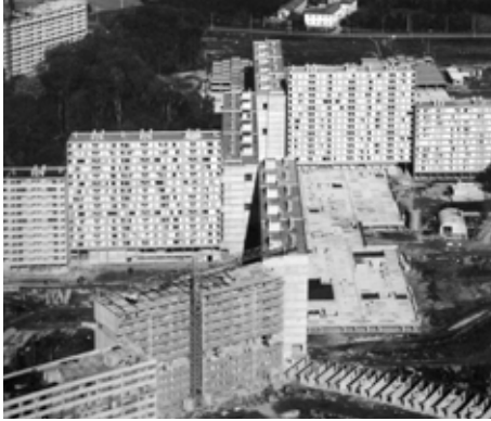
F51 _ Bellefontaine, proceso construcción: 1.970. Estructura elevada "Dalle"- Grandes bloques residenciales. CAPA
