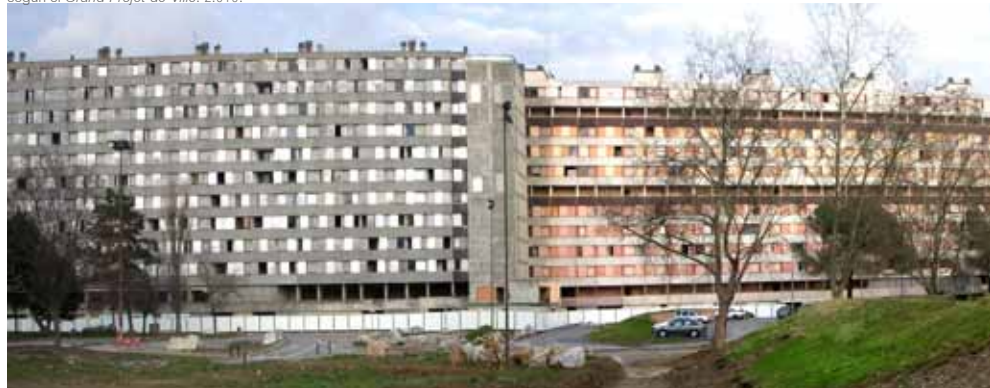
F33_ Bellefontaine, grandes bloques Maurois 2- Concorde antes de la demolición según el Grand Projet de Ville . Resultado demolición bloques Camus- Cité Jardín. 2.010.
