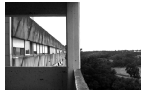
F74 _ Corviale, bloque paralelo fachada Oeste, vista desde la pasarela transversal, 2.010
