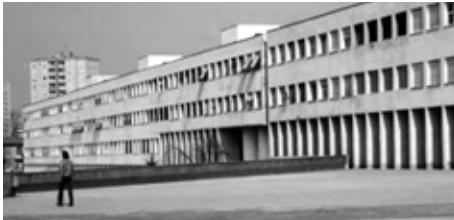
F9 _ Aldo Rossi, quartiere Gallarate, Milán, 1.967-74. Edificio norte
