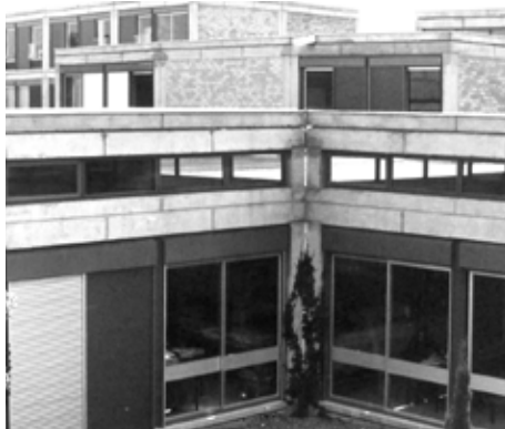
F117 _ Mirail, Facultad de letras patio interior, sobre 1.975. CAPA
