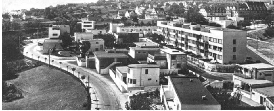
F9_Weissenhof siedlung,Stuttgart, 1.927. Vista general
