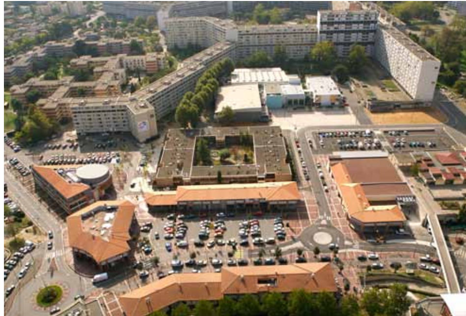
F16_ Bellefontaine, resultado DSQ demolición dalle- construcción nuevos equipamientos nivel cero. Resultado primera etapa GPV, demolición parcial centro comercial,- maison du quartier y construcción nuevo centro cultural Alban Minville, 2.009
