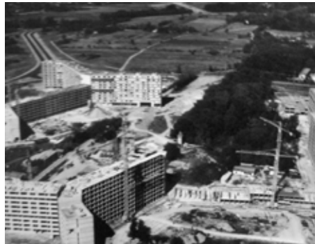
F48 _ Bellefontaine, proceso construcción: 1.968. Grandes bloques zona central-zona este- centro comercial. CAPA
