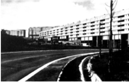
F75 _ Corviale, bloque puente 45°, pasaje transversal vehiculos, 1.982
