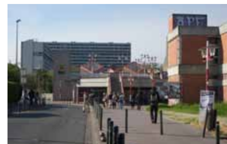
F59_ Mirail -Reynerie, pasarela de conexión, entrada metro y edificio centro comercial. 2.011.
