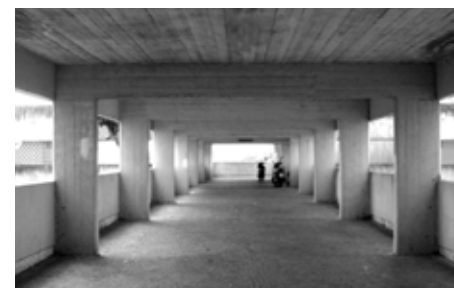
F26 _ Corviale, vista interior pasarela transversal hacia bloque paralelo, 2.010
