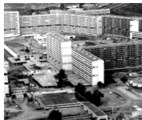
F103-F104 _ Reynerie, construcción "dalle"- grandes bloques, 1973. Pasarela conexión con Bellefontaine. CAPA
