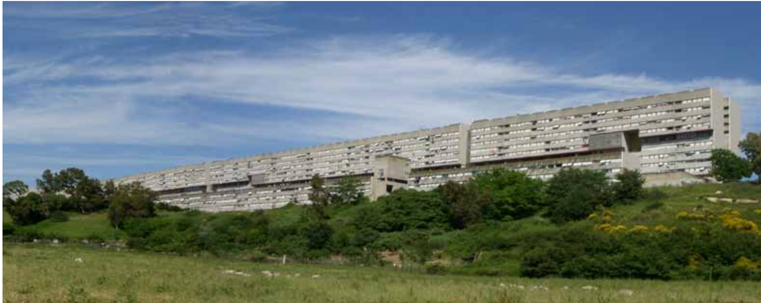
F30_Corviale, vista bloque paralelo y gran bloque principal en relación con el paisaje desde el sur-oeste, alzado hacia la "campagna romana"- fachada Oeste, 2.011
