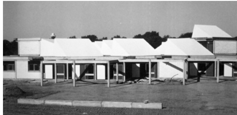
F127-F128_ Mirail, Escuela Arquitectura, vistas generales sistema modular, 1.970. CAPA
