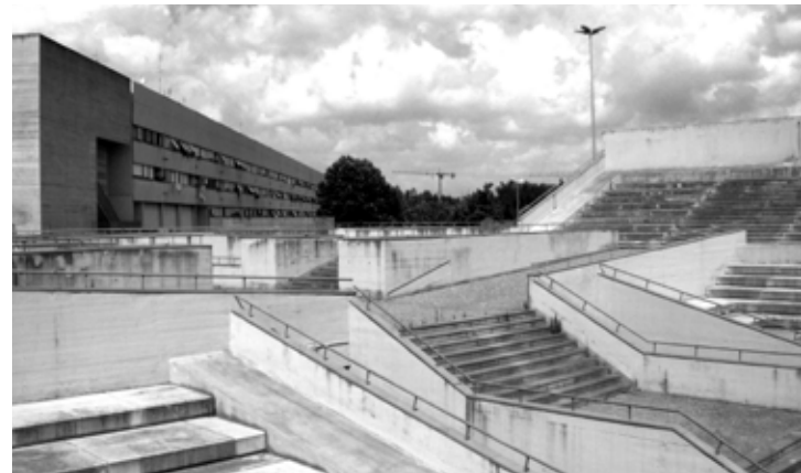
F89- F90_ Corviale, equipamientos exteriores zona centro, 2.010. Espacio público superior edificios I Corviale-Centro junto bloque puente 45°, y al fondo edificio II Corviale-centro
