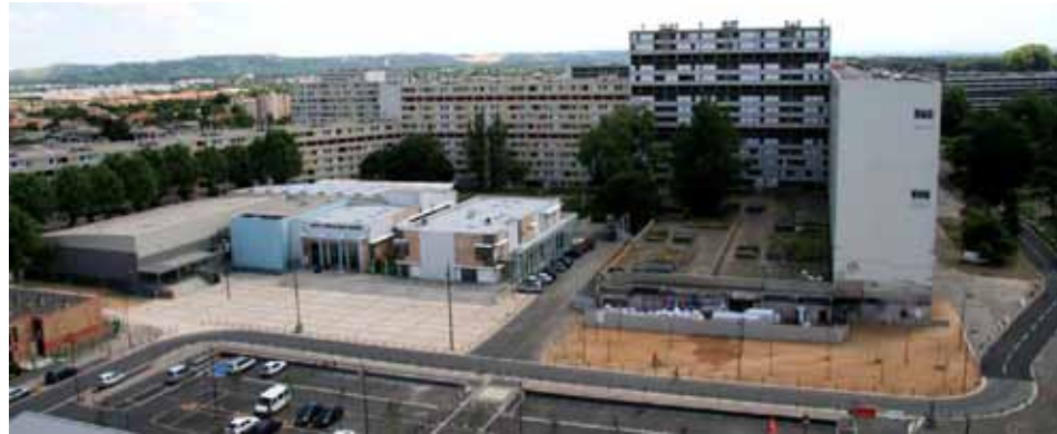
F15_ Bellefontaine, resultado primera etapa GPV, demolición parcial dalle- maison du quartier, construcción nuevo centro cultural Alban Minville, 2.009
