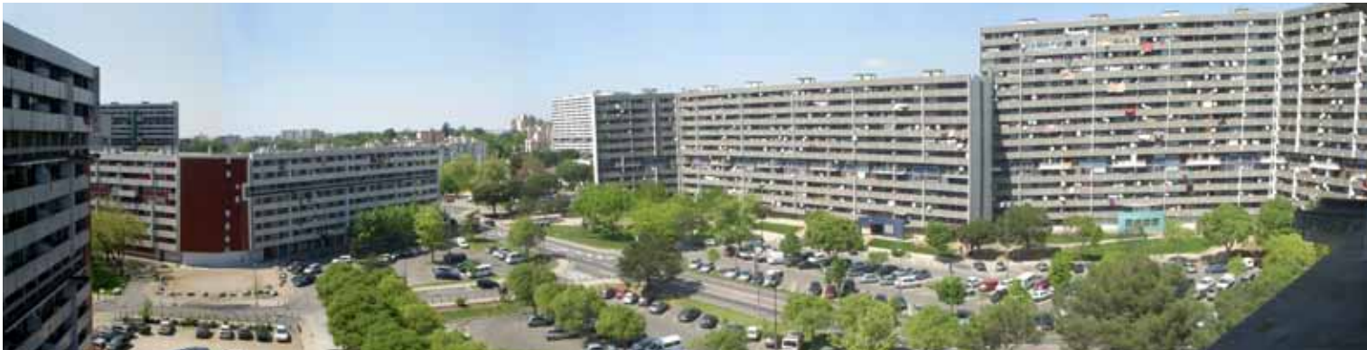
F61_Reynerie, Grand Projet de Ville , grandes bloques Petit D'Indy, Poulenc [futura demolición parcial], Messenger -resultado demolición parcial bloque Petit D'Indy. Rehabilitación aparcamiento y espacios público. 2.011.
