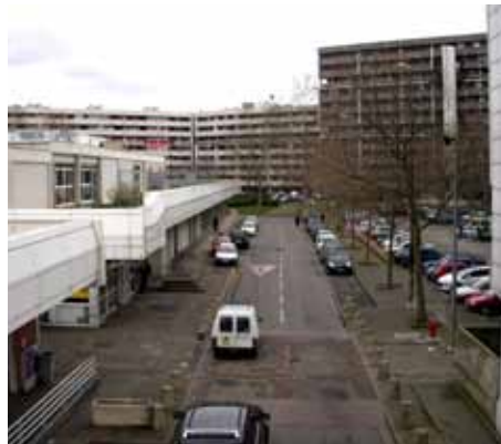
F53_ Reynerie, estado actual dalle centro comercial- gran bloque Petit D'Indy. 2.010.
