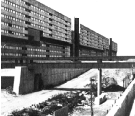
F32 _ Corviale, proceso construcción gran bloque principal, fachada Este, 1.975-82
