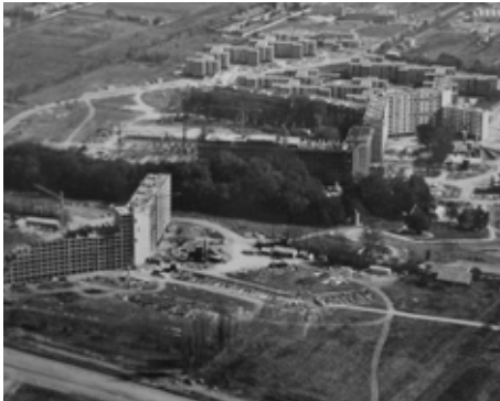
F44 _ Bellefontaine, proceso construcción: 1.967. Grandes bloques zona este-zona central, pequeños bloques. CAPA
