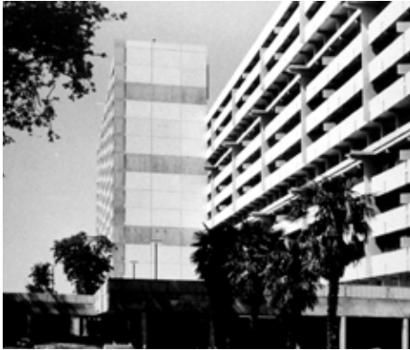
F108 _ Reynerie, grandes bloques y "dalle" de conexión con Bellefontainel, 1.974. CAPA
