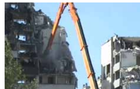
F24- F25_ Bellefontaine, demoliciones grandes bloques según intervención del GPV. 2.009
