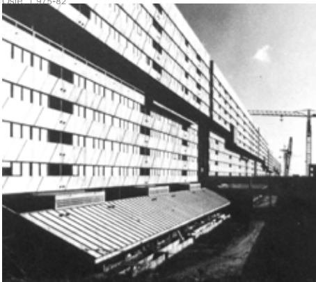
F34 _ Corviale, proceso construcción gran bloque principal, fachada Oeste, 1.975-82
