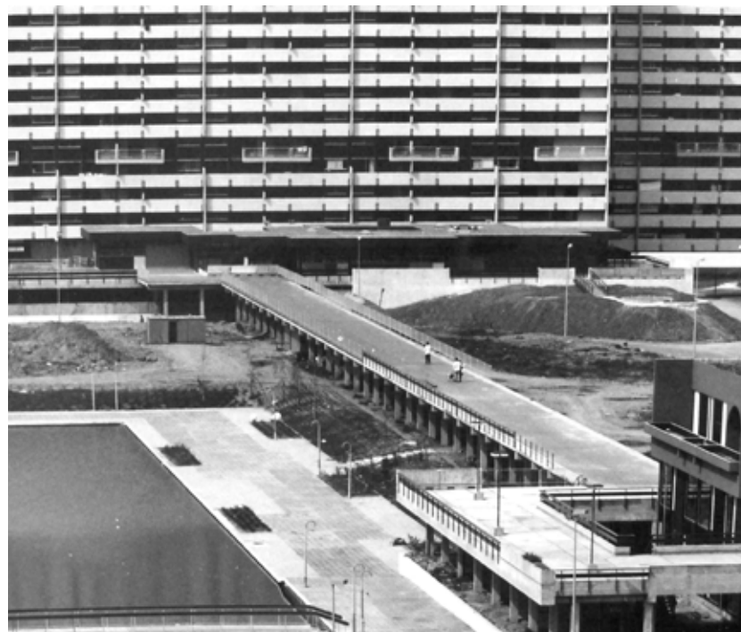
F105 _ Reynerie, detalle espacio urbano "dalle" paralelo al lago artificial, 1974. Modificación pasarela. CAPA
