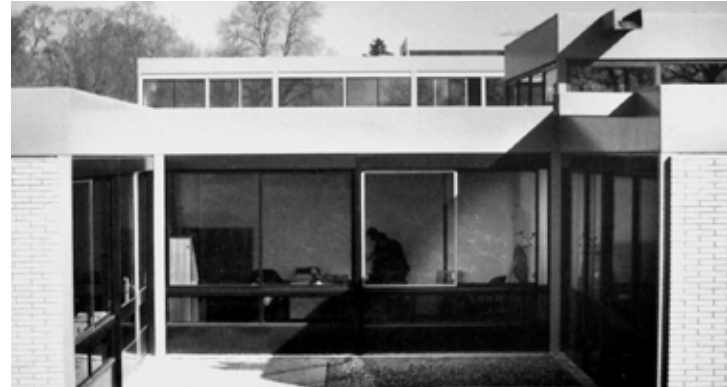
F120 _ Mirail, Facultad de letras, patio exterior y fachada, sobre 1.975. CAPA
