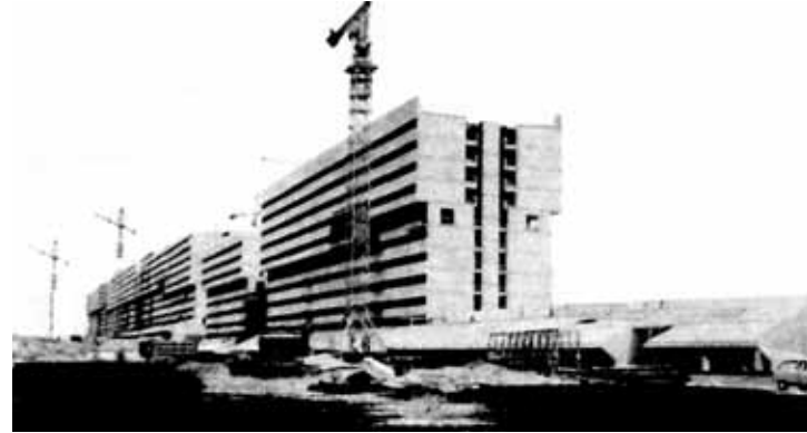
F35 _ Corviale, proceso construcción gran bloque principal, secuencia completamiento longitudinal, 1.975-82
