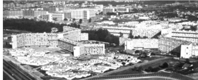
F16_ Toulouse le Mirail, Bellefontaine, estructura urbana grandes bloques- villas-patio zona Este, proceso construcción, 1.970. CAPA
