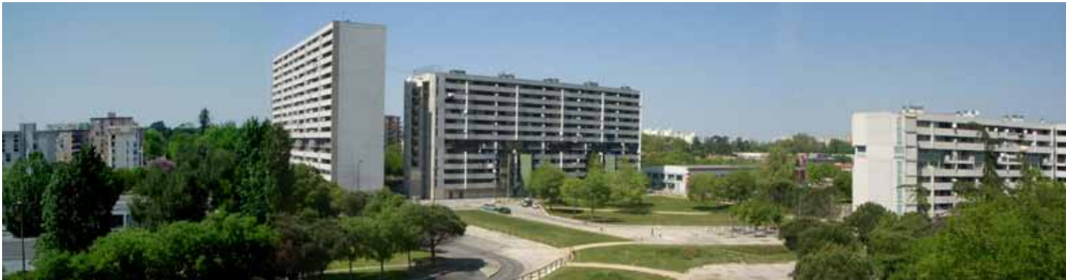
F60_Reynerie, Grand Projet de Ville , gran bloque Jean Gilles- resultado demolición grandes bloques Grand Varese.Rehabilitación espacios público. 2.011
