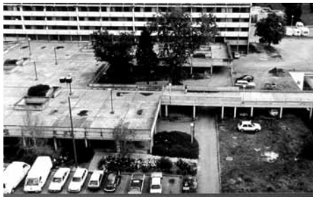
F23_ Reynerie detalle "dalle", sobre 1.980.
