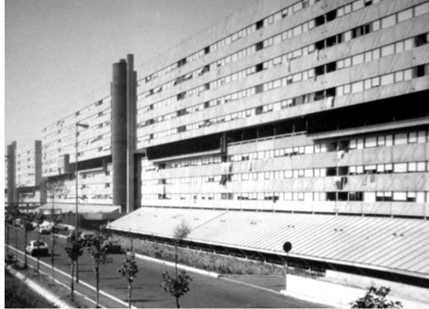
F44 _ Corviale, vista general bloque principal, relación basamento aparcamientos-"plazas" de ingreso-"cuarto piano", fachada Este, sobre 1.985
