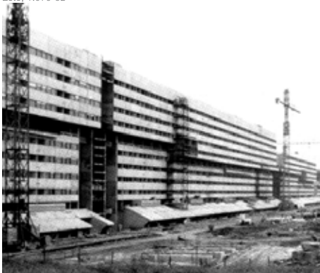
F33 _ Corviale, proceso construcción gran bloque principal, fachada Oeste, 1.975-82
