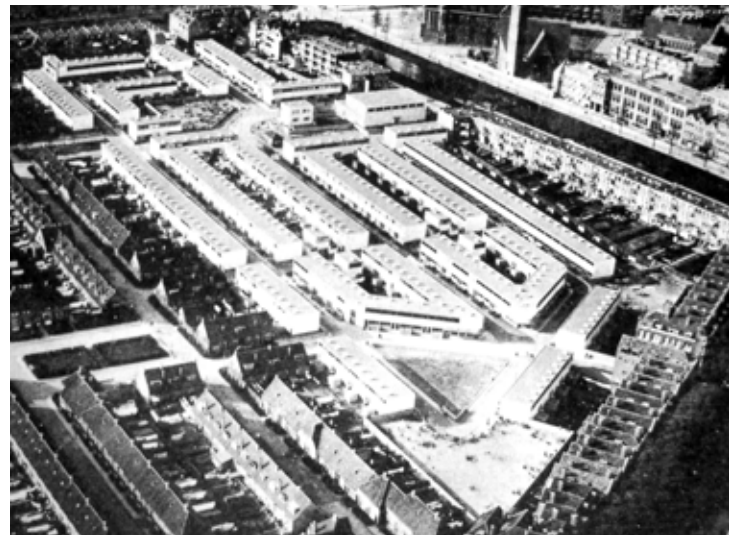
F33 _ J.J.P. Oud, barrio Kiefhoek, Rotterdam, 1.925-29. Vista general
