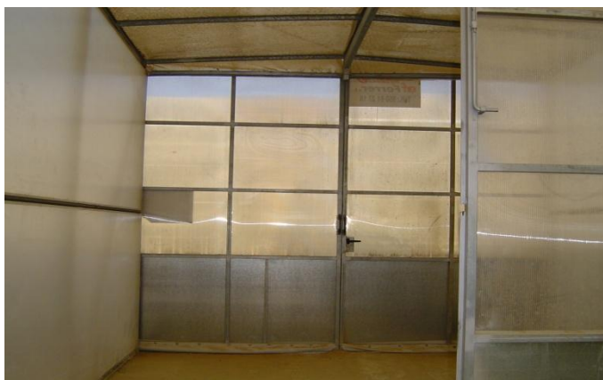
Fotografía n° 27. Detalle de una de las dobles puertas del invernadero.
