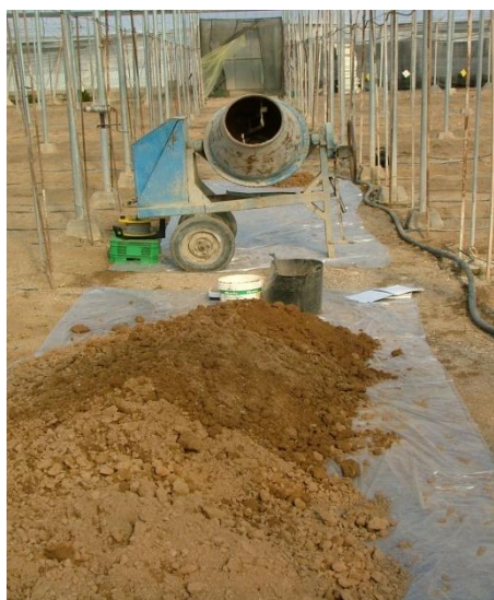
Fotografía nº 52. Preparación de las operaciones de mezclado.
