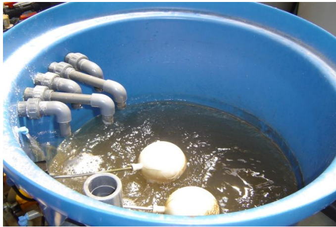
Fotografía n° 30. Detalle del interior del tanque de mezcla.
