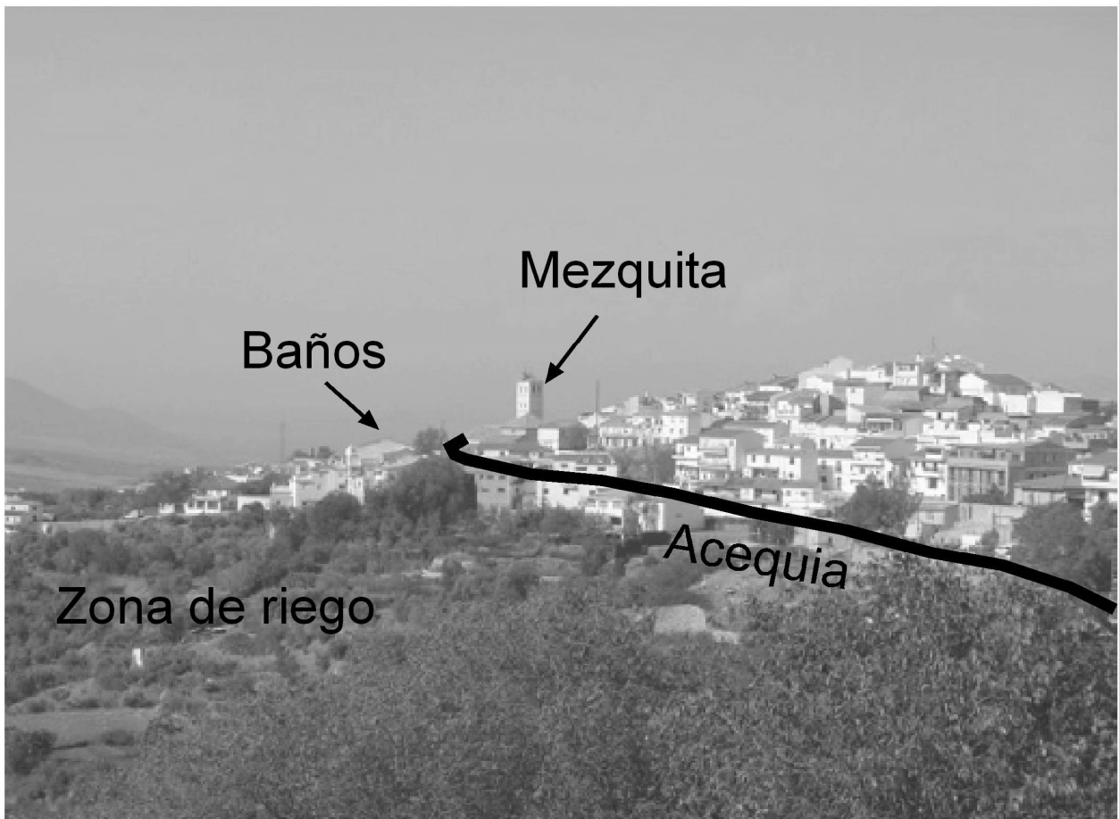
Figura 9. Alquería de Cogollos. Fotografía actual con indicación de los principales elementos que la configuraban en época medieval.
