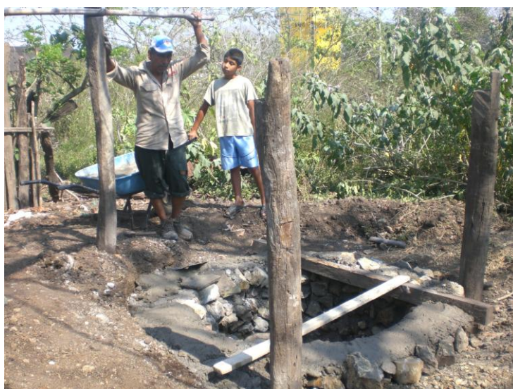
Figura 9. Proceso de construcción de una fosa séptica.
