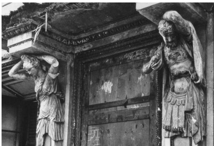
Link 26. Dettaglio da cui si può desumere la conformazione strutturale del ballatoio in un tratto intercorrente fra una cariatide e un telamone (Archivio Fototeca Treccani – Istituto Lombardo Accademia di Scienze e Lettere). *Detalle del cual se puede desumir la conformación estructural del balcón corrido en un tramo sostenido entre una cariatide y un telamón (Archivio Fototeca Treccani – Istituto Lombardo Accademia di Scienze e Lettere).*
