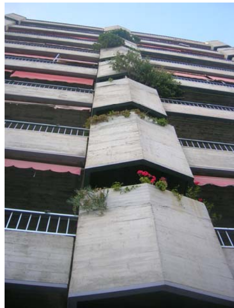
Edificio en El Altillo Almuñécar, 1967
