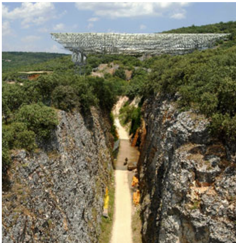
Figura 6.2: Fotografía de la Trinchera del Ferrocarril.
