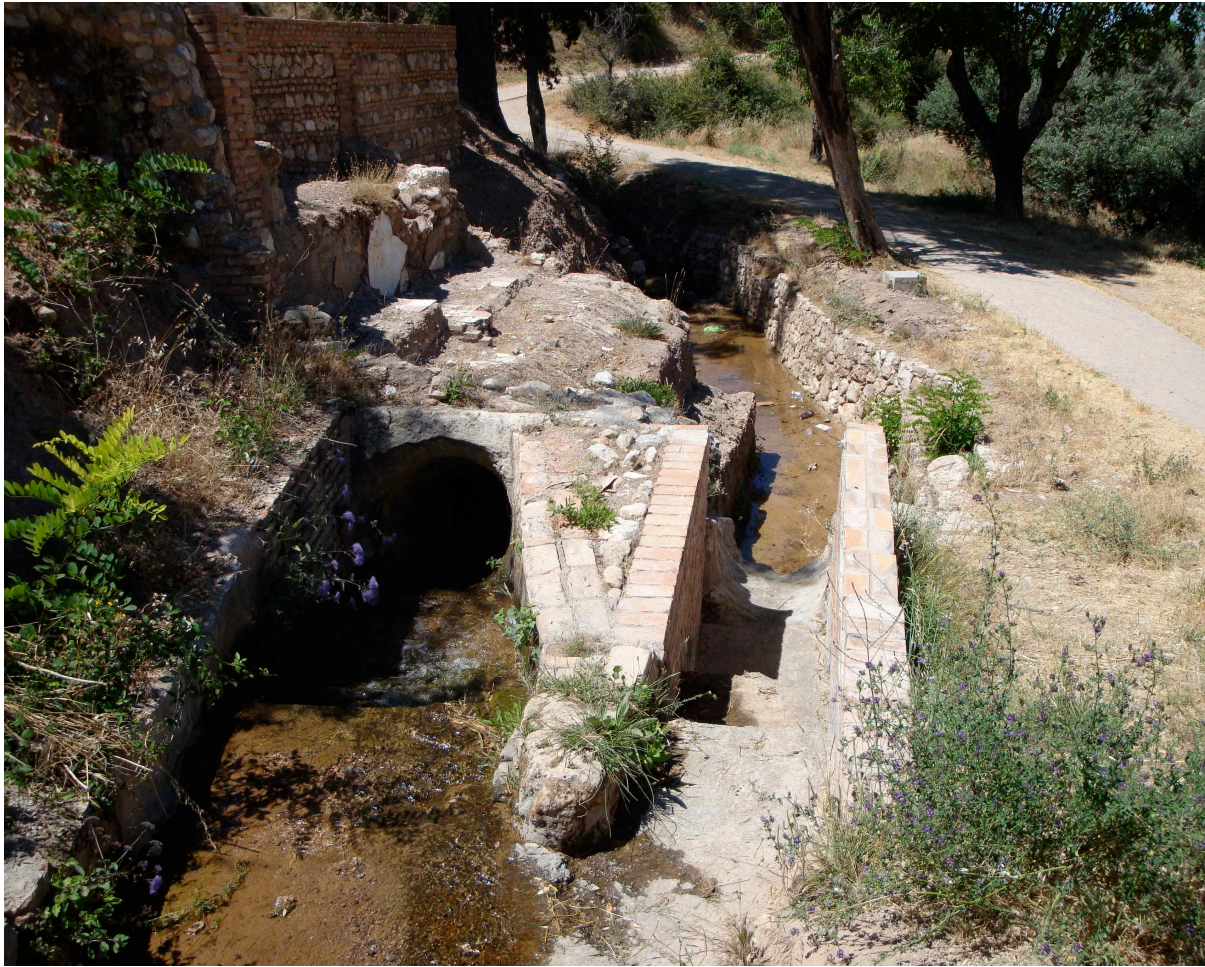
Figura 18: Restos del Molino de las Pasaderas, en las cercanías de Víznar. Hoy, como vemos, profundamente modificado
