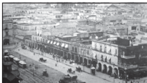
Demolición del Portal de Mercaderes y nuevo Portal de la Flores, 1902.
