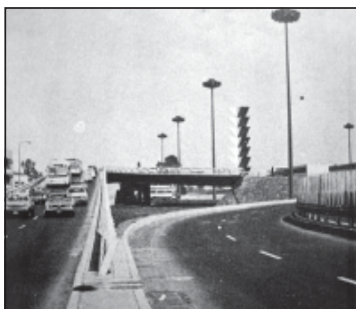
Diferentes tipos de luminarias para vías de circulación, incluyendo las vías rápidas
