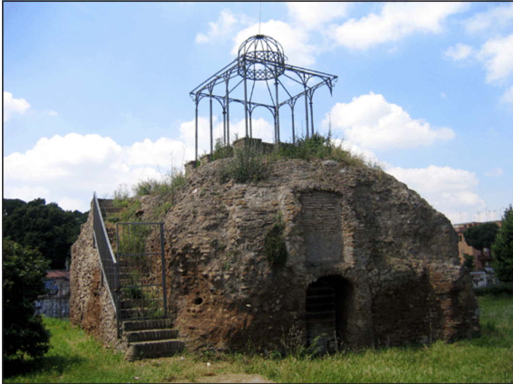
Kiosco en hierro fundido sobre una ruina arqueológica en Villa de Sanctis (Via Casilina, Roma), Fotografía de Vieri Quilici / Romina Peritore, 2008.
