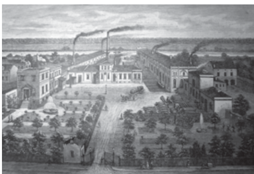
Páginas del catálogo promocional de la Mexican Development Company: una hidroeléctrica y la planta de generadores.
