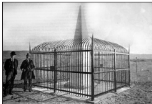
Arriba: Monumento a Morelos en la Plazuela de Guardiola. Abajo: obelisco conmemorativo del trazado de la carretera a Pachuca protegido del vandalismo.
