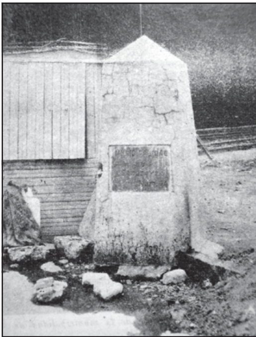
Imagen de la casa de bombas de agua de la Colonia Condesa -traladada en los años setenta a Tlalpan y convertida en casa de la Cultura de esa delegación-; abajo: Hito que marca el límite de las municipalidades de México y Tacubaya.
