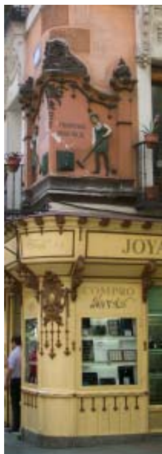
Fachada de trampantojo imitando elementos en hierro, Calle Mayor, Madrid.
