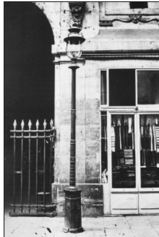
Cuatro modelos de luminarias en hierro francesas que podían ser adaptadas a cualquiera de las tres tecnologías de alumbrado (aceite, gas, electricidad), ca. 1890.
