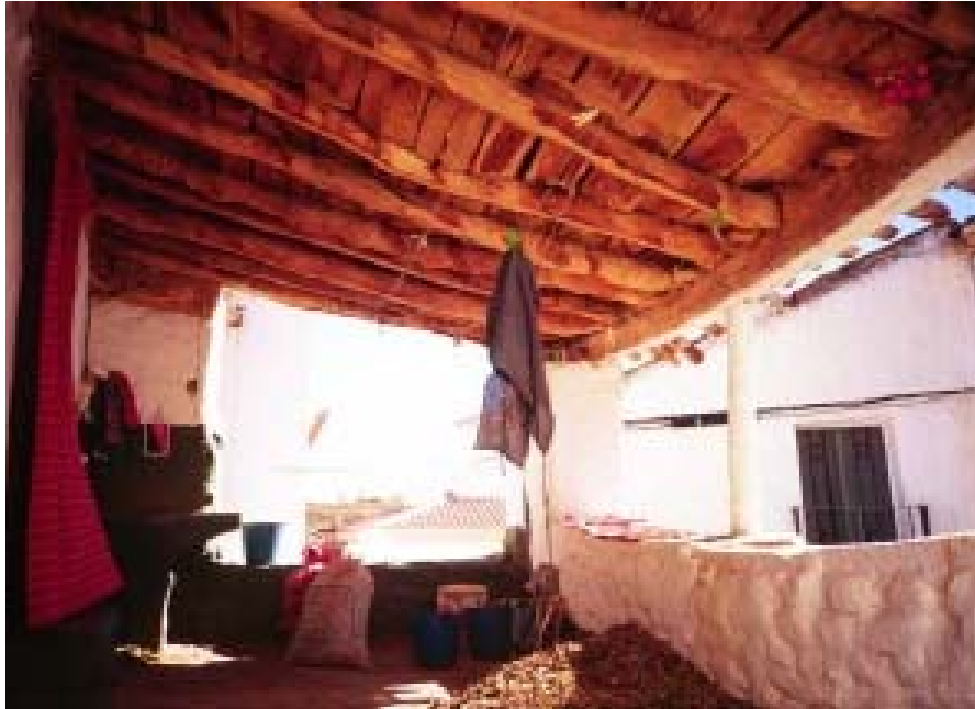
Figura 9. Detalle constructivo en Polícar. Techumbre de vigas y rollizo de madera
