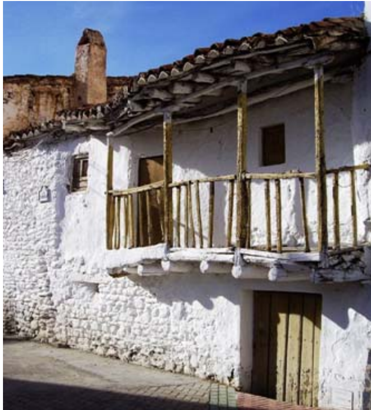
Figura 7. Vivienda de origen morisco en Jérez del Marquesado
