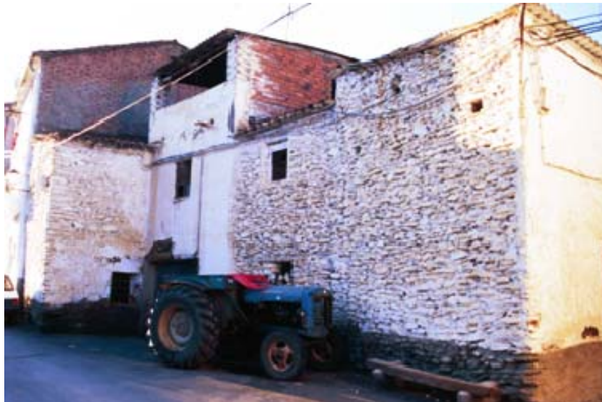
Figura 8. Construcciones de mampostería en Huéneja
