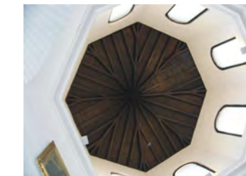
Vista interior del cimborrio
