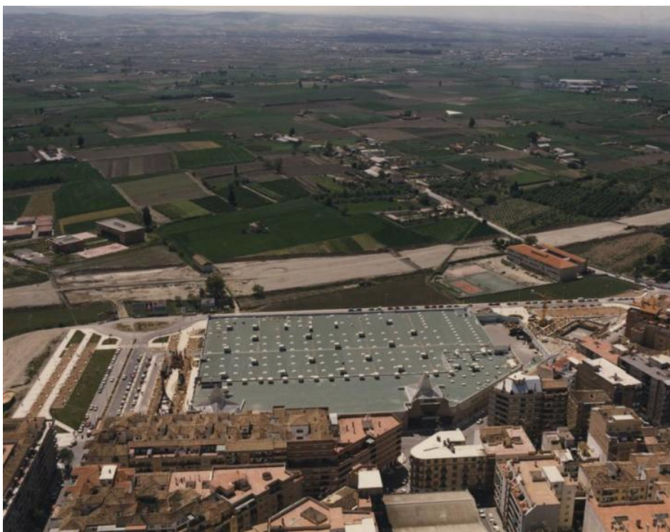
Figura 3-24: Obras de construcción de la A-44 a su paso por Granada en 1988. La elaboración de la ronda de circunvalación supuso una ruptura de la conectividad entre la ciudad de Granada y el paisaje agrario de la AUG.
