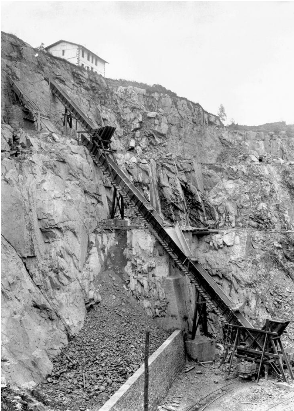
Instalación de carros metálicos de bajada de piedra de las canteras de Añorga. (192?). Fototeca. Museum Cemento Rezola. Donostia - San Sebastián
