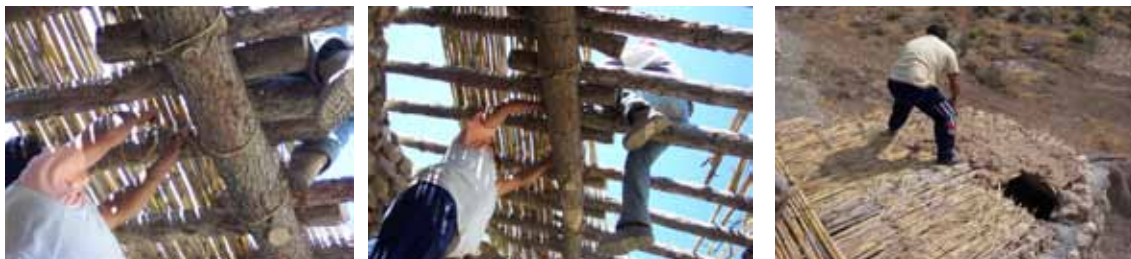
Foto 3.45. Construcción de techumbres planas en torres y bastiones.
