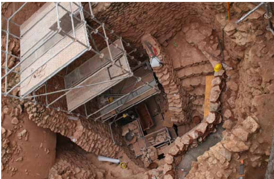
Foto 5.41. Trabajos de restauración en el pozo.
