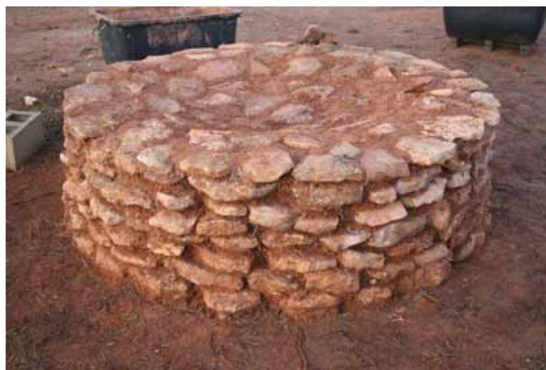
Foto 5.24. Base de la estructura de combustión con zócalo de mampostería.
