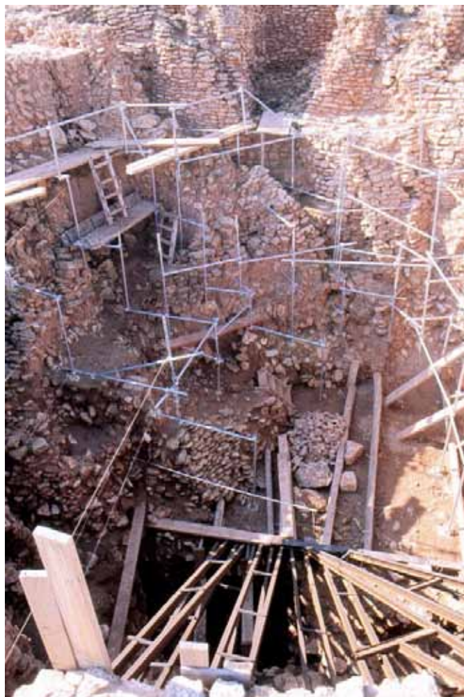
Foto 5.4. Los sistemas de entibes y andamios colocados.
