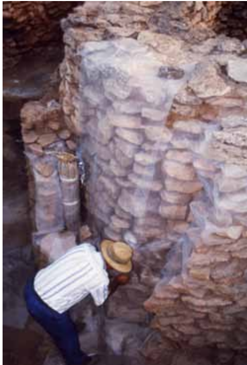
Foto 5.31. Detalle de la colocación de malla pvc separando las partes originales de las restauradas .
