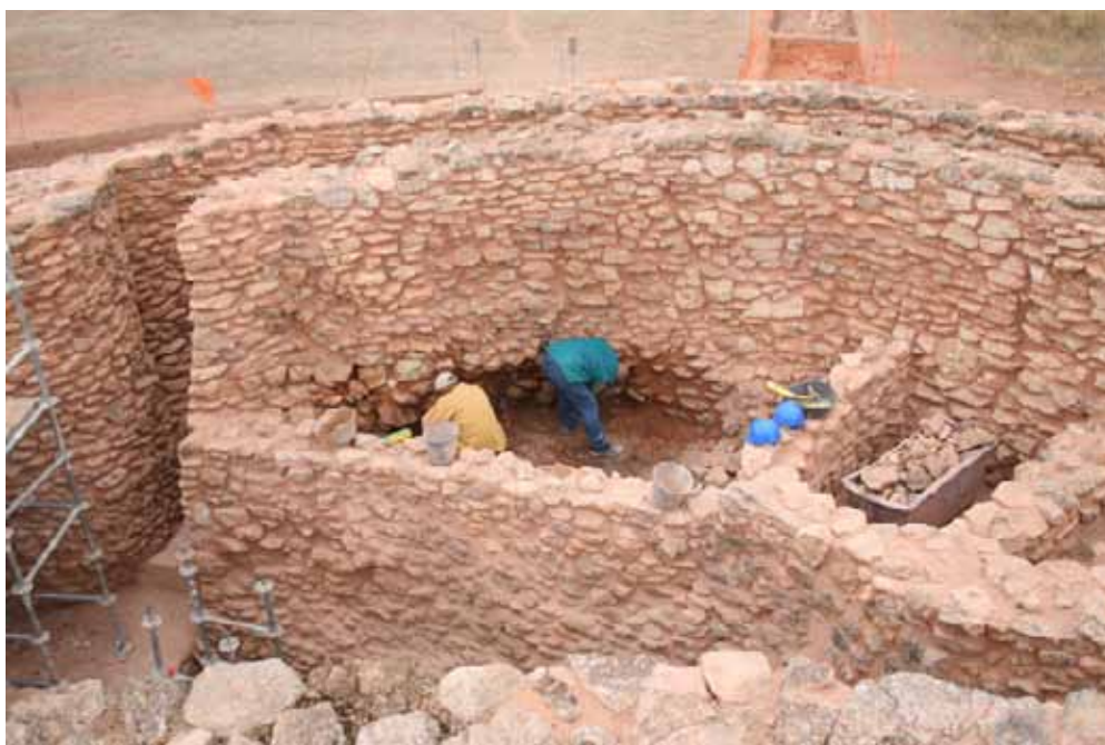
Foto 5.43. Detalle de los trabajos de restauración en el recinto intermedio.
