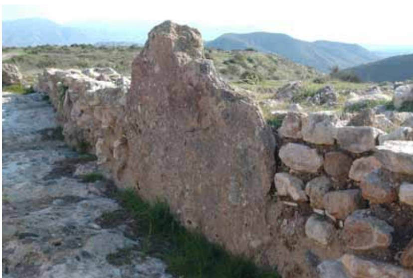
Foto 3.8. Ortostatos de la Muralla I.
