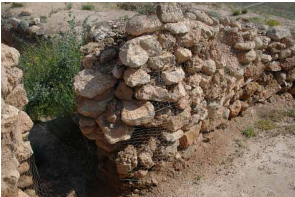
Foto 3.28. Malla de protección dispuesta sobre los paramentos del Fortín I.
