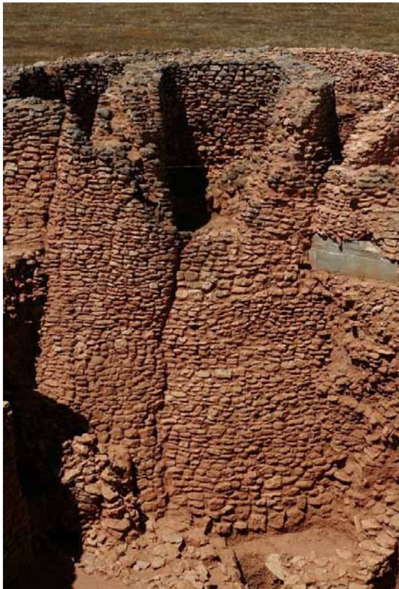
Foto 5.18. Detalle de las mamposterías de la torre.
