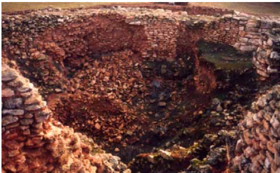
Foto 5.3. Vista panorámica antes del inicio de los trabajos en el patio durante el año 1999.
