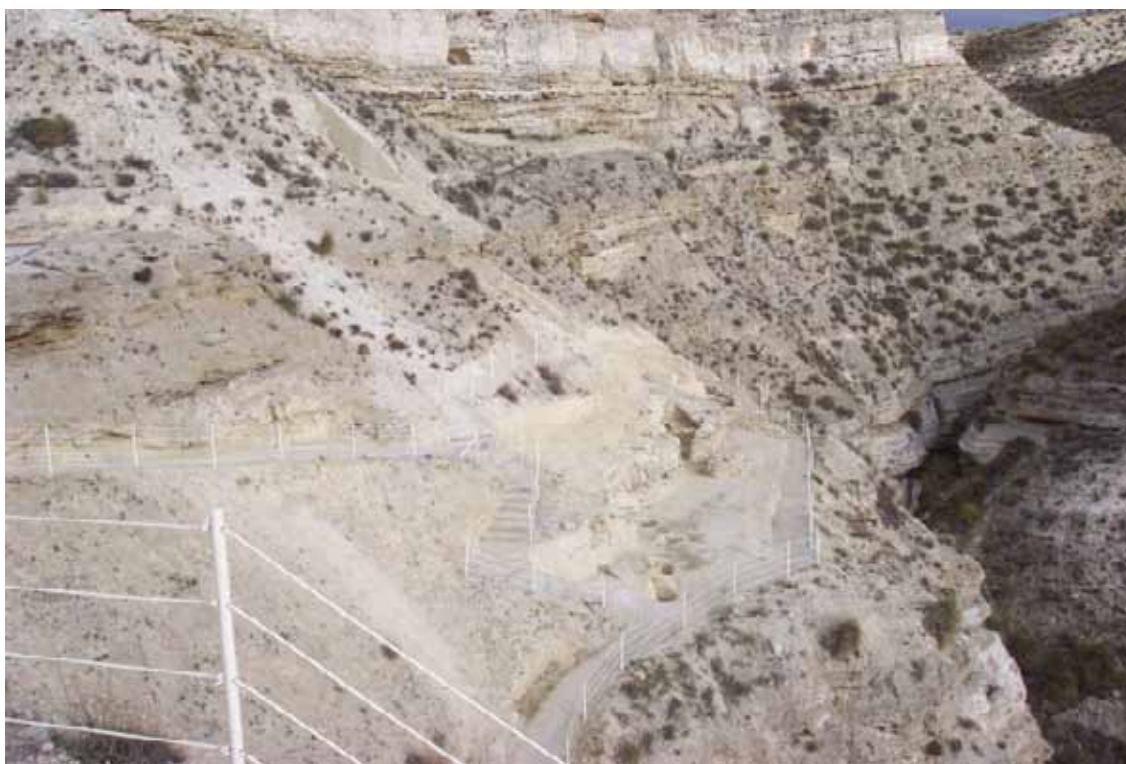
Foto 4.18. Sistemas de protección para los recorridos
