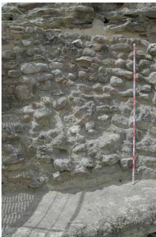
Foto 4.8. Muestreo edificio 2. Muralla de la acrópolis. Zona Norte
