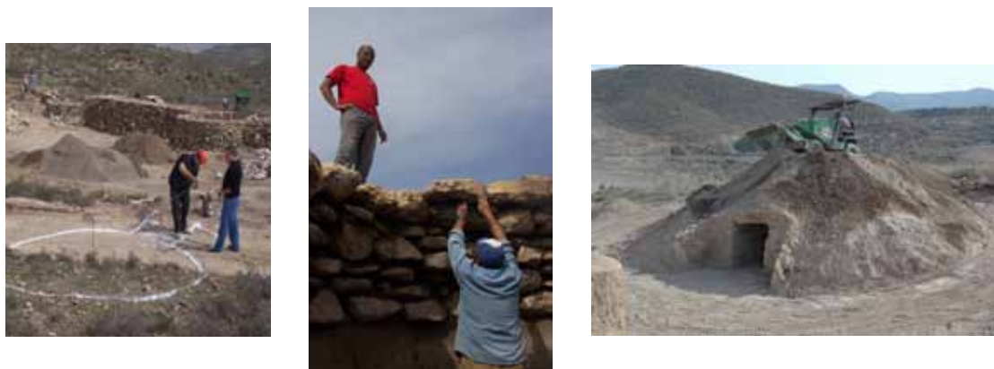
Fotos 3.39, 3.40, 3.41. Proceso constructivo del tholoi: cimentación, proceso de construcción y acabado
