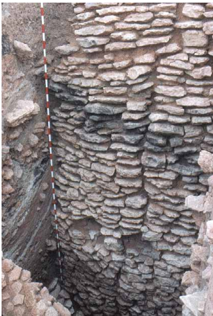
Foto 5.17. Detalle paramento de la muralla.
