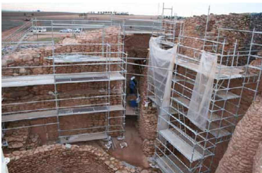
Foto 5.5. Trabajos de consolidación arquitectónica en el patio fortificado.
