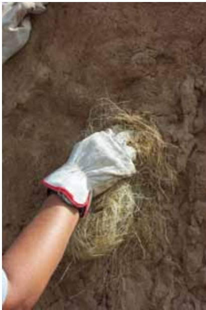
Foto 3.38. Proceso de acabado para evitar el cuarteamiento del mortero de revoco
