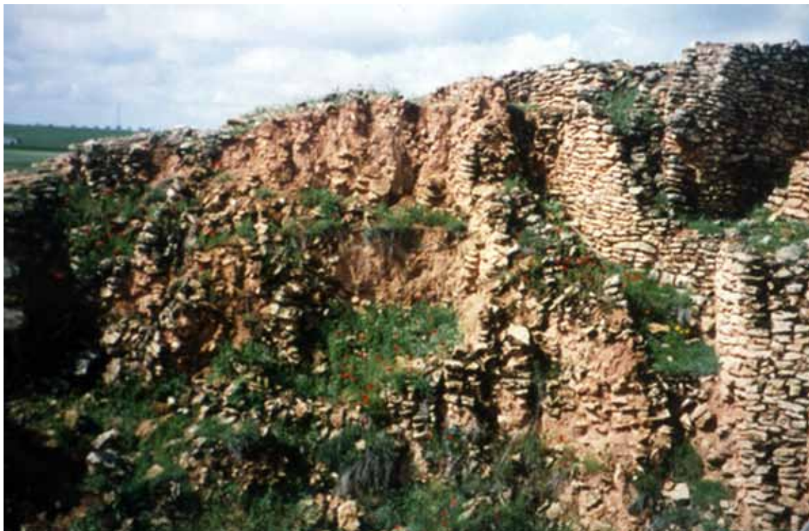
Foto 5.27. Estado de conservación del patio en 1999.
