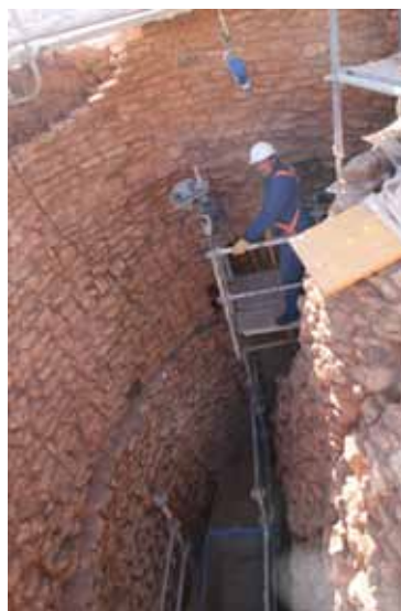
Foto 5.32. Detalle de la restitución del pasillo intermedio en la zona del patio.
