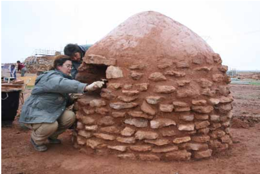
Foto 5.26. Tareas de acabado de la bóveda de barro de la estructura de combustión.
