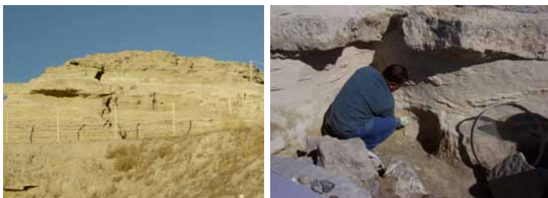
Fotos 4.23 y 4.24. Restauración del frente rocoso del Complejo Estructural 6 y CE 3.
