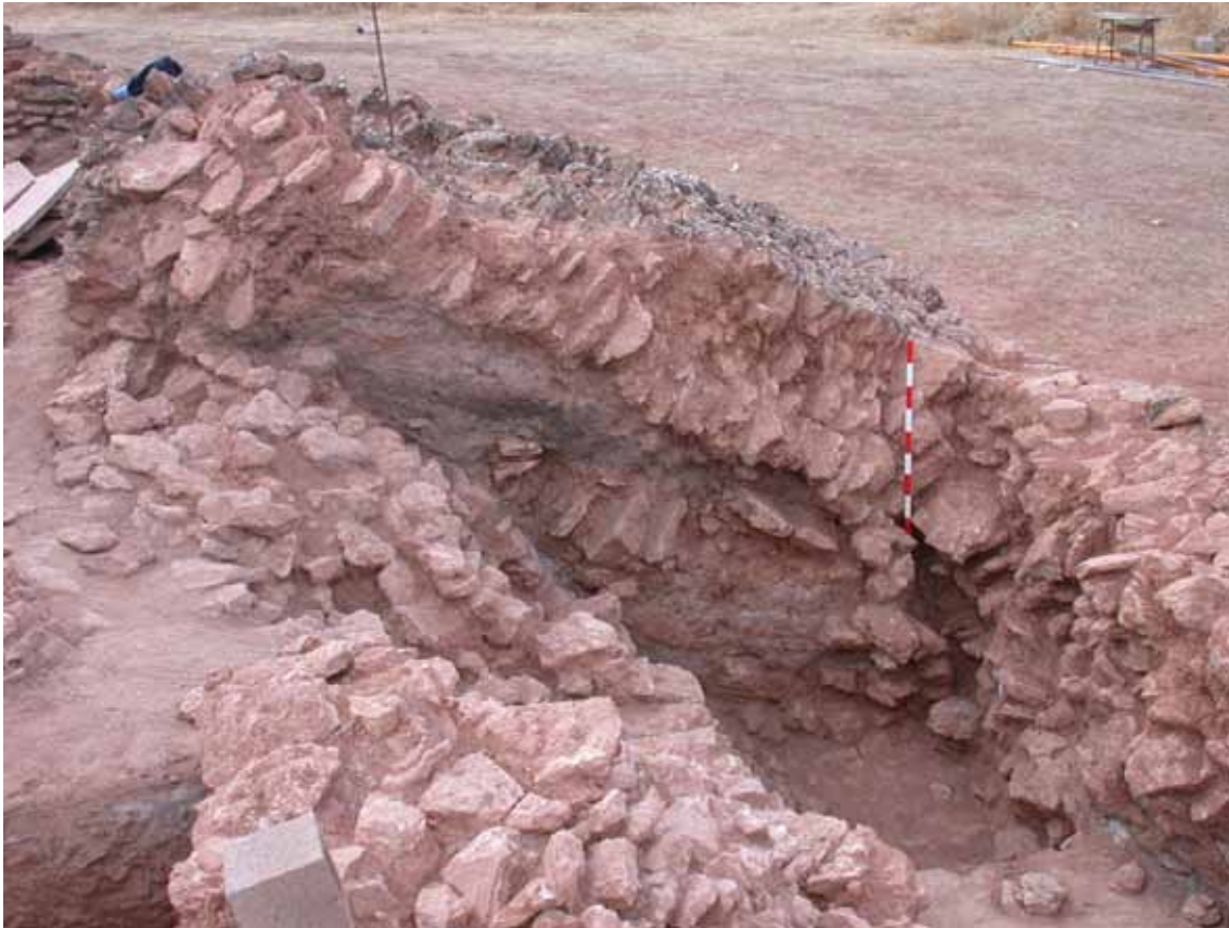
Foto 5.10. Vencimiento de la muralla exterior.
