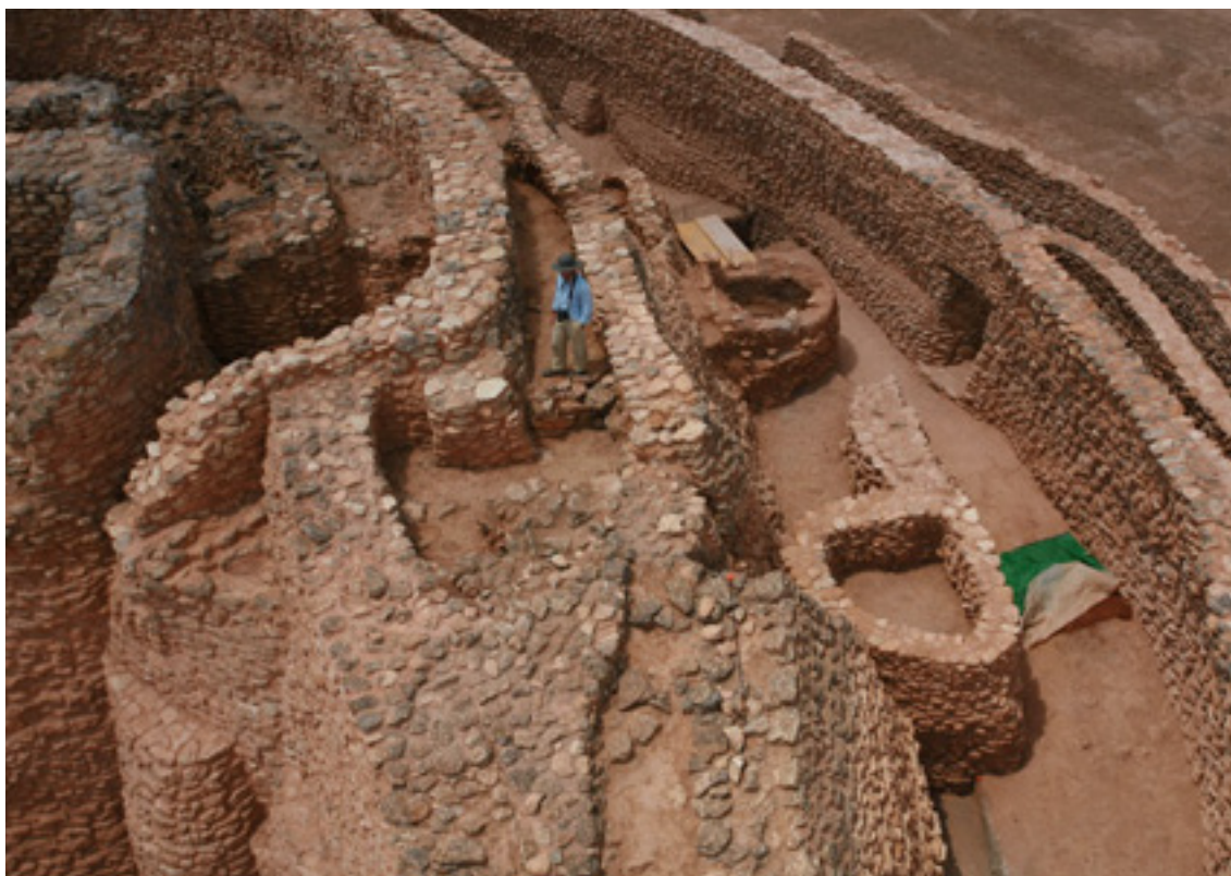
Foto 5.6. Construcción de itinerarios en la zona norte de la fortificación.
