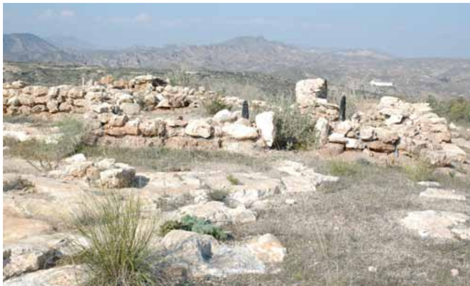
Foto 3.30. Estado actual de conservación del Fortín V.
