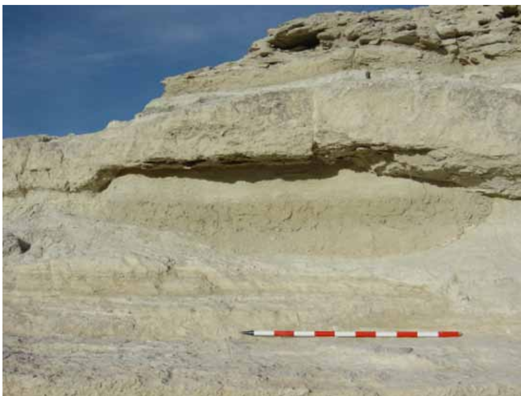
Foto 2.5. Consolidación de frente alterado por la erosión. Castellón Alto.
