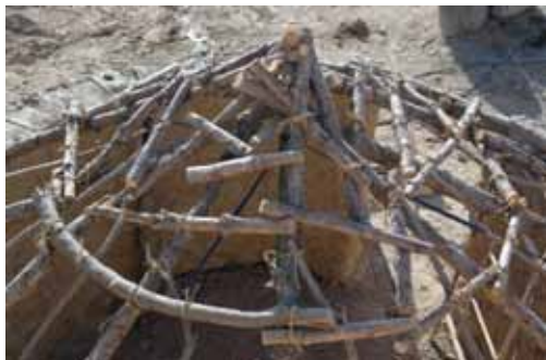
Fotos 3.46, 3.47. Estructura de la techumbre de una cabaña
