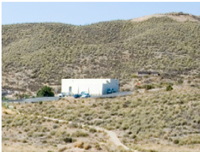
Foto 3.32. Centro de Recepción. Venta de Los Millares.
