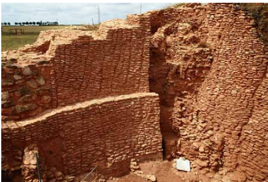
Foto 5.39. Detalle del Frente Sur del Patio tras la consolidación arquitectónica.
