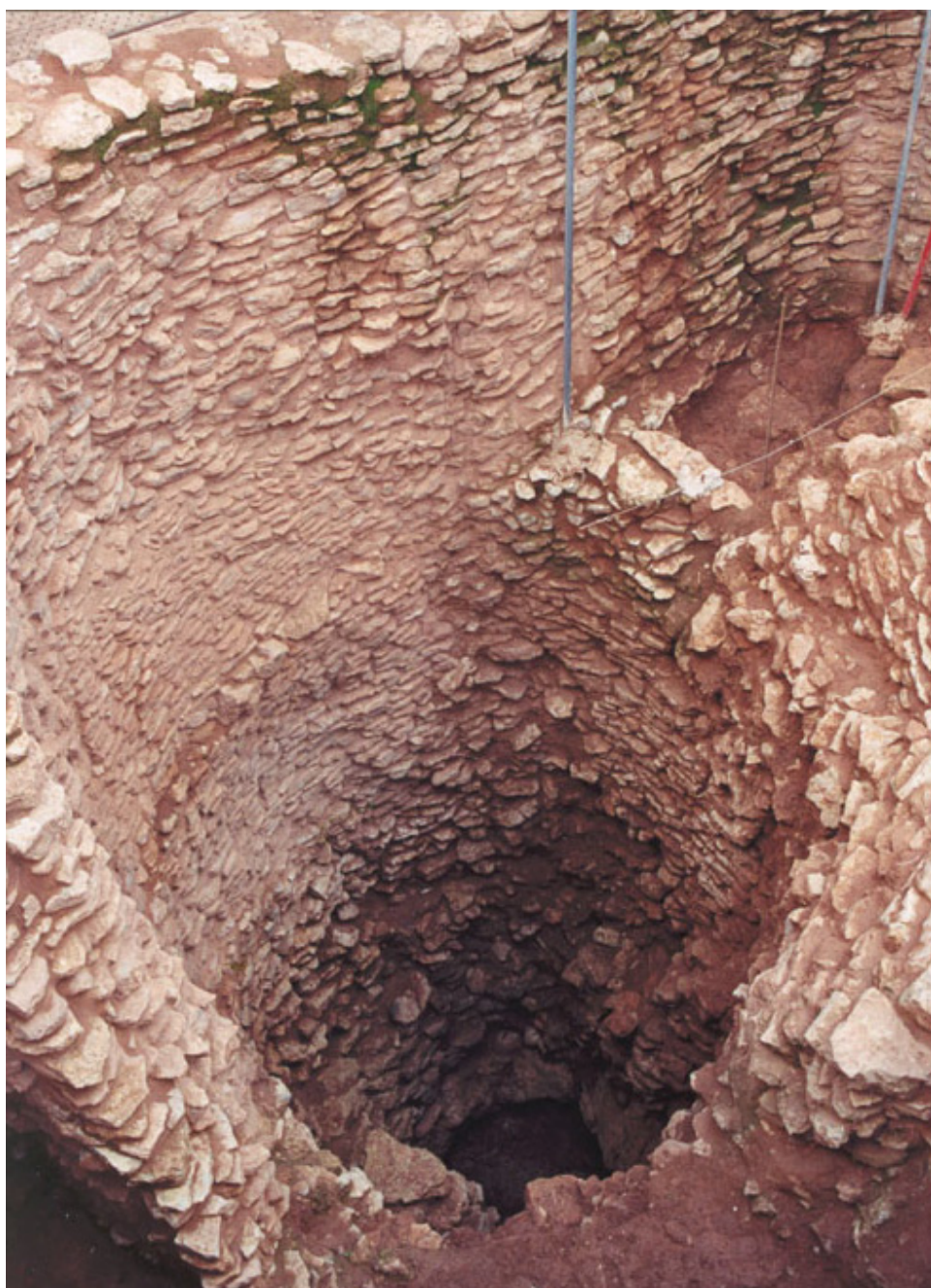
Foto 5.9. El pozo tras su excavación.
