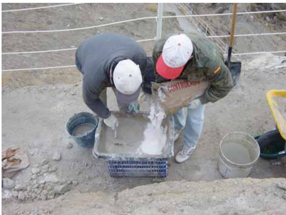
Foto 4.19. Amasado del mortero de yeso y margas yesíferas.
