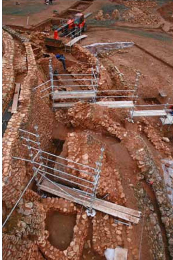
Foto 5.42. Vista general de la muralla exterior tras los trabajos de consolidación arquitectónica .
