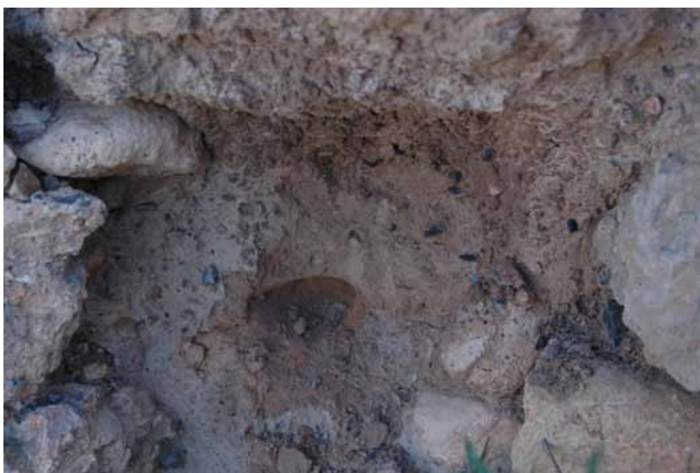
Foto 3.19. Detalle del mortero de mampostería del Fortín I (LM MM7)
