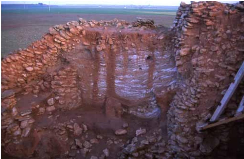
Foto 5.35. Inclinación de la Muralla exterior en algunas zonas.
