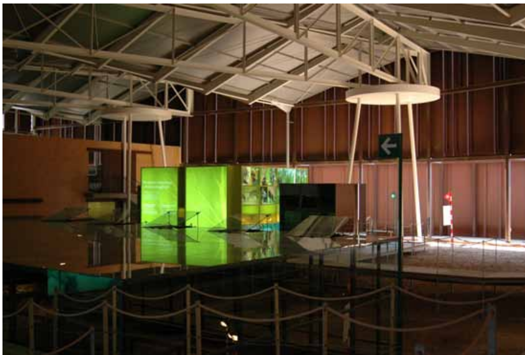
Foto 2.8. Sistema de cubierta de Minas de Gava.
