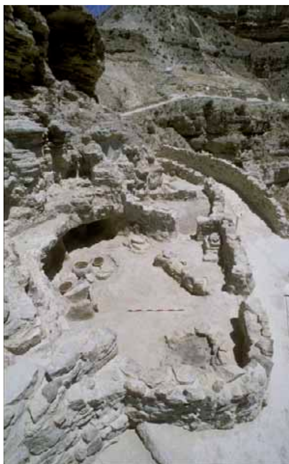
Foto 4.27. Complejo Estructural 14 tras los trabajos de restauración.
