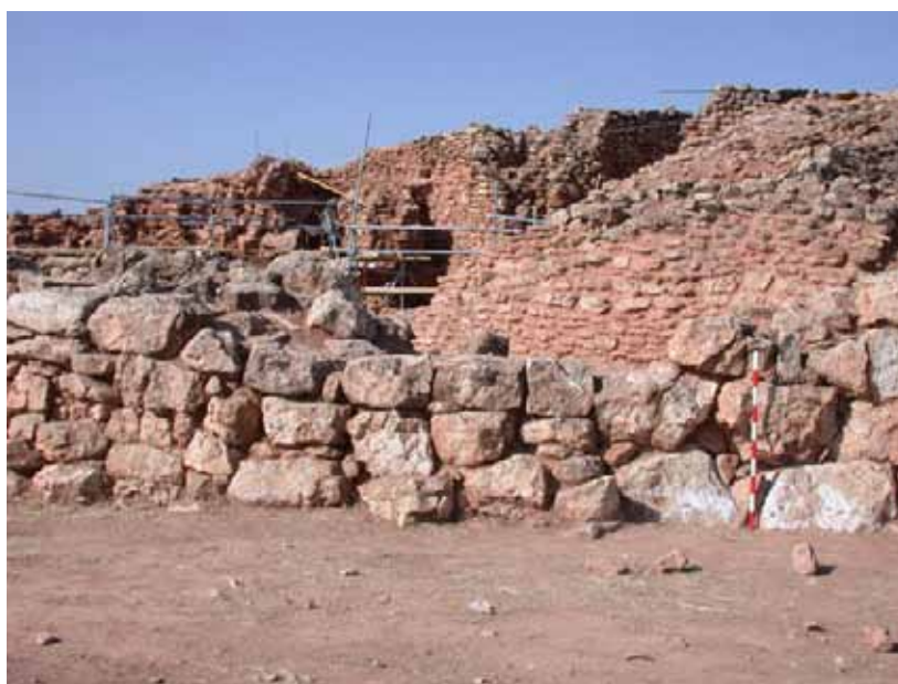
Foto 5.15. Muralla exterior. Detalle del paramento ciclópeo.
