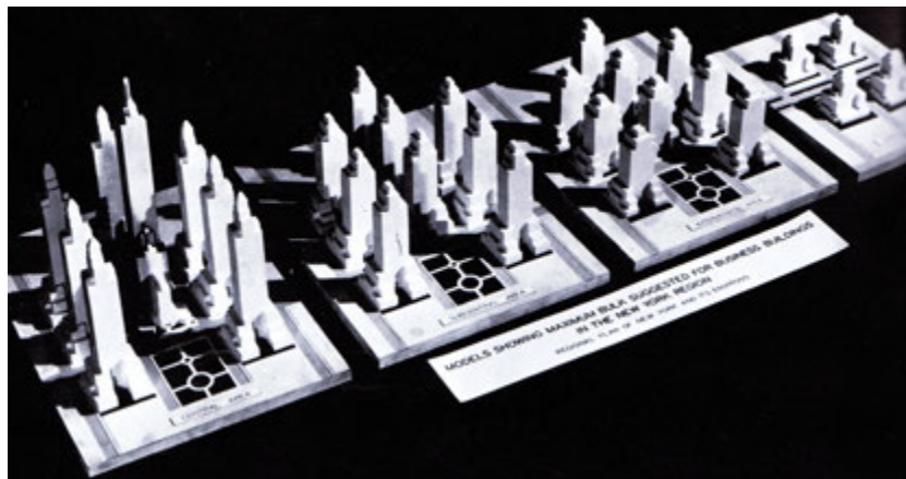
Figura 18.12: Maquetas de la representación de los volúmenes máximos de los edificios comerciales sugeridos por la Zoning Resolution de Nueva York de 1916, de izquierda a derecha: para la zona central, para la que rodea a la central, la intermedia y la suburbana.
