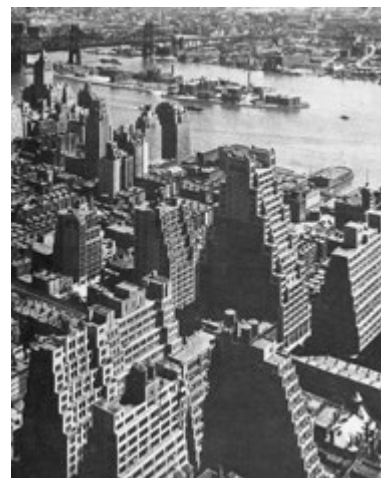
Figura 18.15: Nueva York. Imagen aérea de la materialización de la regulación de retranqueos.
