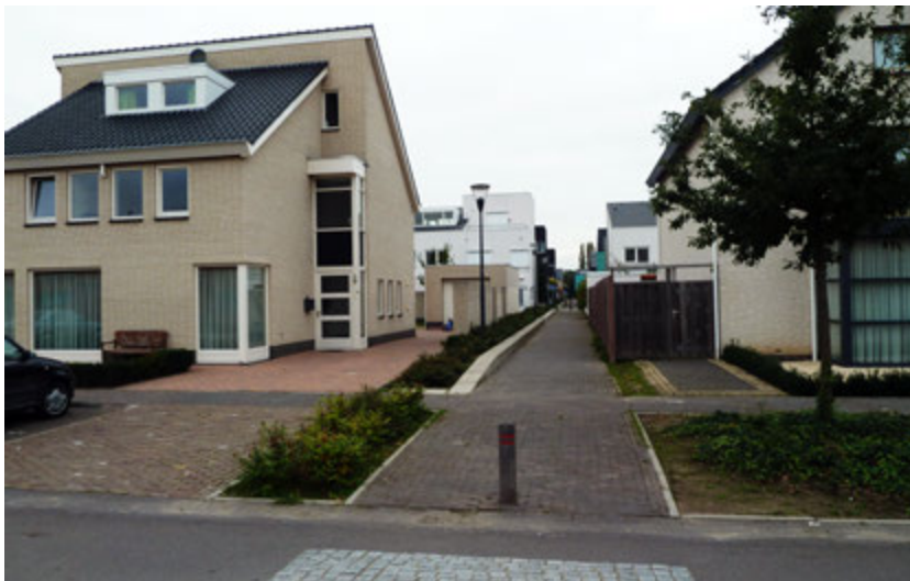
Figura 19.19: Plan Vinex de los Países Bajos. Centro del nuevo barrio Meerhorven. 2010. Política de localización de barrios de «alta densidad» —según los ideales holandeses— en lugares seleccionados por sus condiciones de accesibilidad. Fotografía del tejido peatonal del barrio.
