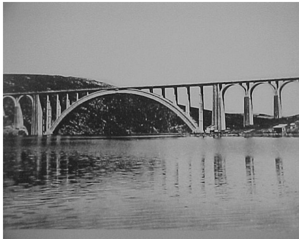
Figura 1.6. Viaducto Martín Gil. Cortesía de la familia Torroja.
