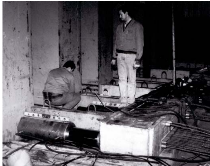
Figura 4.16. Proceso de destesado de la armadura activa en vigas pretensas
