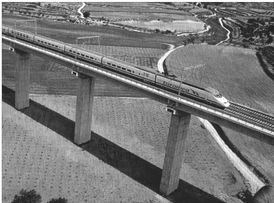
Carga móvil de ferrocarril sobre una estructura. Cortesía de PROINTEC S.A. www.prointec.es
