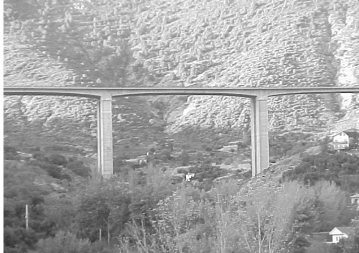
Figura 1.7. Puente de Huétor-Santillán.
