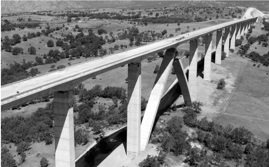
Viaducto Arroyo del Valle. España.
