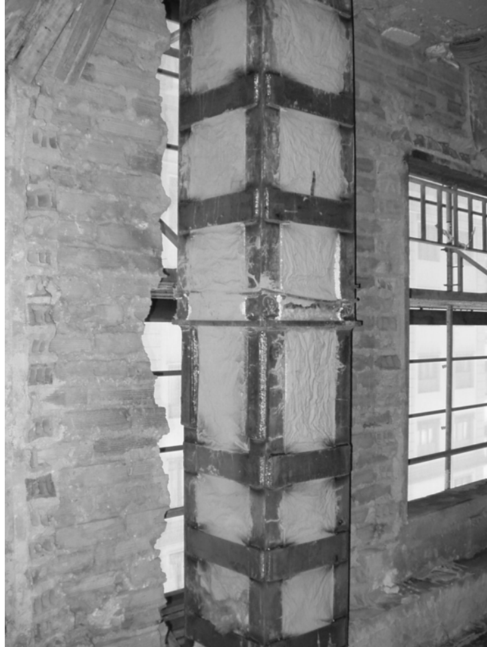
Pilar confinado mediante empresillado metálico Cortesía de DETECSA www.detecea.es
