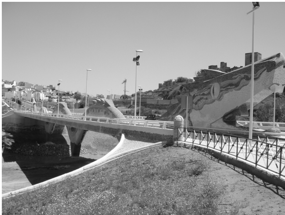
Puente del Dragón sobre el Zacatín. Alcalá de Guadaíra. Sevilla. Cortesía de Brues y Fernández Construcciones S.A. www.bruesa.com
