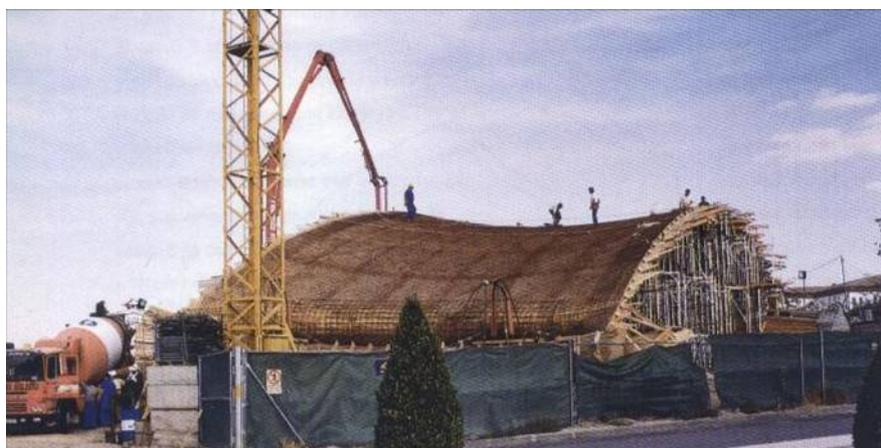
*Imagen del encofrado y armado de la cubierta superior. Imagen de (Jurado Egea & Suzuki, 2004)*
