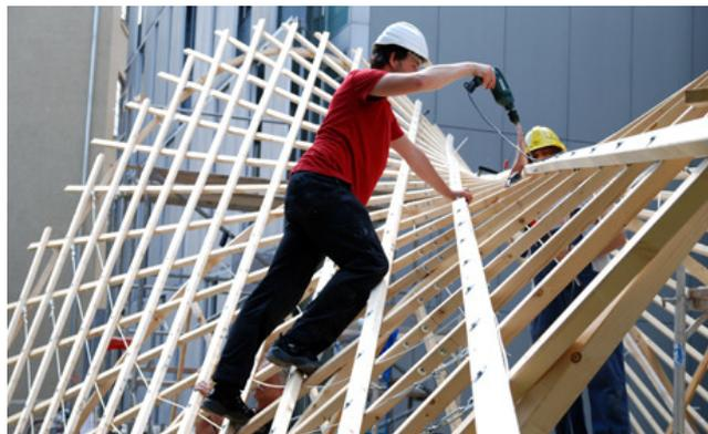
*Operario fijando los rastreles entre sí, montado sobre la propia estructura.*
