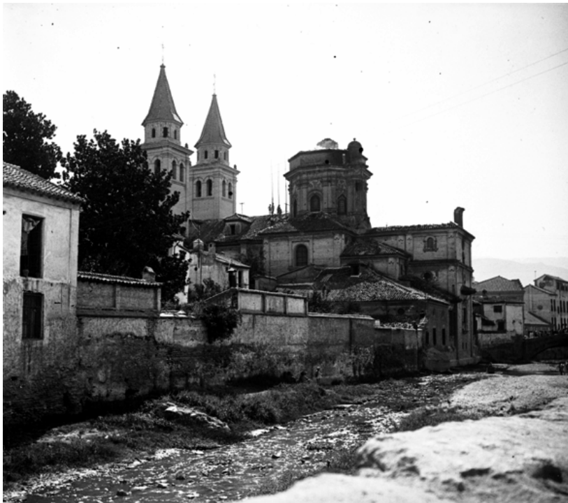
Día despues del incendio
