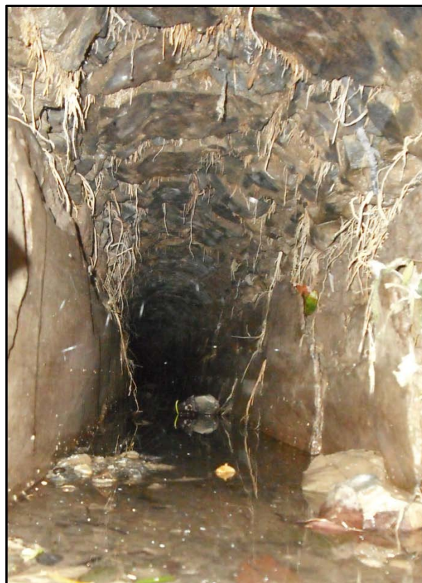
Túnel de La Vegueta.
