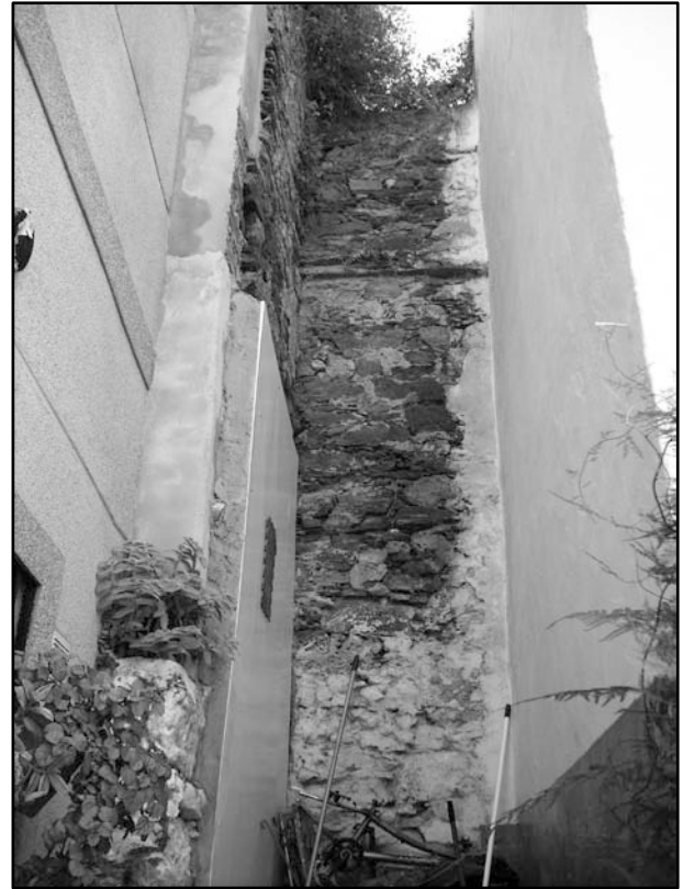
Posible tramo de substructio
