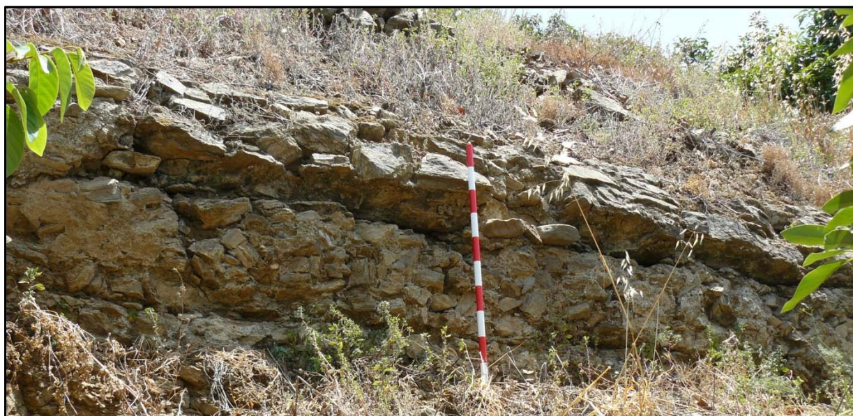
Fotografía de un tramo roto de la conducción de la que se puede deducir el sistema constructivo de la misma
