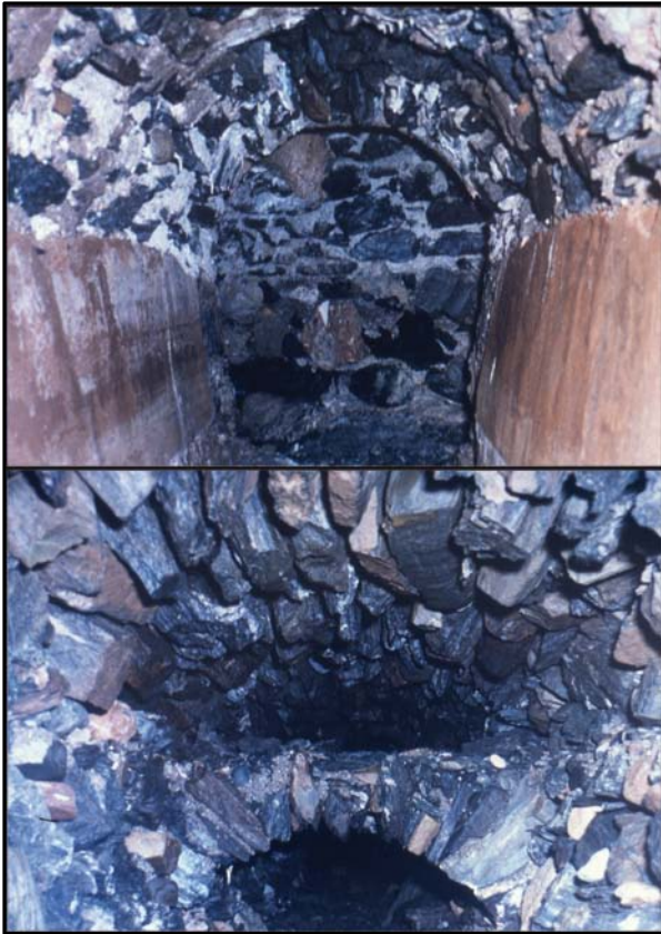
Fotografías del interior de la Galería de Las Angosturas
