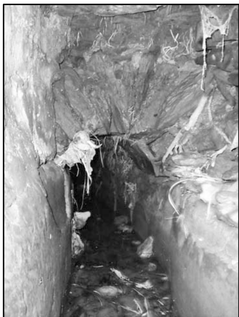
Túnel La Vegueta
