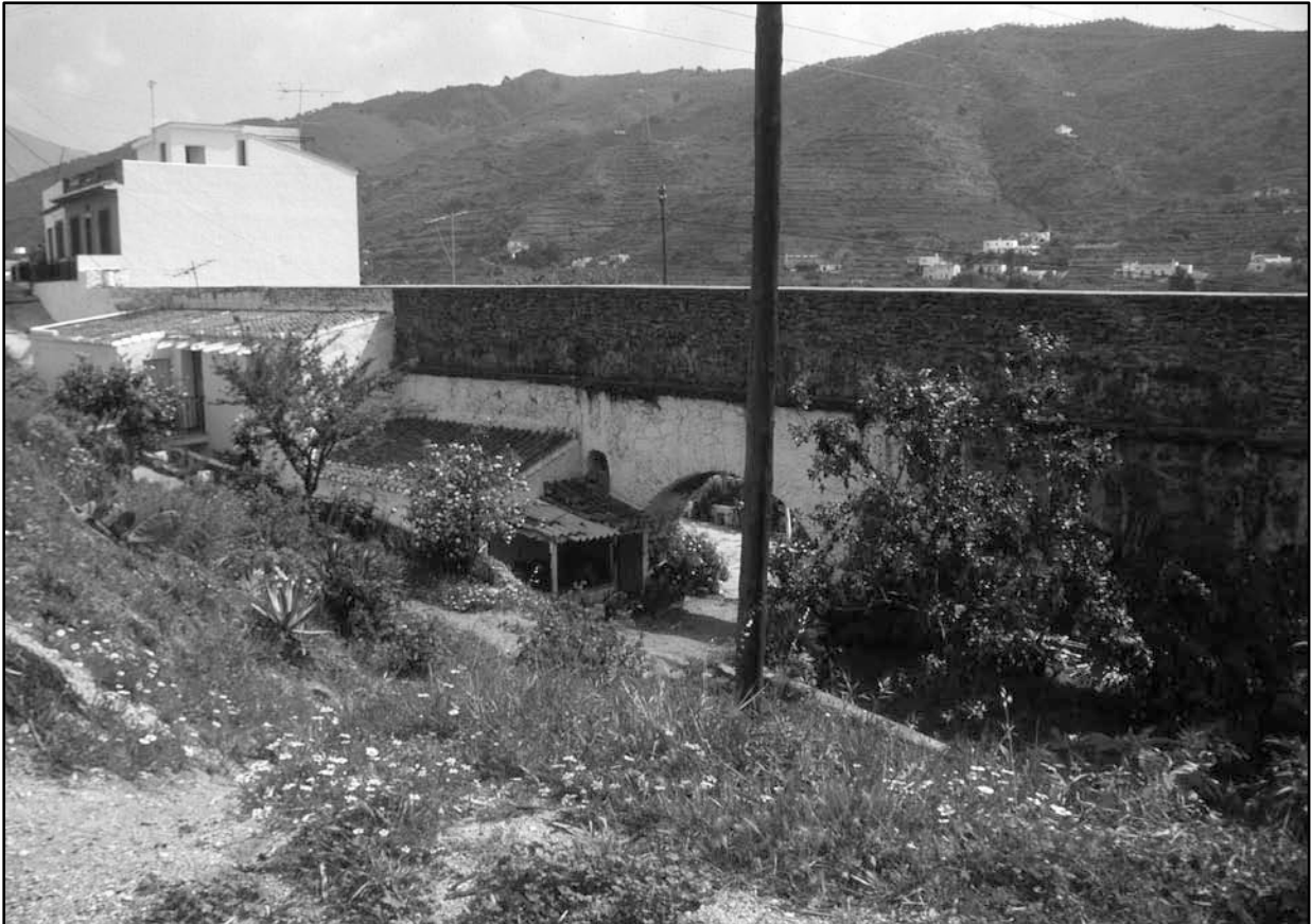
Acueducto de Torrecuevas antes de la apertura de la plaza (fotografía A. Ruiz Fernández)
