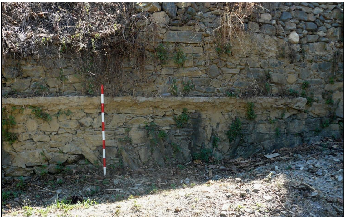
Moldura y clave de arco que evidencian la presencia de una pequeña arcuatio.
