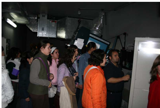
152. Sala de proyección Cinesur (Eroski)
