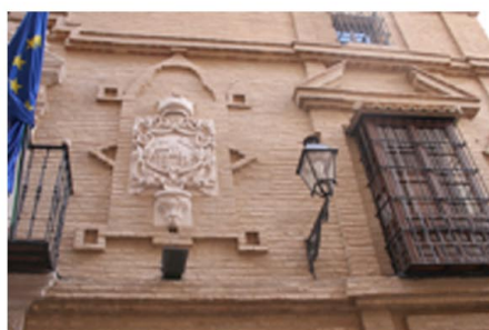
Detalle Fachada casa Conde Pinofiel
