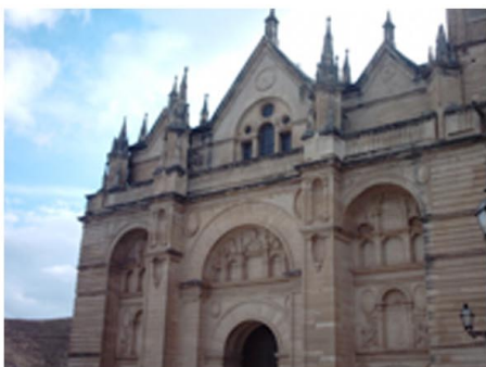
Fachada de Santa María 2007
