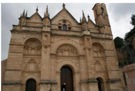
Fachada de Santa María 2008
