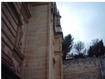
Detalle fachada de Santa María
