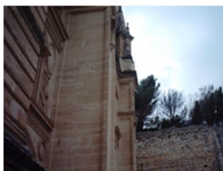
Pilar de la fachada
